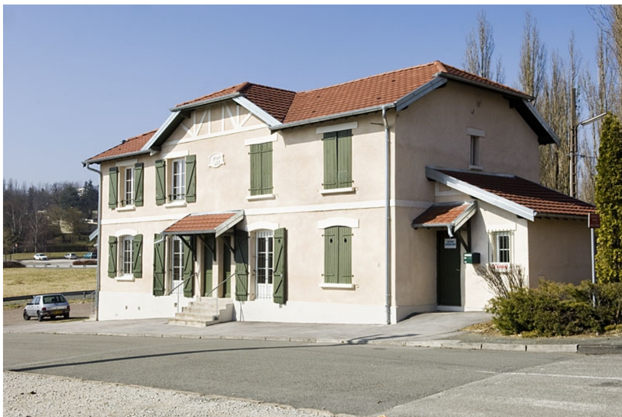
Habitation vue de trois quarts droite.
