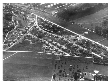
Vue aérienne depuis le nord- ouest. Phot., s.n., s.d. [vers 1930]. Phot. Raphaël Favereaux, Autr. IVR43_20122501540NUC2
