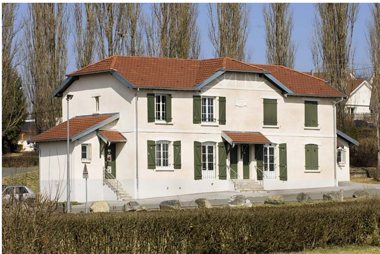
Habitation à 4 logements vue depuis le sud-ouest.
