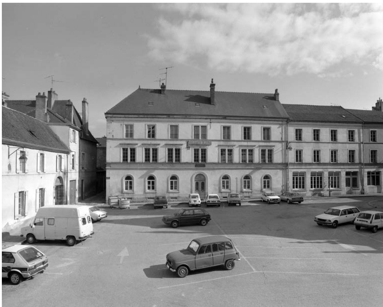
Façade antérieure de face : vue éloignée.
