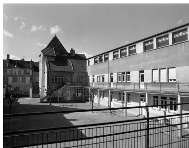
Vue de la cour montrant à l'arrière- plan la maison située 12 rue des Terreaux, acquise au 20E siècle. Phot. Yves Sancey IVR43_19917000149X
