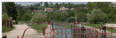
Vue du pont depuis l'amont.
