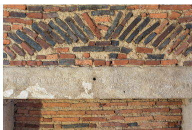
Vue rapprochée : inscription et date portée -1438- sur le couverture d'une cheminée à l'étage. Phot. Pierre-Marie Barbe-Richaud IVR26_20187100369NUC4A
