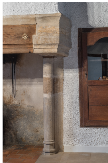
Vue rapprochée du piedroit droit de la cheminée du rez-de-chaussée. Phot. Pierre-Marie Barbe-Richaud IVR26_20187100365NUC4A
