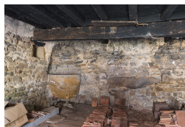
Vue intérieure de la dépendance. Face au mur postérieur sud. Phot. Pierre-Marie Barbe-Richaud IVR26_20187100380NUC4A
