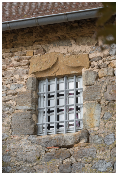
Détail de la baie ouest à l'étage de la façade postérieure. Phot. Pierre-Marie Barbe-Richaud IVR26_20187100363NUC4A
