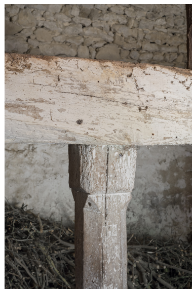
Vue rapprochée d'un assemblage poutre-poteau. Phot. Pierre-Marie Barbe-Richaud IVR26_20187100374NUC4A
