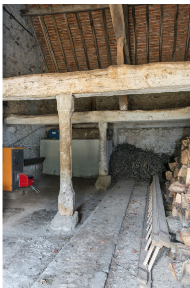
Vue intérieure de l'étable : poteaux sculptés. Phot. Pierre-Marie Barbe-Richaud IVR26_20187100373NUC4A
