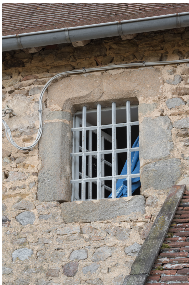
Détail de la baie est à l'étage de la façade postérieure. Phot. Pierre-Marie Barbe-Richaud IVR26_20187100364NUC4A
