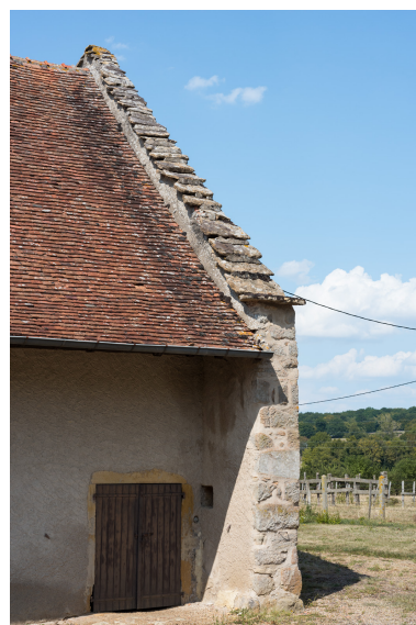
Vue rapprochée du pignon est de la partie agricole. Phot. Pierre-Marie Barbe-Richaud IVR26_20187100371NUC4A
