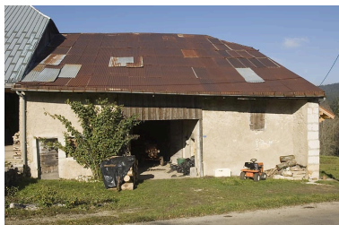
Façade antérieure. Phot. Jérôme Mongreville IVR43_20082500861NUC2A
