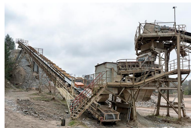
Nouvelles installations : tapis roulants.
