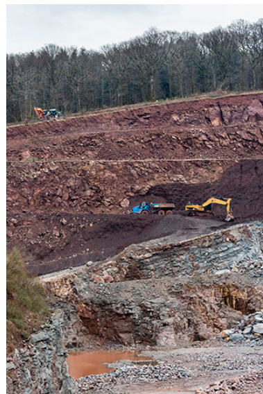
Carrière : découverte à la pelle mécanique. Phot. Sonia Dourlot IVR43_20203900021NUC4A
