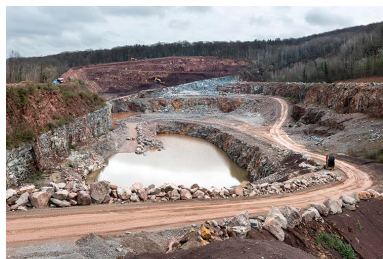
Vue d'ensemble de la carrière, depuis l'ouest. Phot. Sonia Dourlot IVR43_20203900019NUC4A
