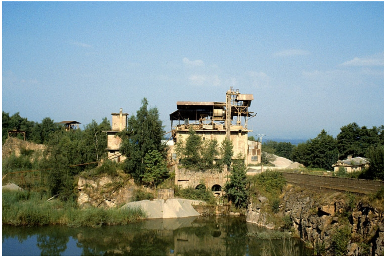
Vue d'ensemble, depuis l'est, en 1988. Etang au premier plan, poste de lavage (C) au centre, bureau (A) à droite, anciennes installations à gauche.
