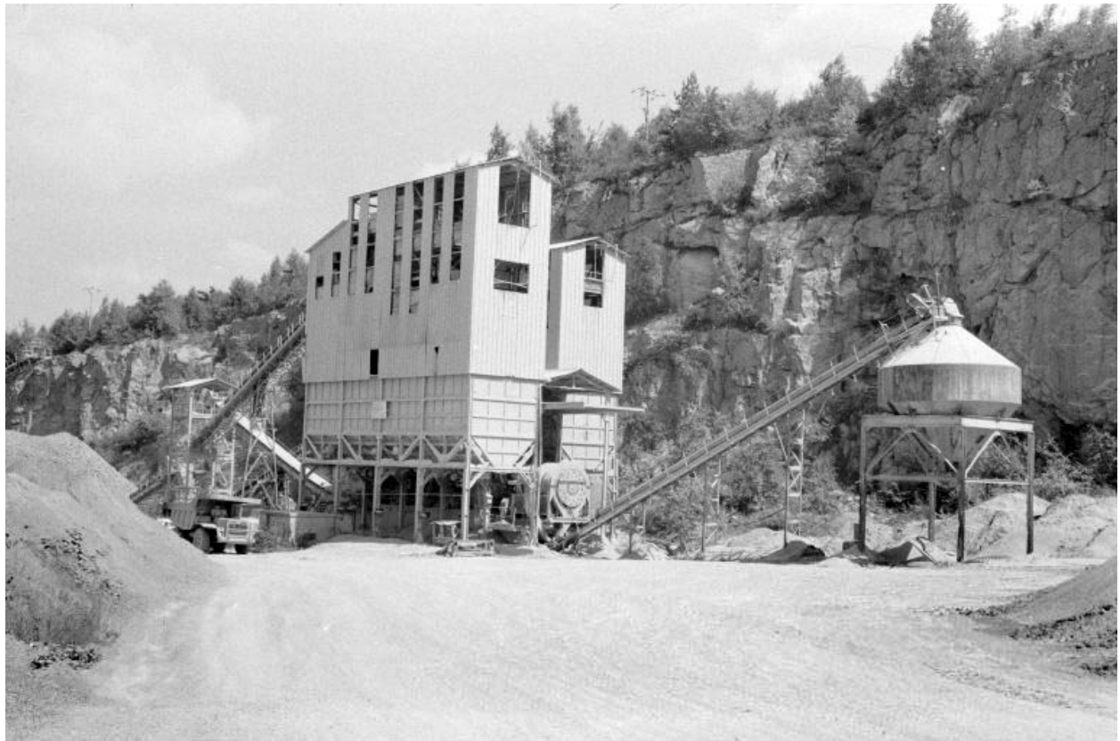
Nouvelles installations de concassage, en 1988.
