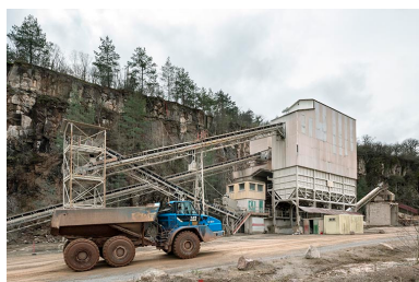
Nouvelles installations : poste de concassage, avec camion.
