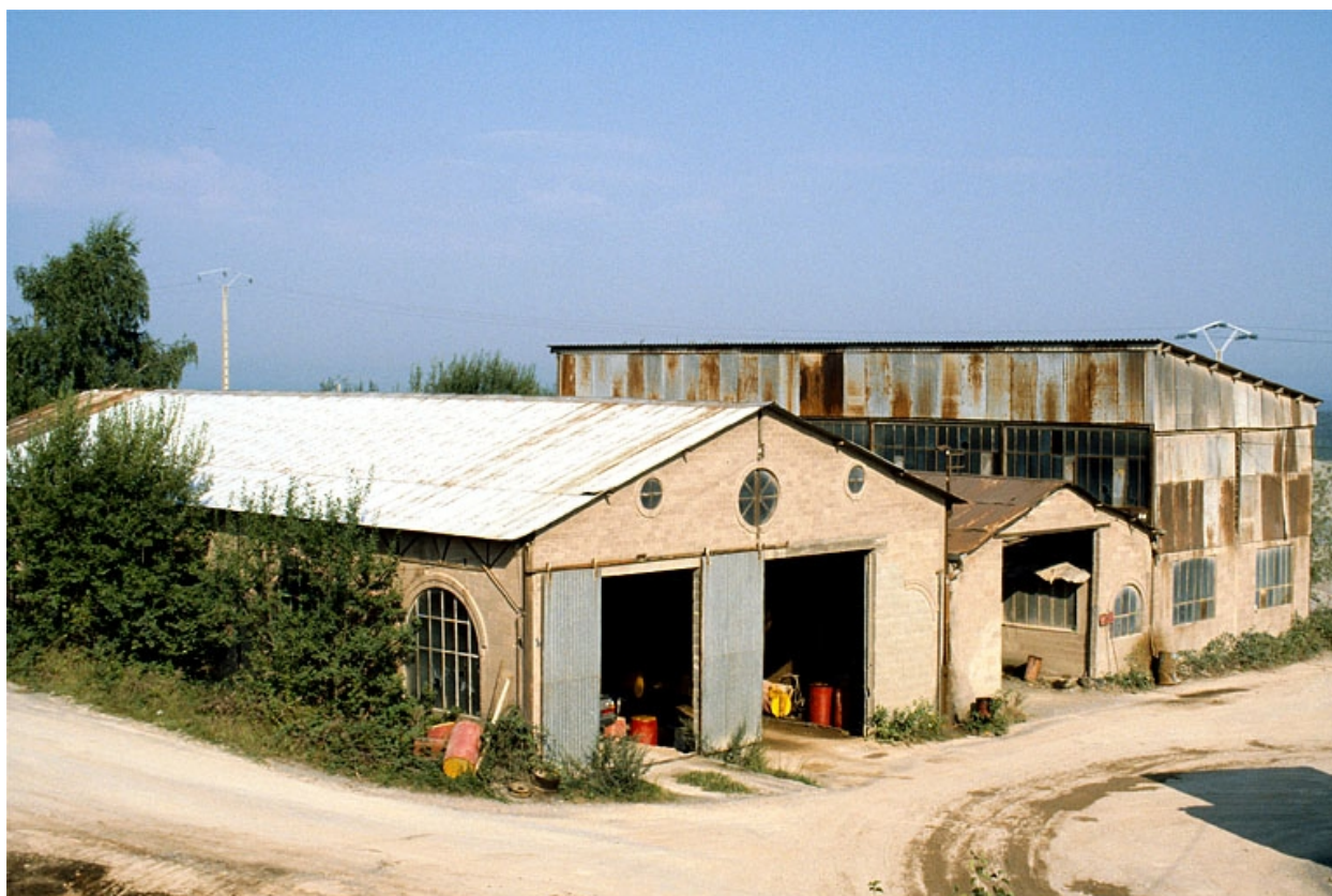
Hangar (G) vu du sud-est, en 1988.
