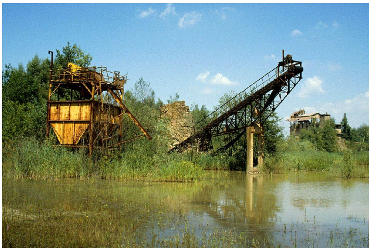
Anciennes installations vues de l'ouest, en 1988.
