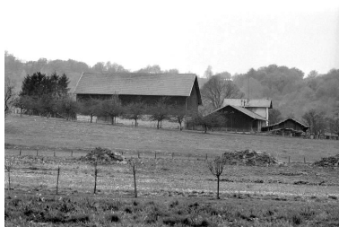
Façades latérales gauches.
