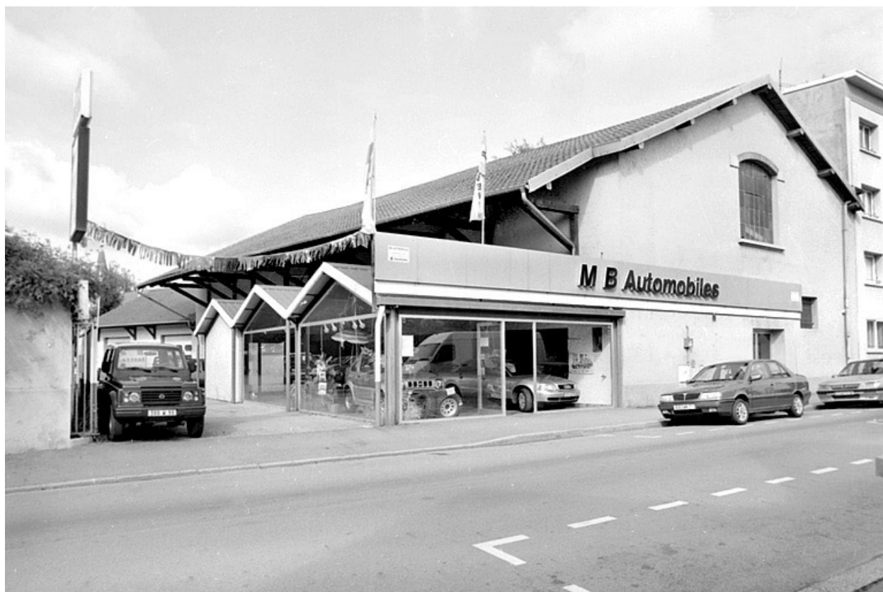
Ancienne entrée et magasin industriel.
