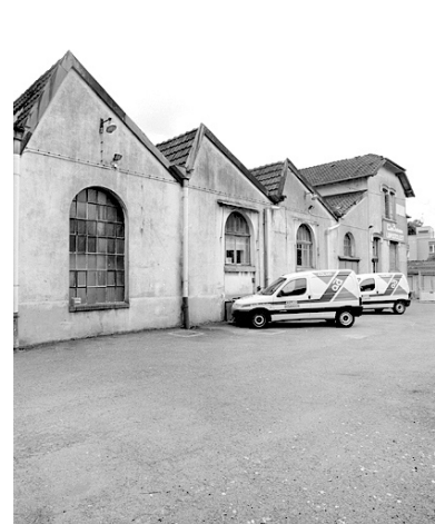
Murs-pignons ouest des ateliers depuis la cour. Phot. Yves Sancey IVR43_20009000632X
