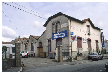
Ateliers et bureaux (?) depuis la rue. Phot. Yves Sancey IVR43_20009000627ZA
