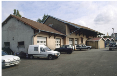
Magasin industriel depuis la cour. Phot. Yves Sancey IVR43_20009000639ZA
