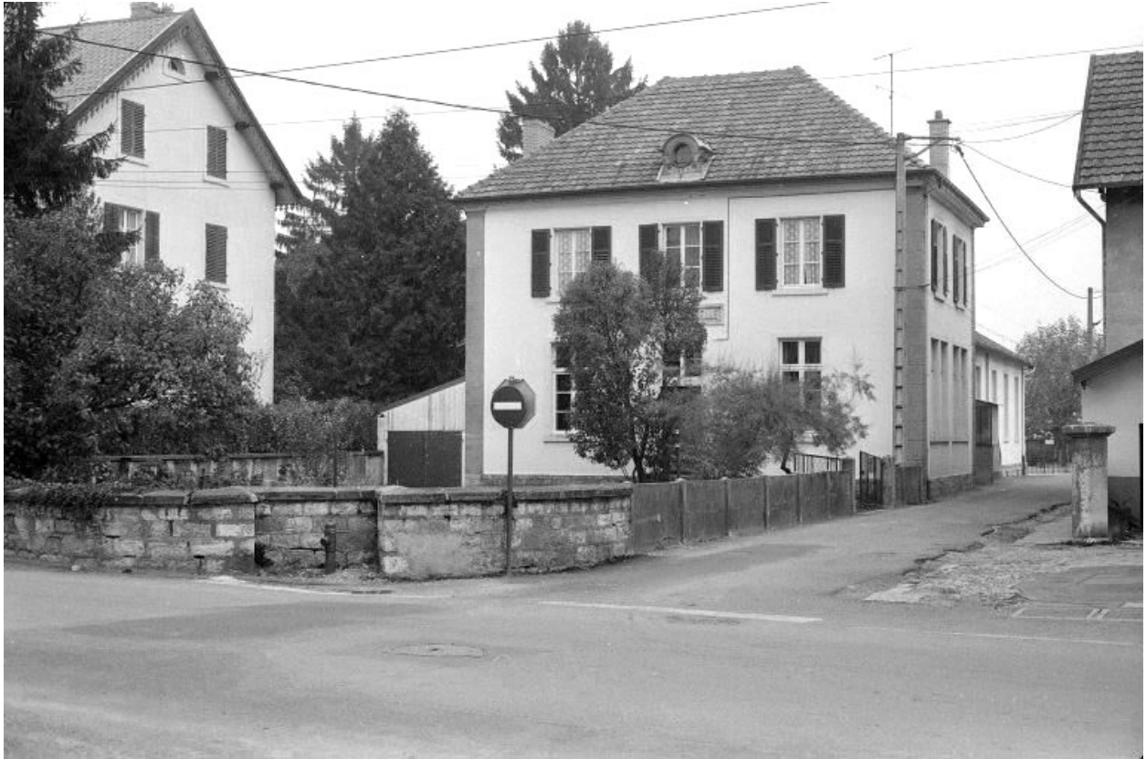
Façades antérieure et latérale droite.
