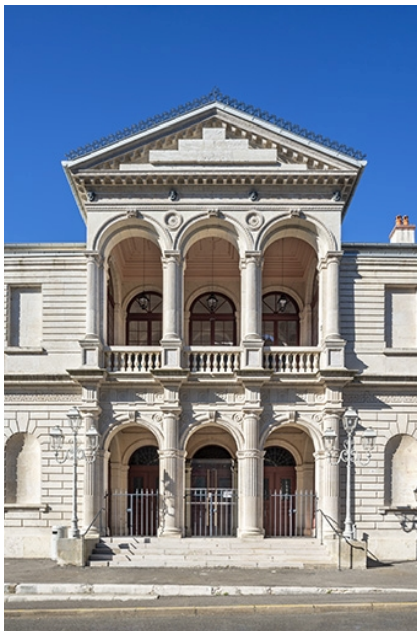
Façade antérieure : travées centrales.
