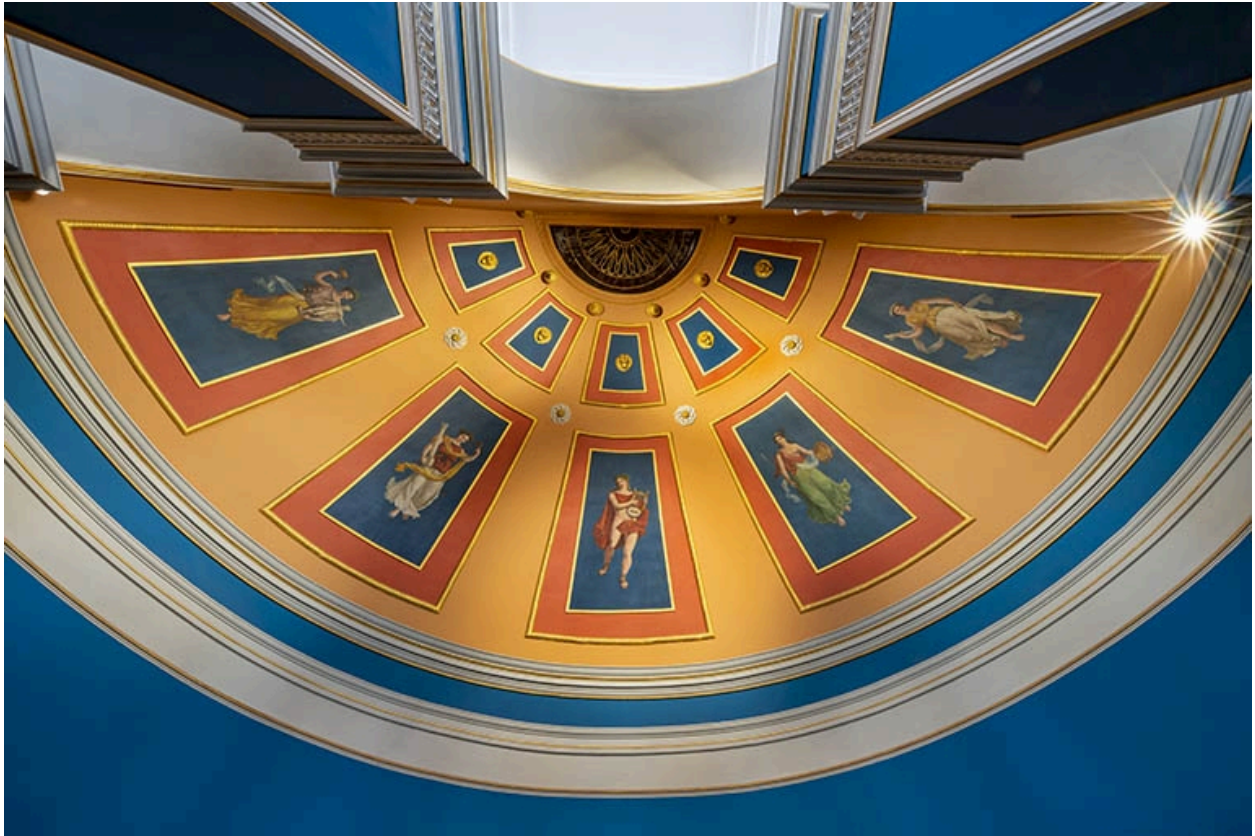
Foyer : fausse-voûte en cul-de-four de l'antichambre.
