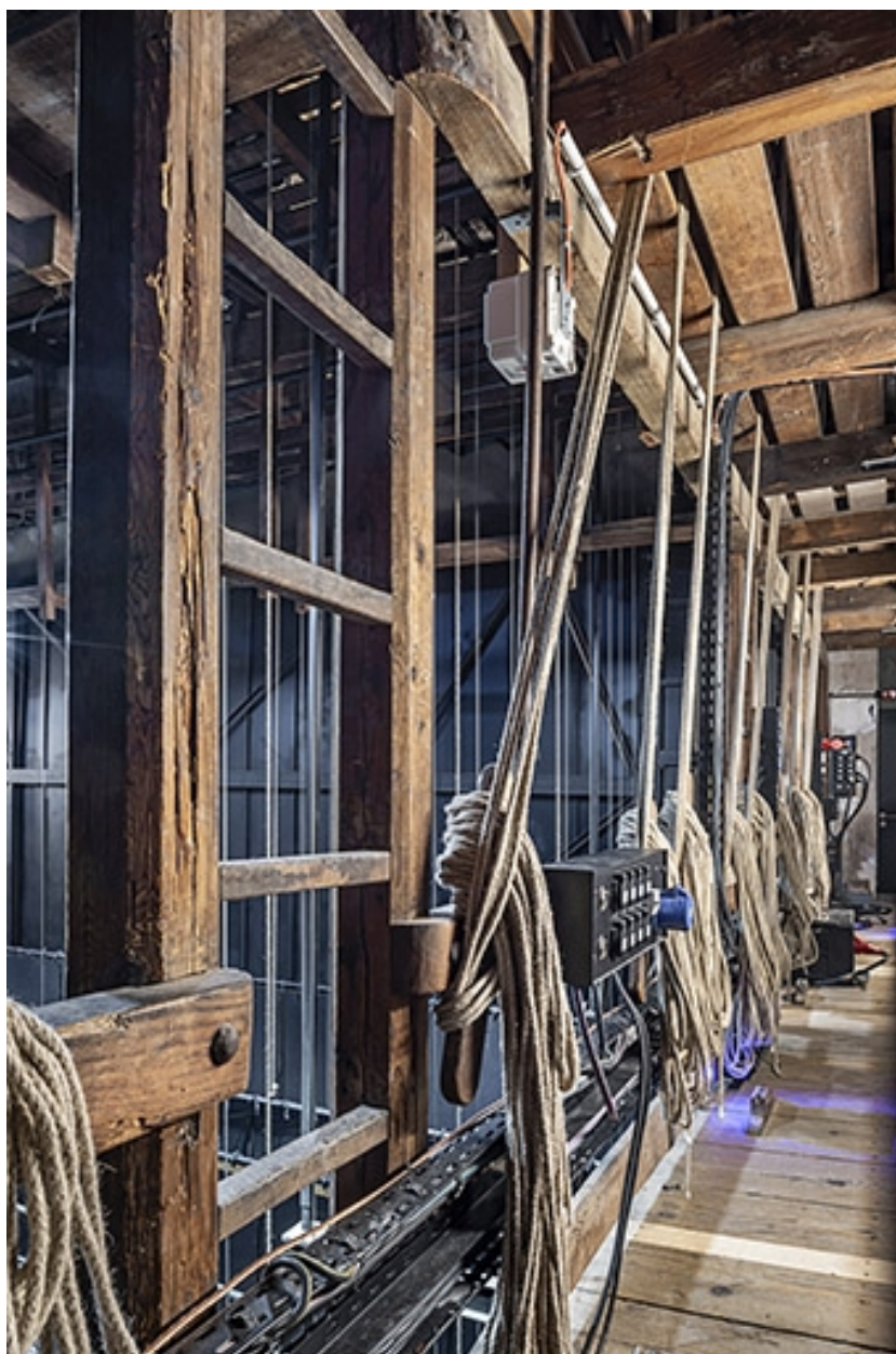
Cage de scène : passerelle côté cour (cadrage vertical).
