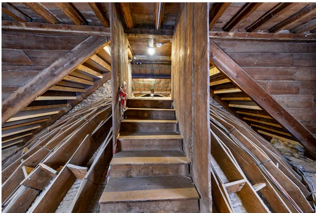
Foyer : extrados de la fausse-voûte en cul-de-four de l'antichambre, dans le comble.
