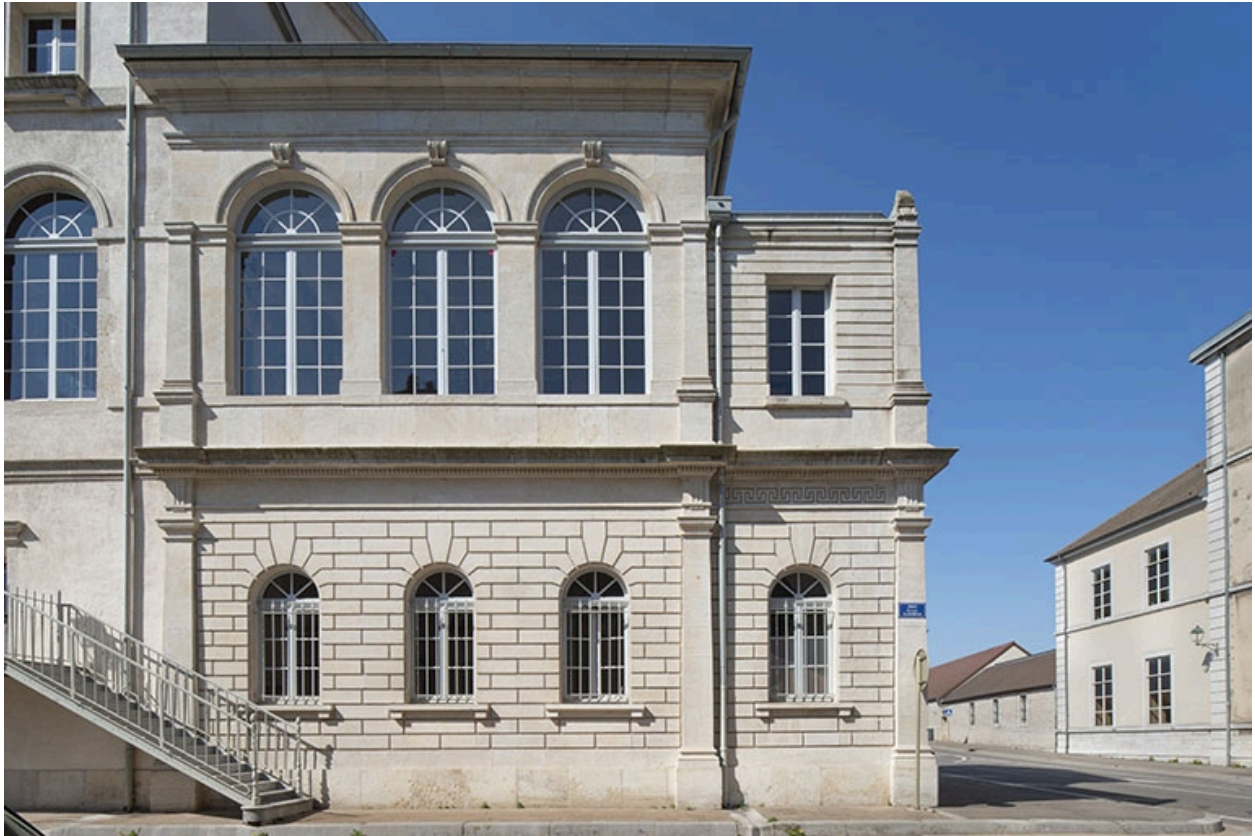
Corps d'entrée : façade latérale gauche.
