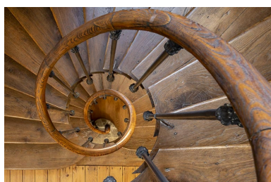
Vestibule : escalier latéral (côté jardin) desservant la loggia, vu du haut. Phot. Jérôme Mongreville IVR43_20223900167NUC4A
