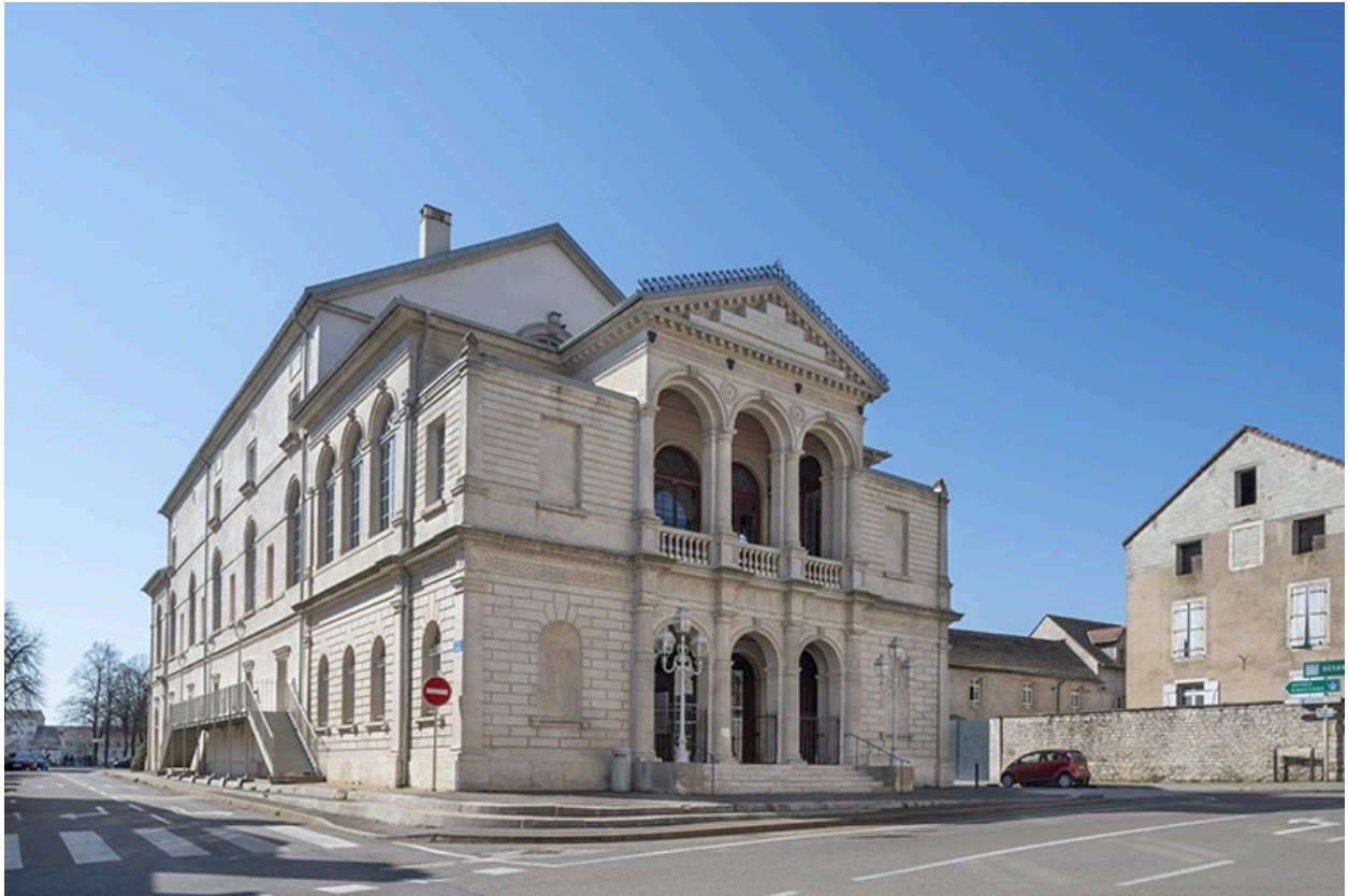
Façades antérieure et latérale gauche.
