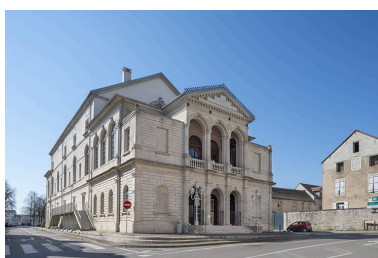
Façades antérieure et latérale gauche. Phot. Jérôme Mongreville IVR43_20223900707NUC4A
