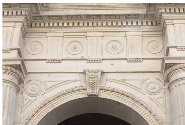
Façade antérieure, rez-de- chaussée : entablement. Phot. Jérôme Mongreville IVR43_20223900728NUC4A
