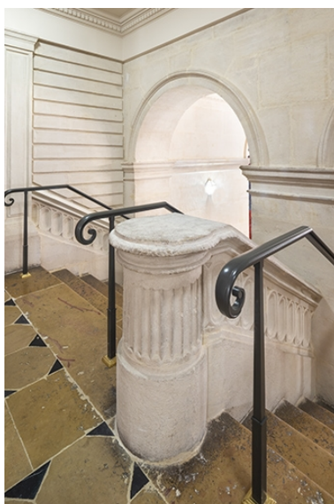
Vestibule, palier de l'escalier : départ de rampe. Phot. Jérôme Mongreville IVR43_20223900158NUC4A
