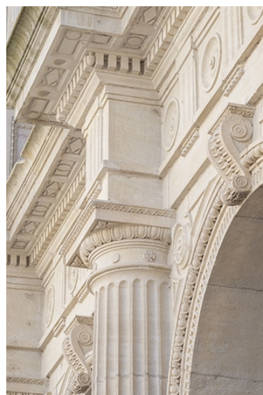
Façade antérieure, rez-de- chaussée : chapiteau et morceau d'entablement, vus de trois quarts. Phot. Jérôme Mongreville IVR43_20223900726NUC4A
