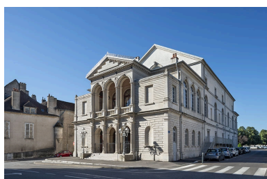
Façades antérieure et latérale droite. Phot. Jérôme Mongreville IVR43_20223900704NUC4A
