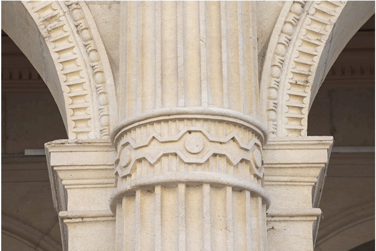
Façade antérieure, rez-de-chaussée : bague de colonne.
