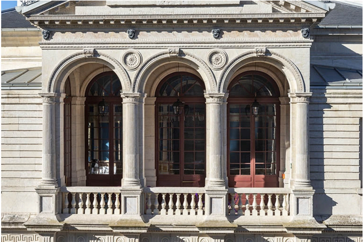
Façade antérieure, étage : baies de la loggia.
