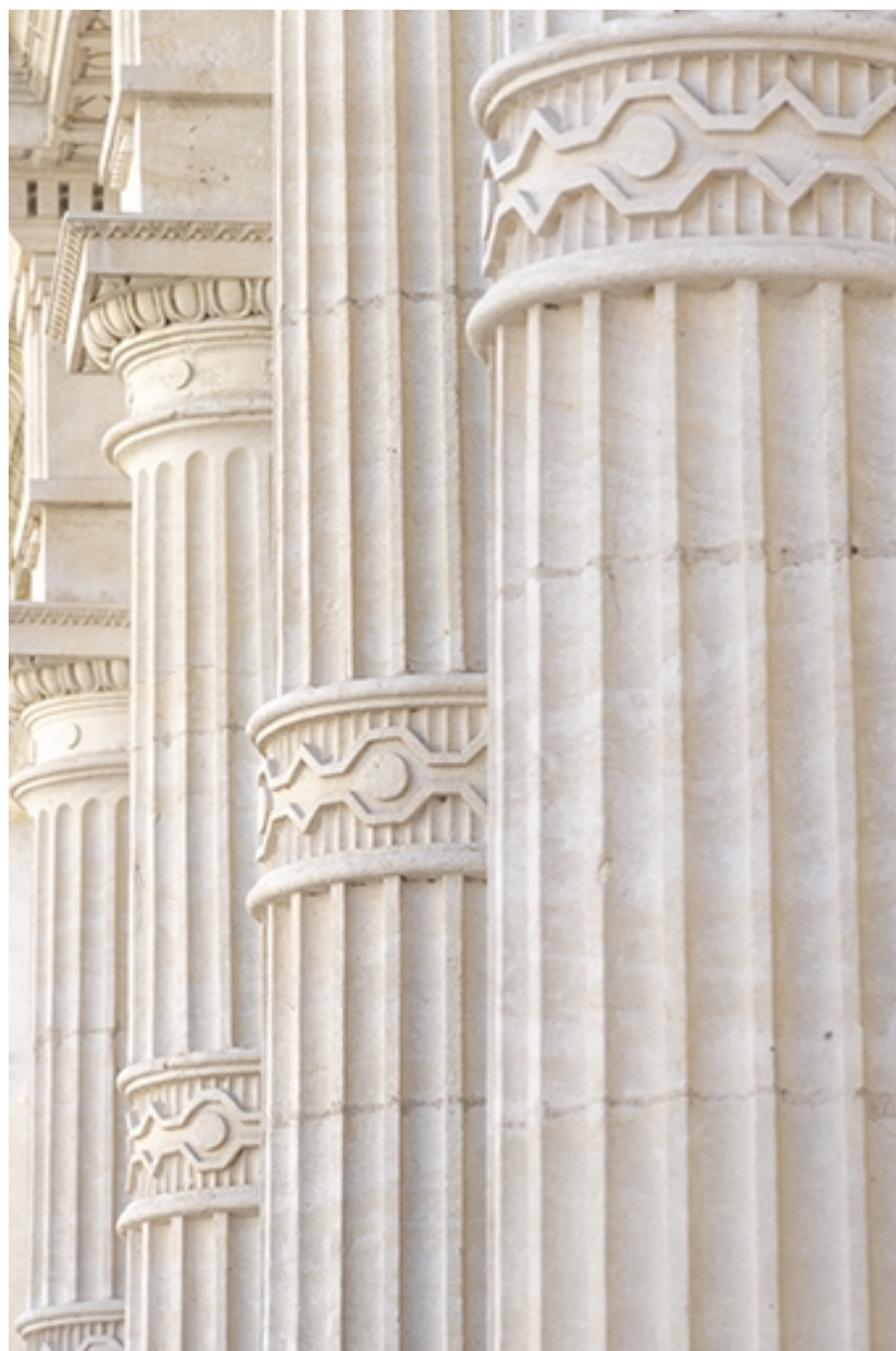
Façade antérieure, rez-de-chaussée : détail des colonnes, vues en enfilade.
