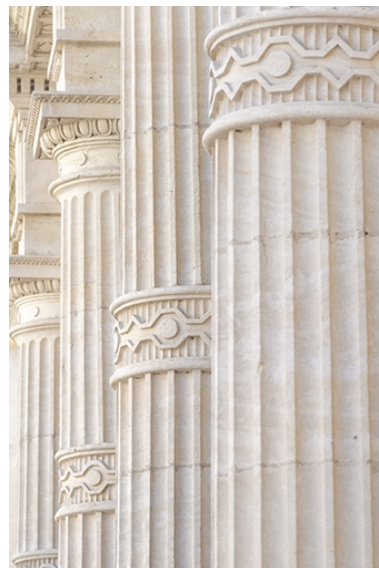
Façade antérieure, rez-de-chaussée : détail des colonnes, vues en enfilade. Phot. Jérôme Mongreville IVR43_20223900725NUC4A
