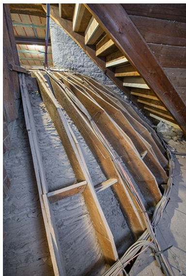
Foyer : extrados de la fausse-voûte en cul-de-four de l'antichambre (côté jardin), dans le comble.
