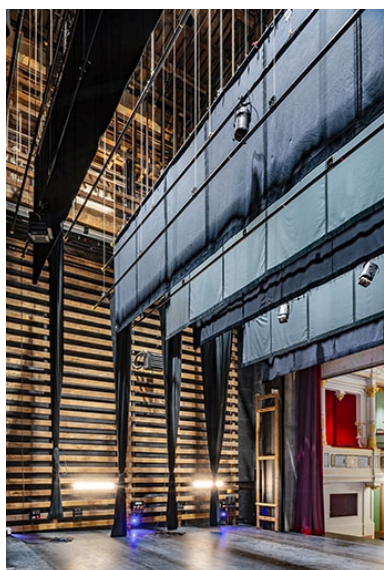
Cage de scène : cheminée de contreponds côté cour, pendrillons et frises. Phot. Jérôme Mongreville
