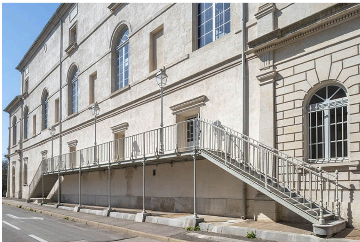
Corps central : façade latérale gauche.
