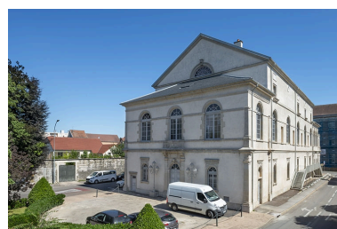
Façades postérieure et latérale gauche. Phot. Jérôme Mongreville IVR43_20223900706NUC4A
