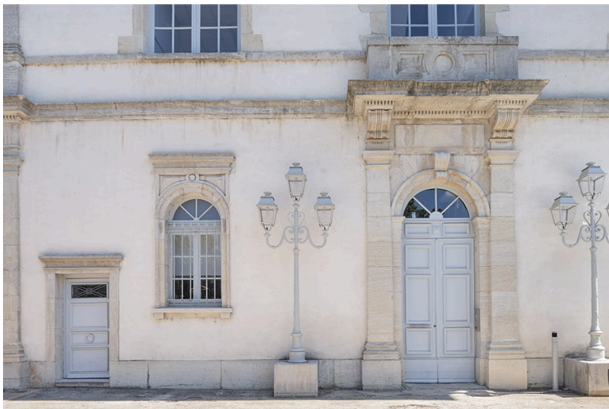
Façade postérieure : baies au rez-de-chaussée.
