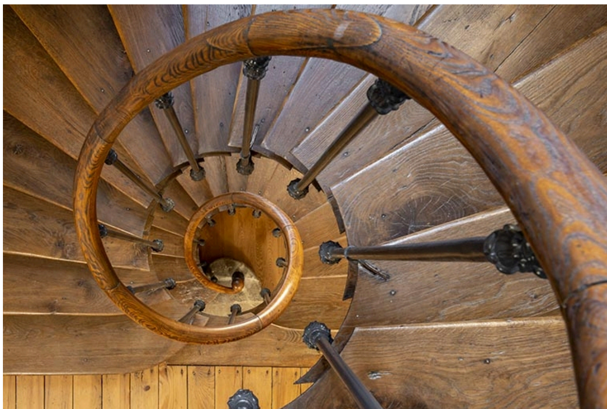
Vestibule : escalier latéral (côté jardin) desservant la loggia, vu du haut.
