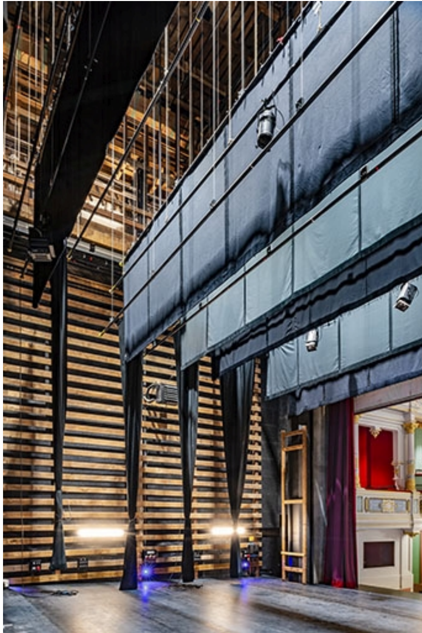
Cage de scène : cheminée de contreponds côté cour, pendrillons et frises.
