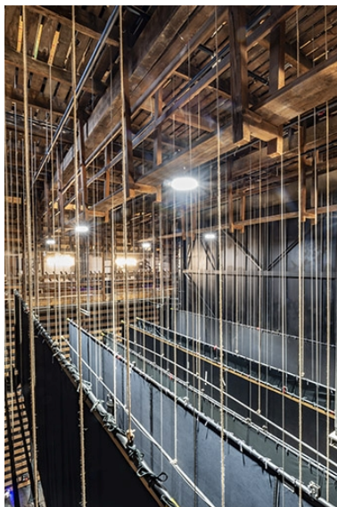
Cage de scène : cintres, vus de la passerelle côté jardin (cadre vertical). Phot. Jérôme Mongreville IVR43_20223900256NUC4A
