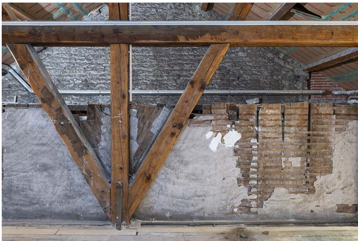
Salle : paroi en bois isolant le 4e balcon (poulailler) du comble.
