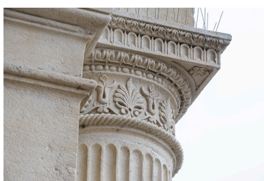
Loggia : décor du chapiteau d'une colonne. Phot. Jérôme Mongreville IVR43_20223900199NUC4A
