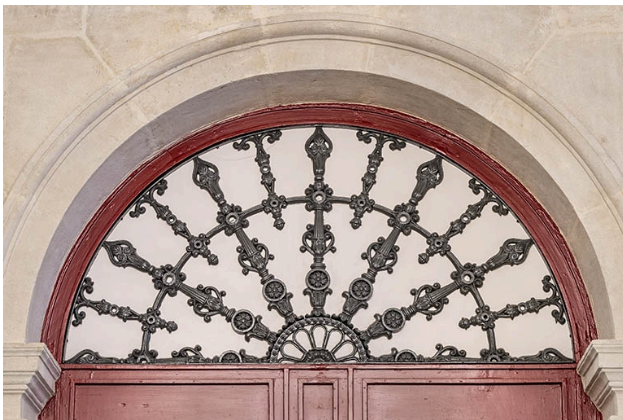
Vestibule, porte côté cour : grille en fonte du tympan.
