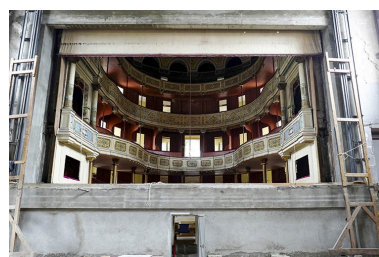
Cadre de scène et salle vus du dessous en cours de restauration, en 2020. Autr. Yves Regaldi IVR43_20223900689NUC4A
