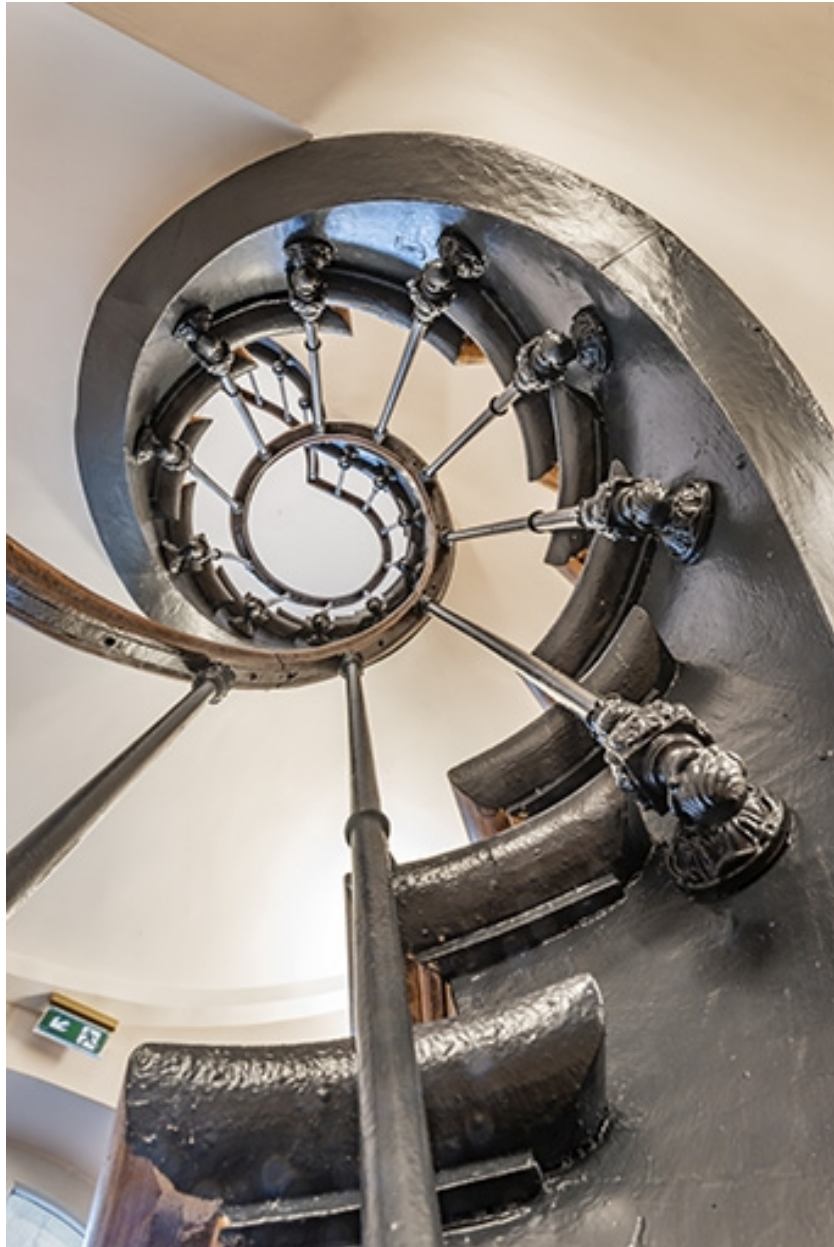
Vestibule : escalier latéral (côté jardin) desservant la loggia, vu du bas.
