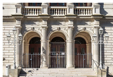
Façade antérieure : baies du rez-de-chaussée. Phot. Jérôme Mongreville IVR43_20223900715NUC4A
