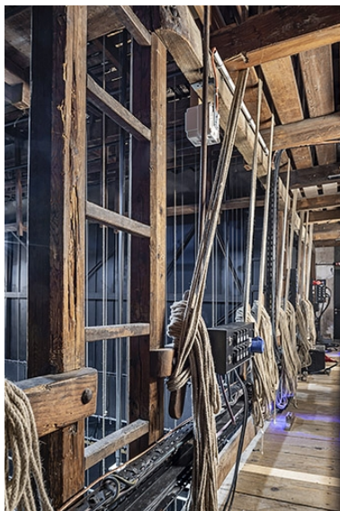
Cage de scène : passerelle côté cour (cadrage vertical). Phot. Jérôme Mongreville IVR43_20223900252NUC4A
