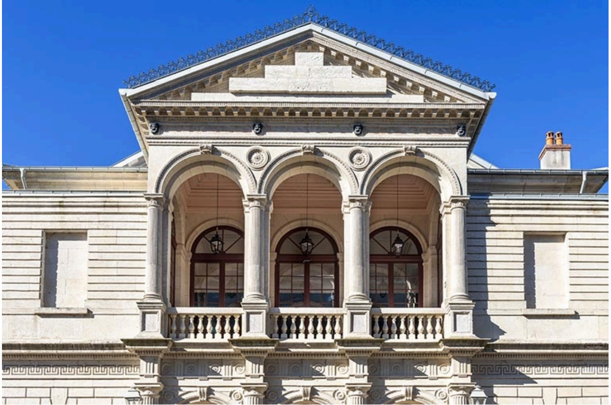
Façade antérieure : loggia, vue en contre-plongée.
