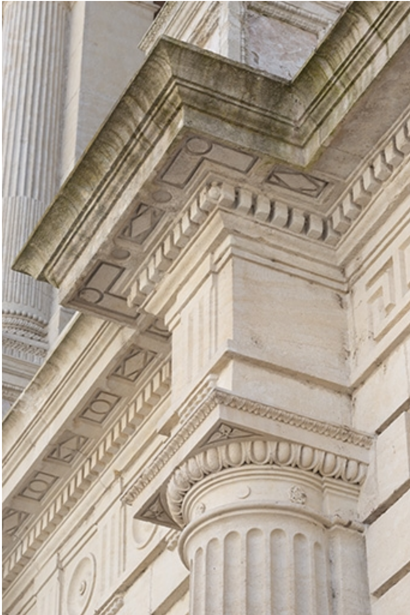
Façade antérieure, rez-de-chaussée : chapiteau et morceau d'entablement, vus de trois quarts (vue rapprochée).
