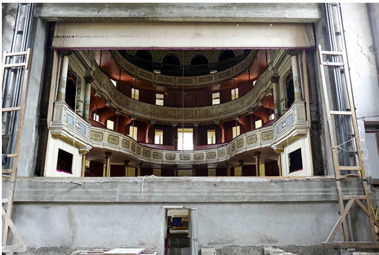
Cadre de scène et salle vus du dessous en cours de restauration, en 2020.
