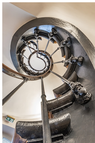
Vestibule : escalier latéral (côté jardin) desservant la loggia, vu du bas. Phot. Jérôme Mongreville IVR43_20223900168NUC4A
