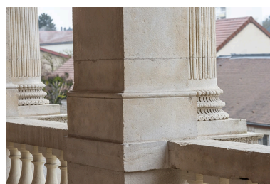
Loggia : base d'un pilier et de colonnes. Les balustrades du garde-corps sont en fonte. Phot. Jérôme Mongreville IVR43_20223900201NUC4A
