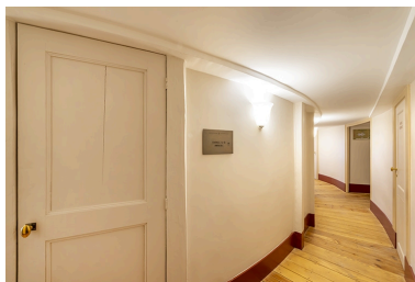
Salle : couloir desservant les loges du 3e balcon. Phot. Jérôme Mongreville IVR43_20223900151NUC4A
