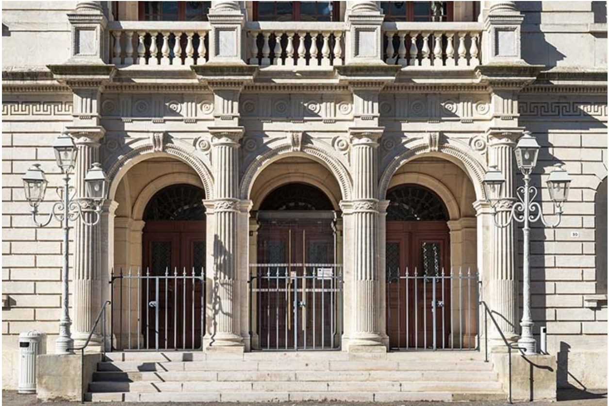
Façade antérieure : baies du rez-de-chaussée.
