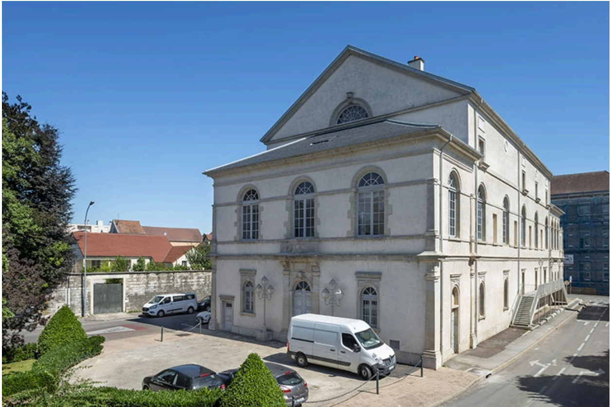
Façades postérieure et latérale gauche.
