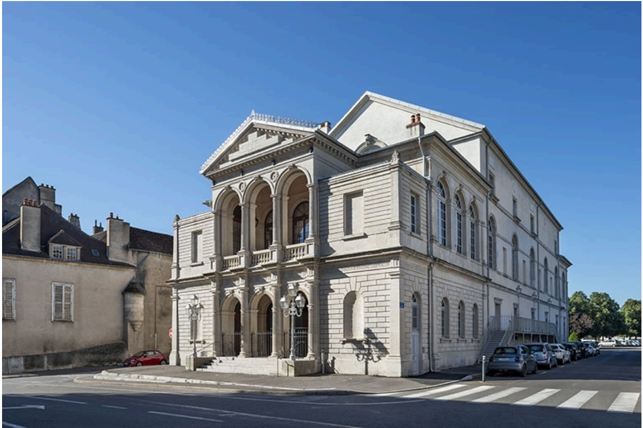
Façades antérieure et latérale droite.
