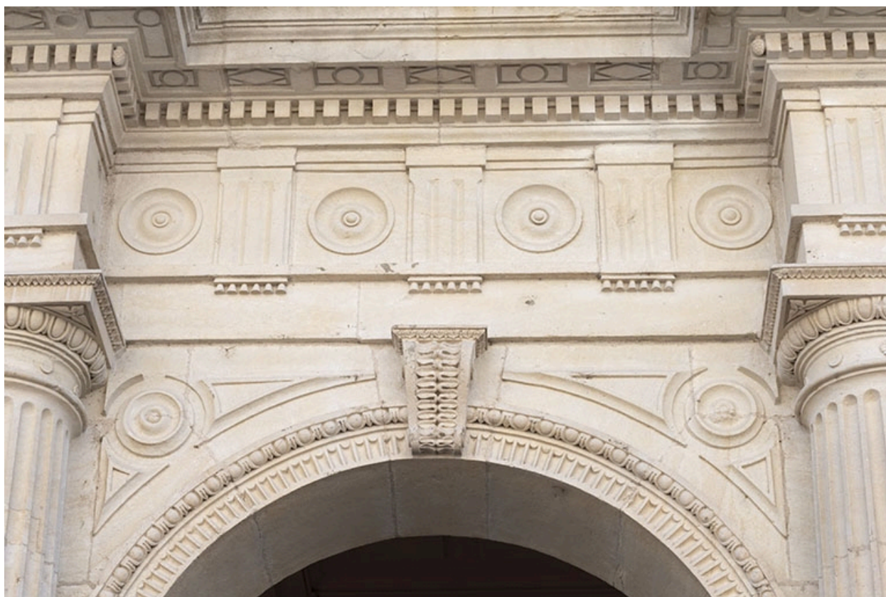
Façade antérieure, rez-de-chaussée : entablement.
