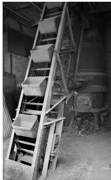
Chargeur à godets du grand cubilot (5 tonnes). Phot. Rémi Hamelin IVR43_20107000027NUC2A
