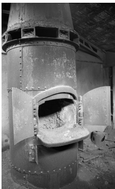
Partie supérieure du petit cubilot. Phot. Rémi Hamelin IVR43_20107000030NUC2A
