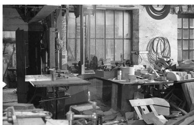
Vue partielle de l'atelier de menuiserie. Phot. Rémi Hamelin IVR43_20107000035NUC2A
