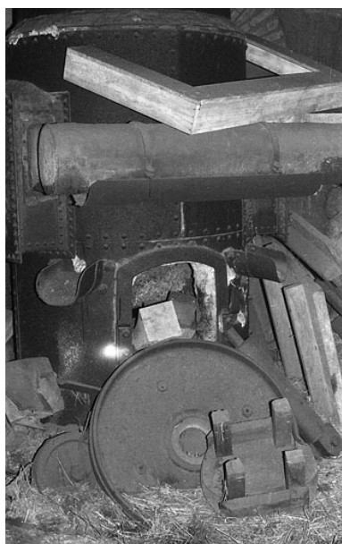
Base du petit coulée cubilot (3,5 tonnes). Phot. Rémi Hamelin IVR43_20107000024NUC2A
