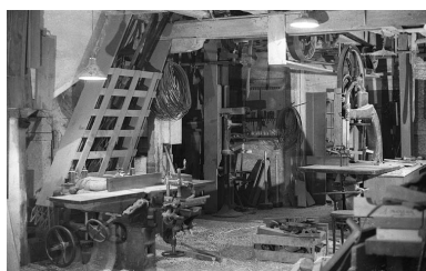
Atelier de menuiserie. Phot. Rémi Hamelin IVR43_20107000036NUC2A
