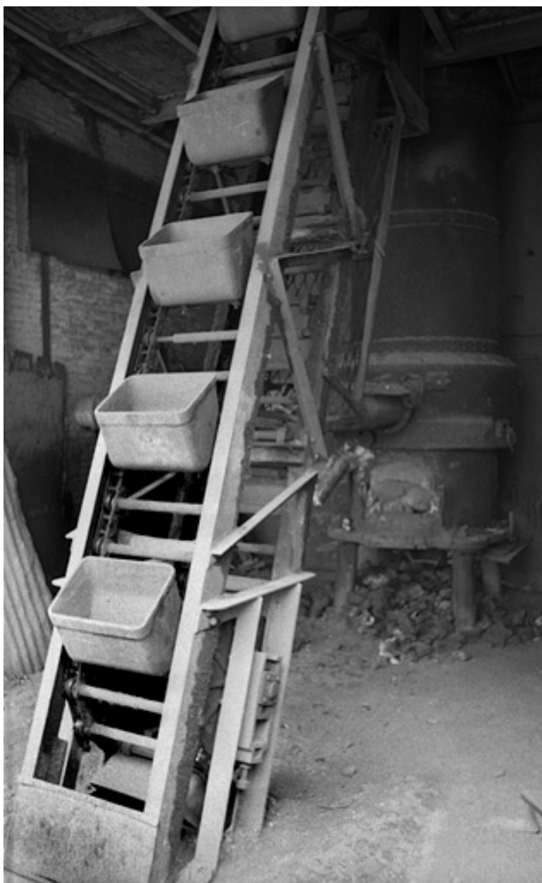
Chargeur à godets du grand cubilot (5 tonnes).
