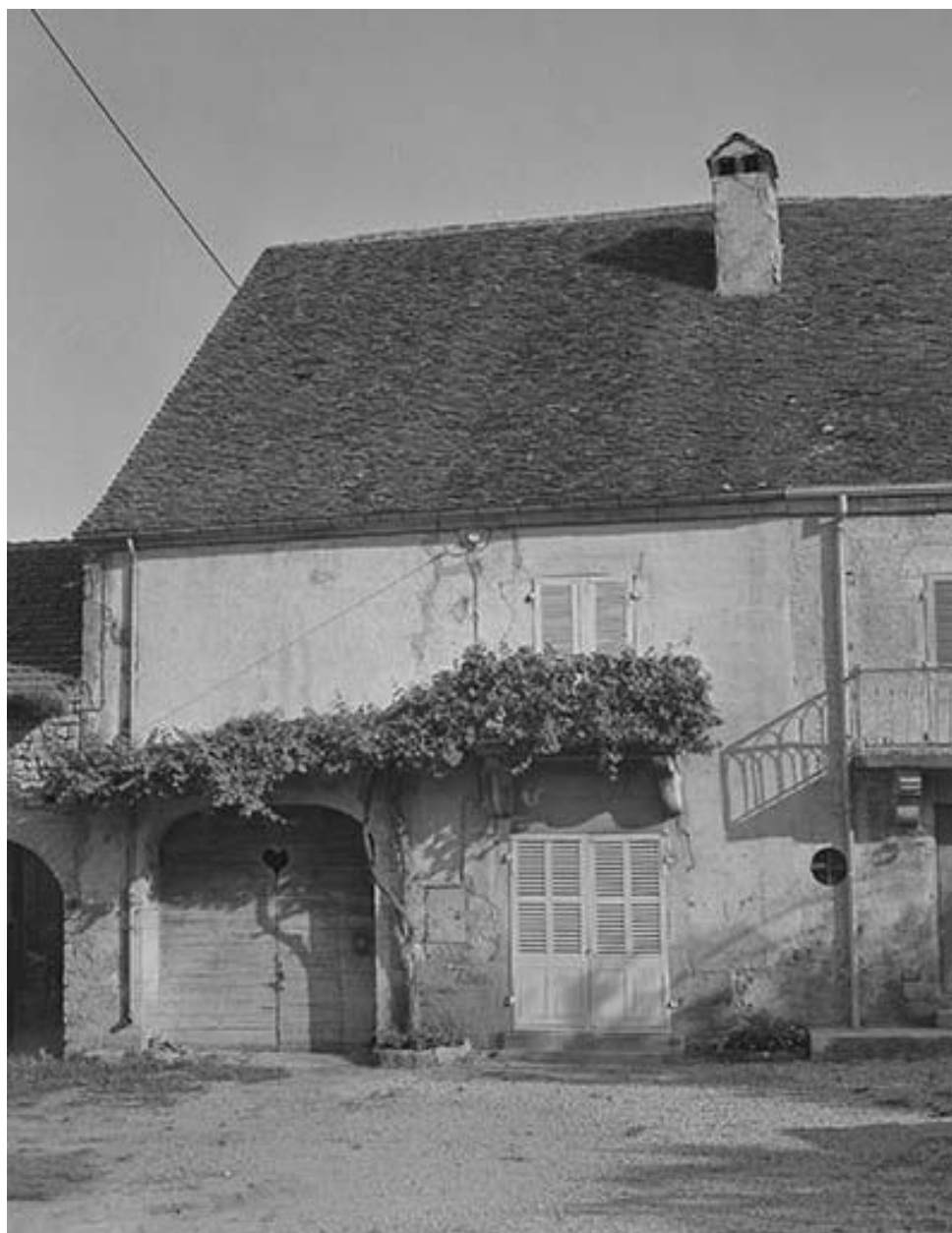
Façade antérieure, partie gauche
