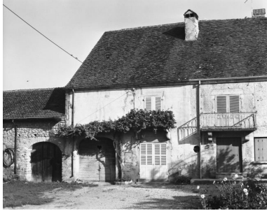
Façade antérieure. Phot. Dominique Dominguez IVR43_19803900020X
