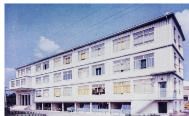
Exemple de construction dans les années 1950 : immeuble servant de siège à la C.M.F., à Florange (Moselle).
