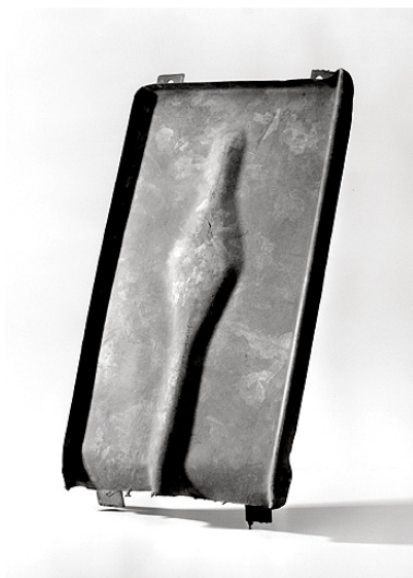
Tuile métallique Fillod brevetée : face supérieure. Phot. Yves Sancey IVR43_19943901693V
