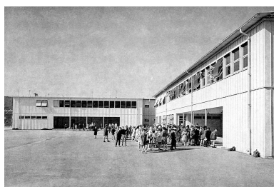
Exemple de construction au début des années 1960 : école (non localisée).
