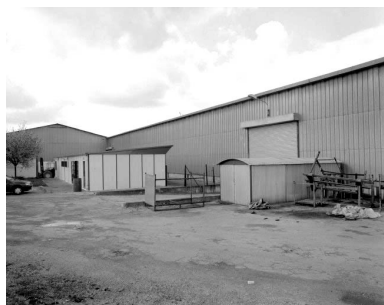
Exemple de productions de la société : baraque de chantier et bungalow. Phot. Yves Sancey IVR43_19943901696X
