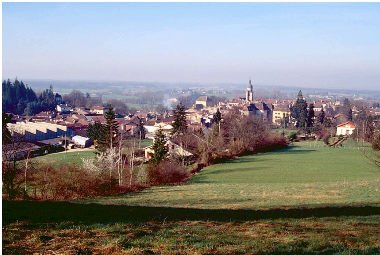
Vue d'ensemble de l'usine rue Lamartine et de la maison métallique rue de Peroset.
