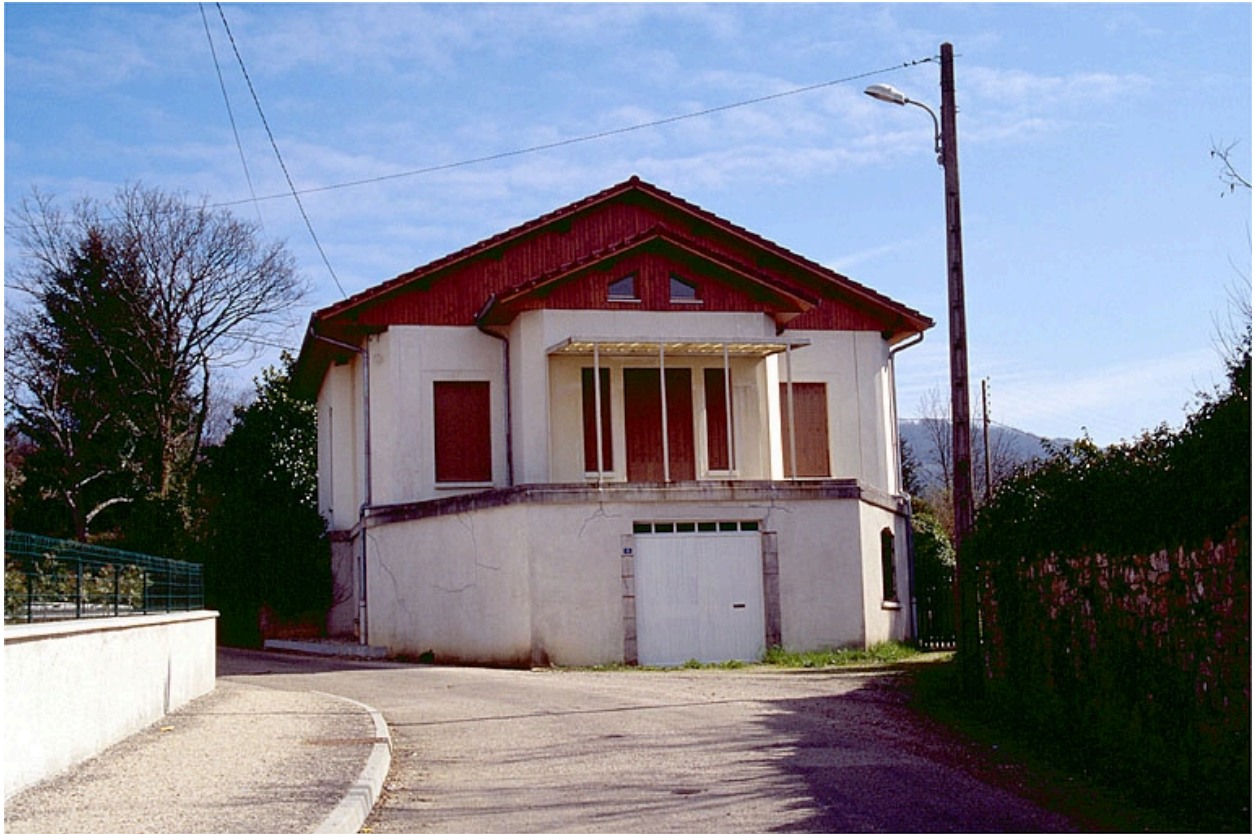
Maison métallique rue de Peroset : façade antérieure.
