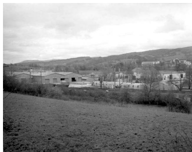
Usine rue Philibert de la Baume. Phot. Yves Sancey IVR43_19943901695X
