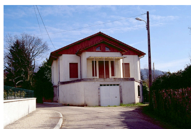
Maison métallique rue de Peroset : façade antérieure.
