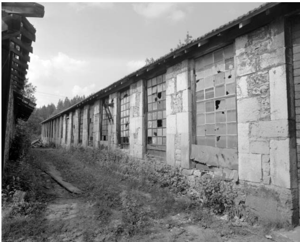
Façade antérieure de la clouterie.
