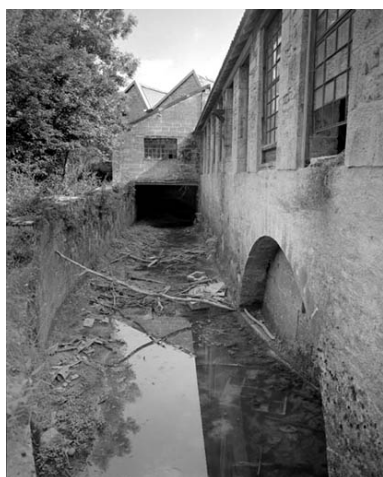
Ancien magasin d'huile et canal au long de la clouterie. Phot. Yves Sancey IVR43_19923900922X
