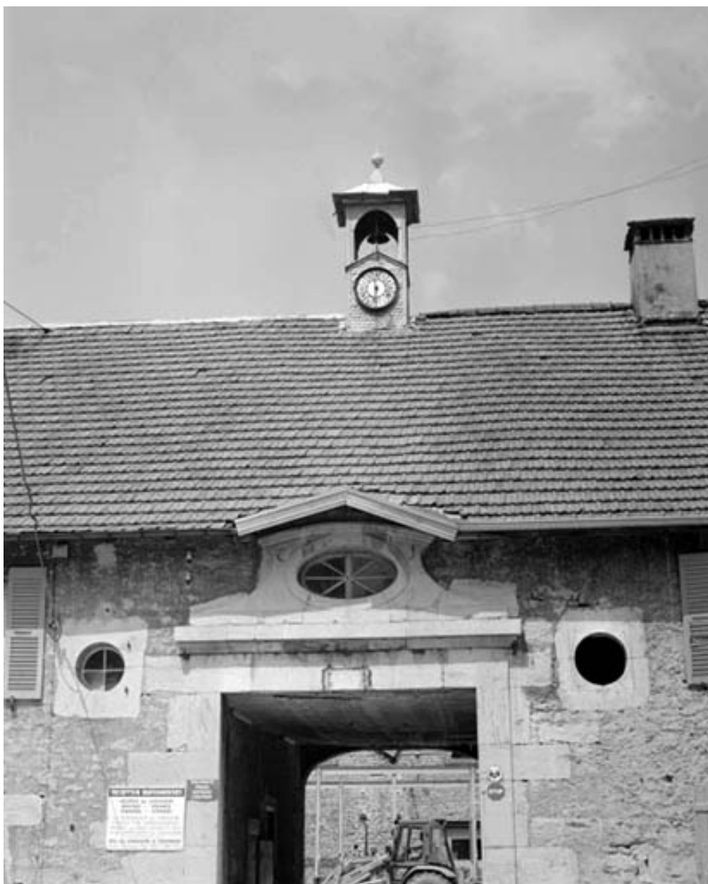
Porche d'entrée de l'usine.
