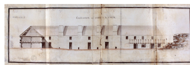
Elévation du côté de la cour. Phot. Daniel Lebée IVR43_19933900040XA
