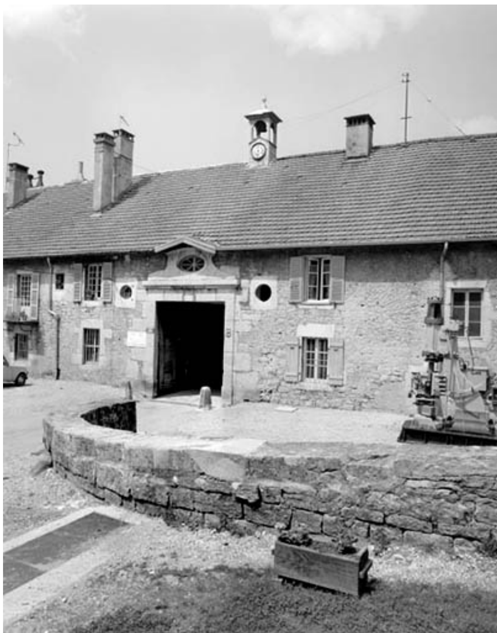
Rampe d'accès et porche d'entrée de l'usine.
