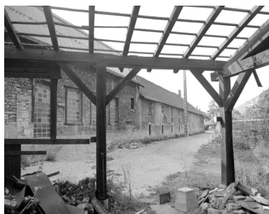
Aile ouest côté Saine. Phot. Yves Sancey IVR43_19923900919X
