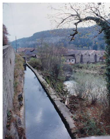
Canal d'amenée. Phot. Yves Sancey IVR43_19953901161XA
