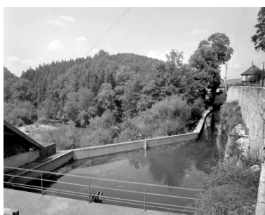
Bassin de retenue et canal d'amenée. Phot. Yves Sancey IVR43_19923900931X
