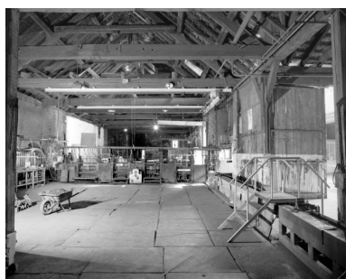
Intérieur de l'aile est depuis la centrale électrique. Phot. Yves Sancey IVR43_19923900894X
