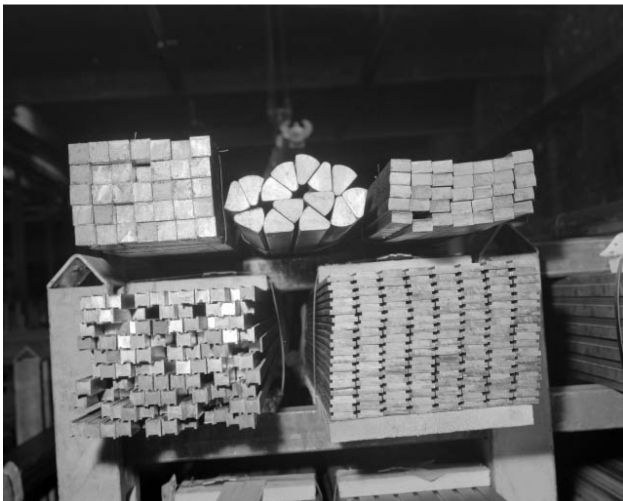
Atelier d'étirage : détail de quelques sections de profilés.
