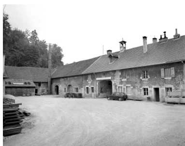
Façade postérieure de l'aile sud.
