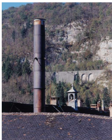
Cheminée d'usine. Phot. Yves Sancey IVR43_19953901165XA
