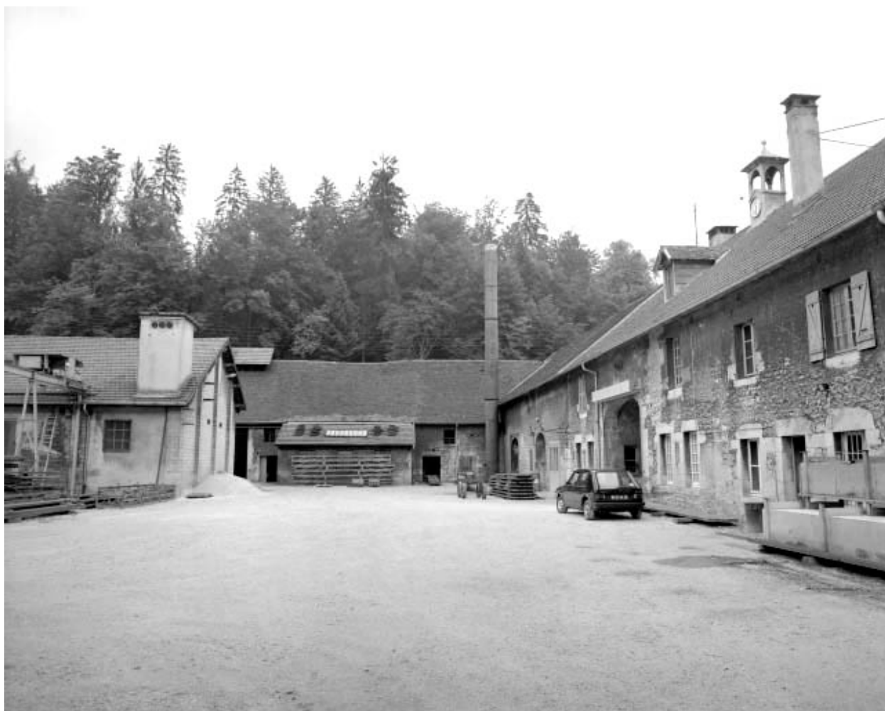
Façade sur cour de l'aile est.
