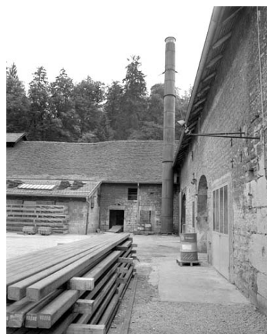
Atelier de tournage des cylindres (détruit depuis) et cheminée d'usine. Phot. Yves Sancey IVR43_19923900887X
