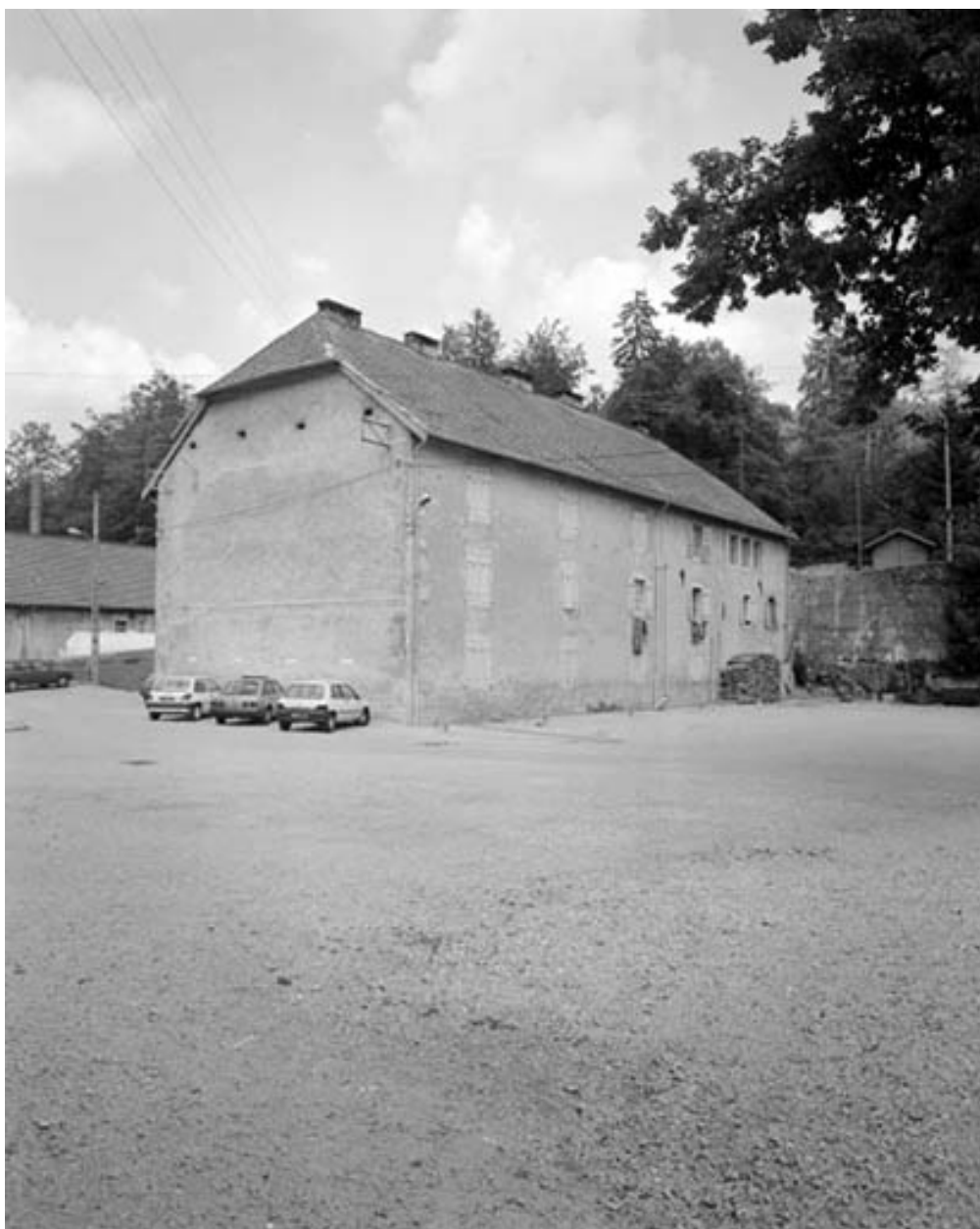
Logement d'ouvriers et ancienne poste depuis la cour.
