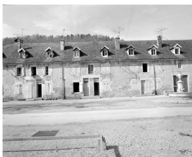
Façade du logement d'ouvriers. Phot. Yves Sancey IVR43_19943901381X
