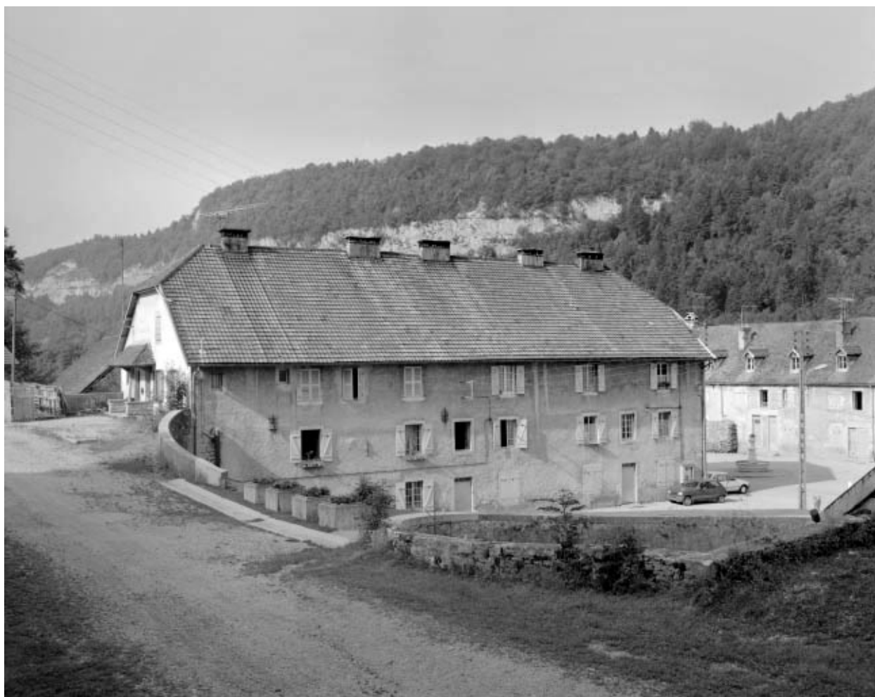
Logement d'ouvriers et ancienne poste, depuis la route.
