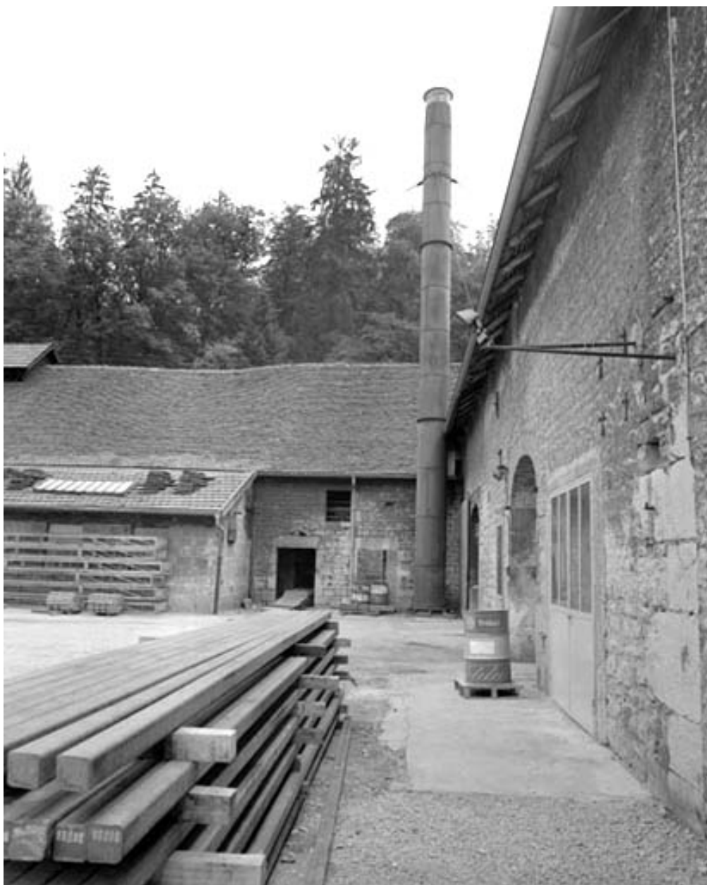
Atelier de tournage des cylindres (détruit depuis) et cheminée d'usine.
