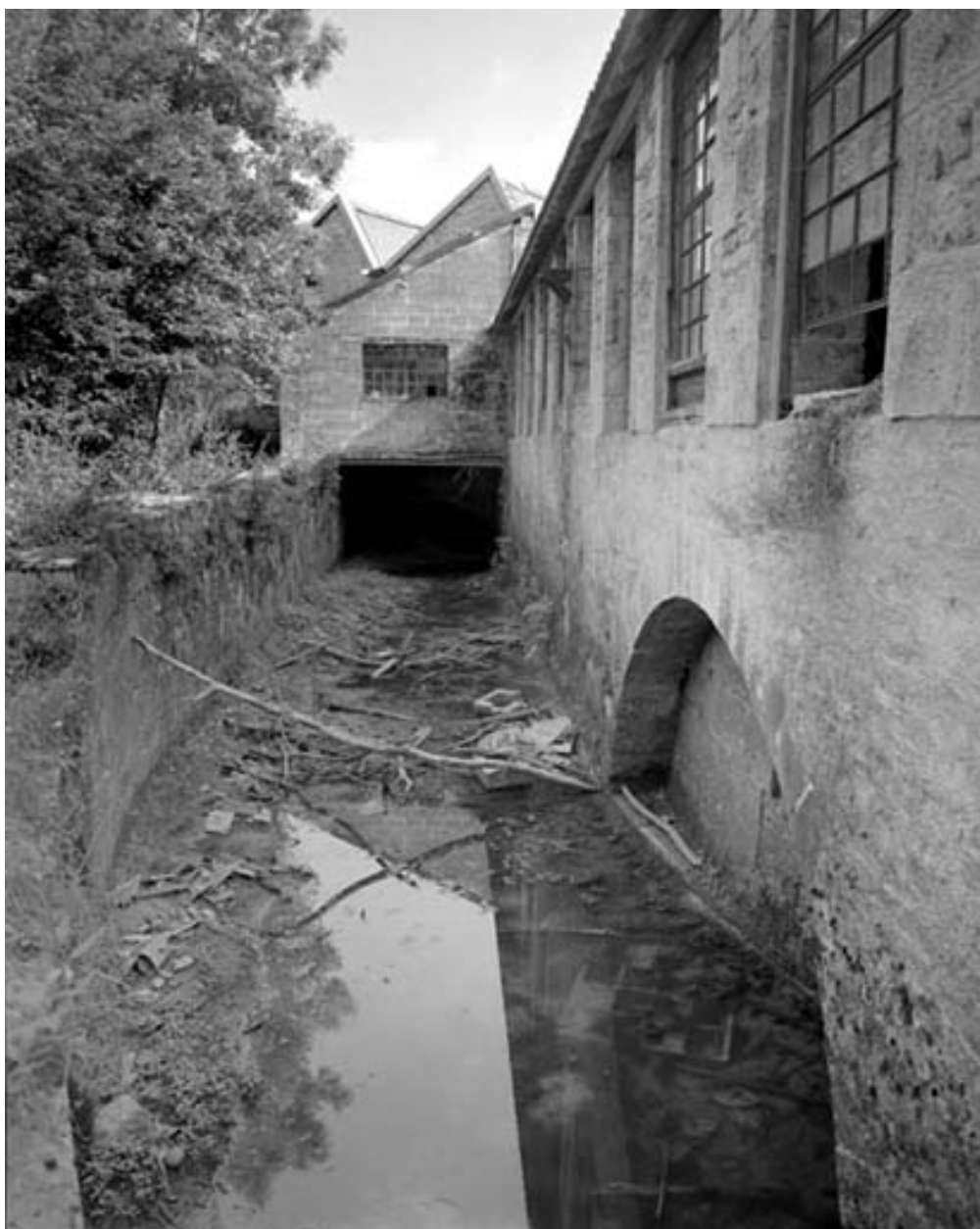
Ancien magasin d'huile et canal au long de la clouterie.
