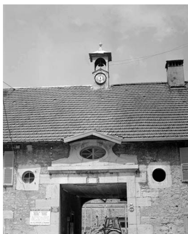
Porche d'entrée de l'usine.
