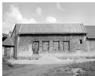
Extrémité de l'aile nord, côté Saine. Phot. Yves Sancey IVR43_19923900905X
