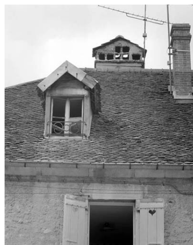
Lucarne et cheminée du logement d'ouvriers. Phot. Yves Sancey IVR43_19923900936X
