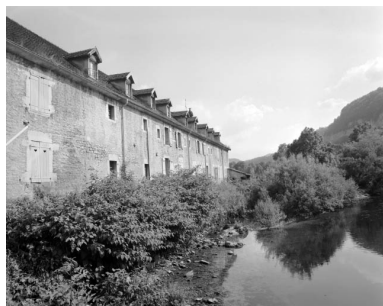
Logement d'ouvriers côté Saine. Phot. Yves Sancey IVR43_19923900935X
