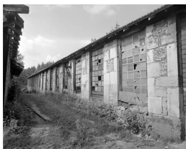
Façade antérieure de la clouterie. Phot. Yves Sancey IVR43_19923900926X
