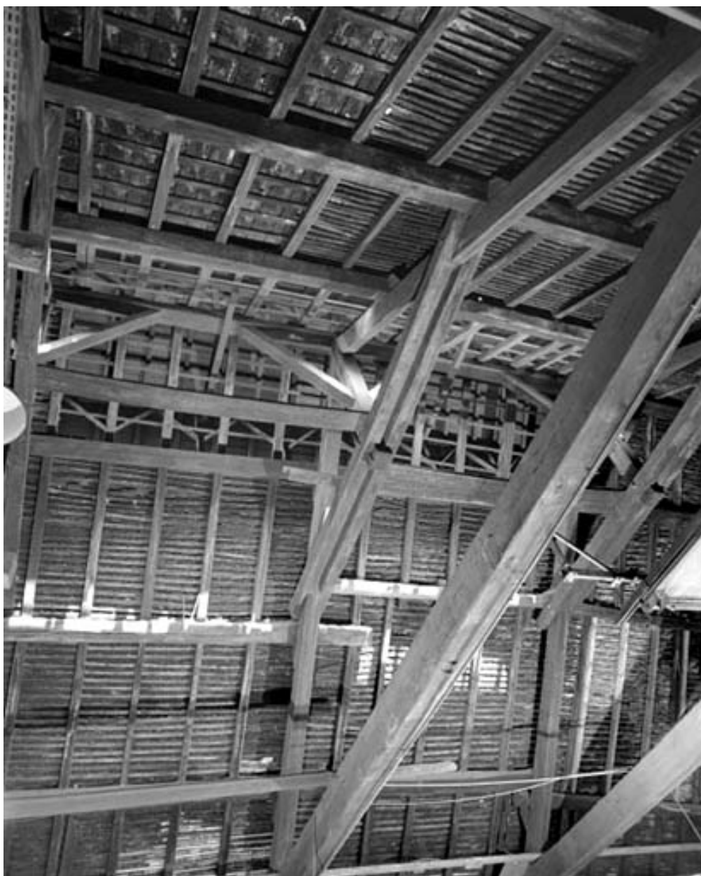
Charpente du lanterneau.
