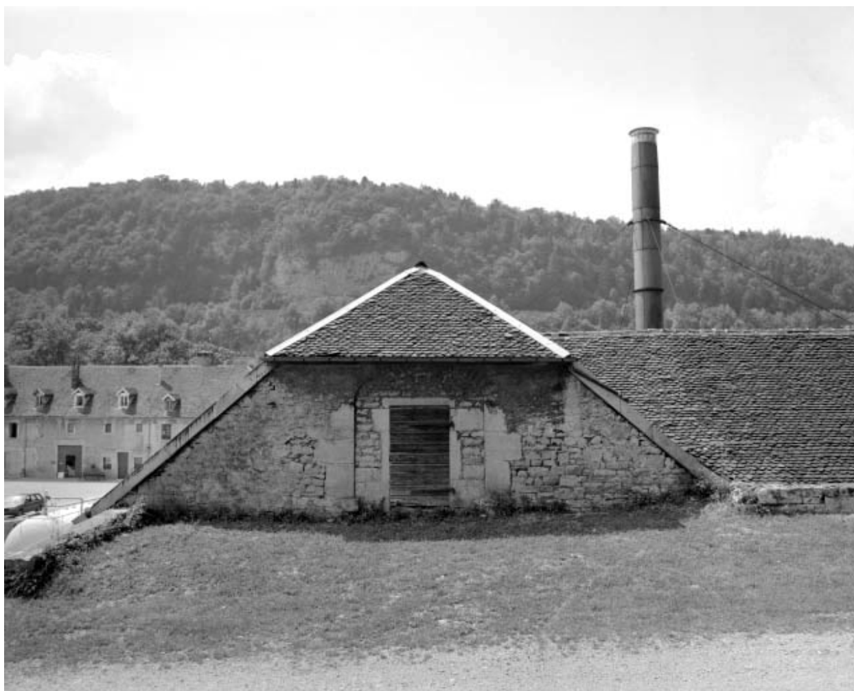
Mur pignon de l'aile sud, côté halle à charbon.
