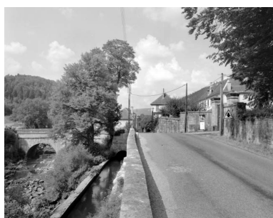
Pont et canal d'amenée, vus d'aval. Phot. Yves Sancey IVR43_19923900930X
