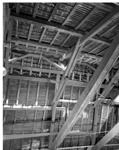
Charpente du lanterneau. Phot. Yves Sancey IVR43_19923900890X
