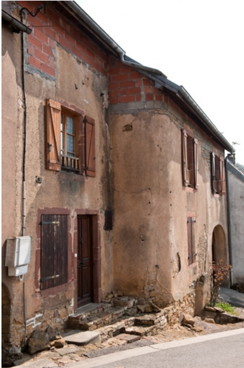
Façade antérieure, vue de trois quart gauche.
