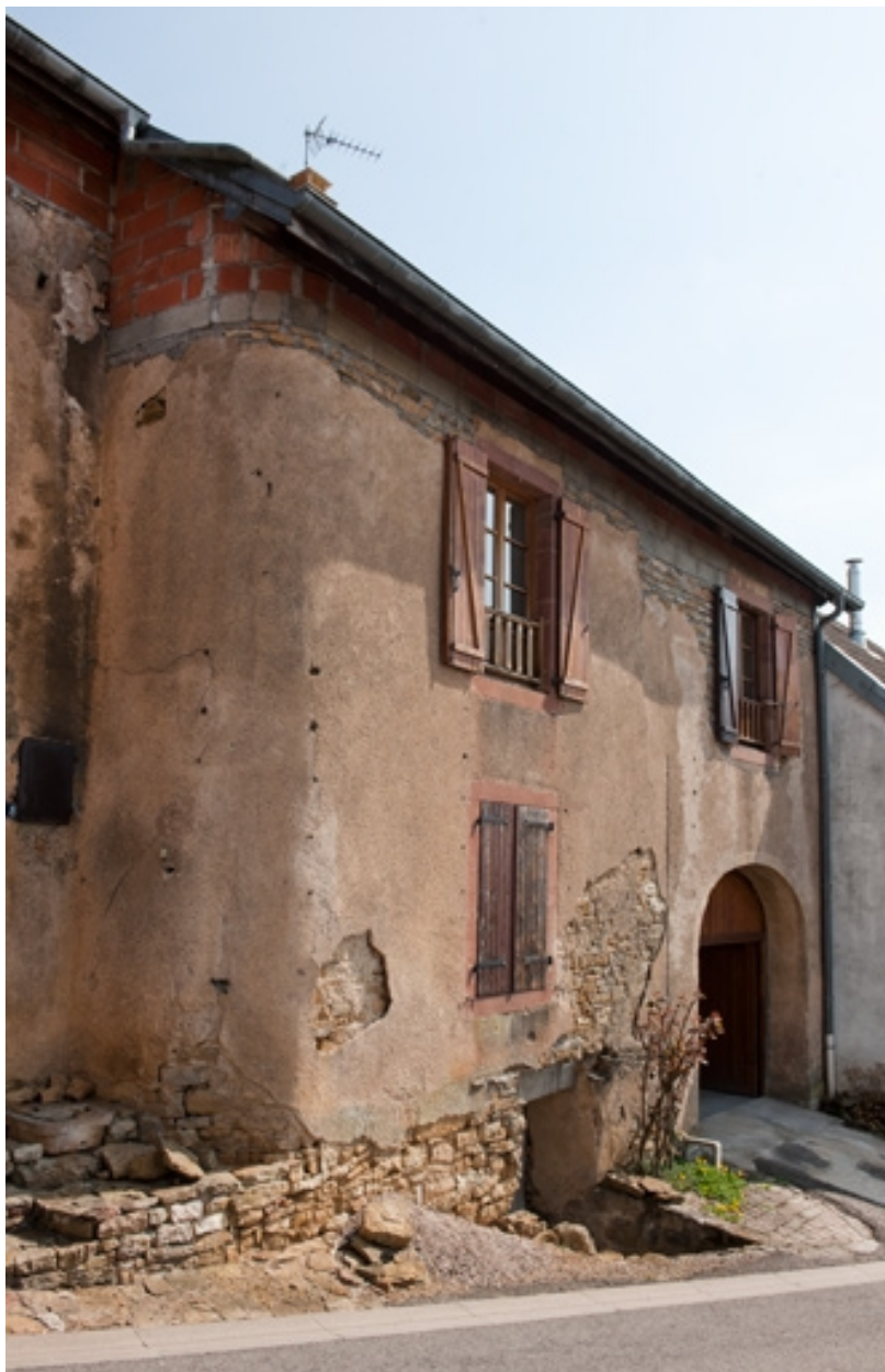
Vue rapprochée de la façade antérieure.
