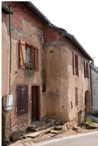
Façade antérieure, vue de trois quart gauche. Phot. Jérôme Mongreville IVR43_20102500664NUC4A
