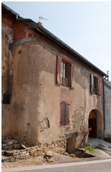
Vue rapprochée de la façade antérieure. Phot. Jérôme Mongreville IVR43_20102500663NUC4A
