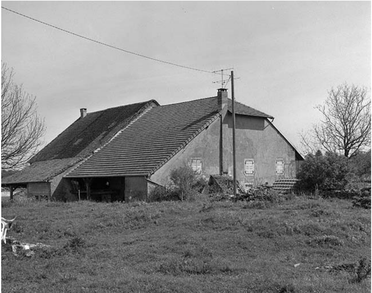
Façade postérieure et façade droite.
