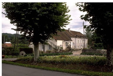
Vue d'ensemble. Phot. Jérôme Mongreville IVR43_19953900424ZA
