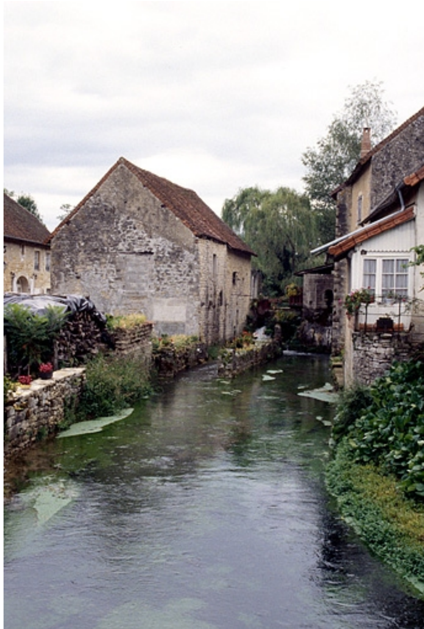
Ancienne huilerie et façade postérieure.
