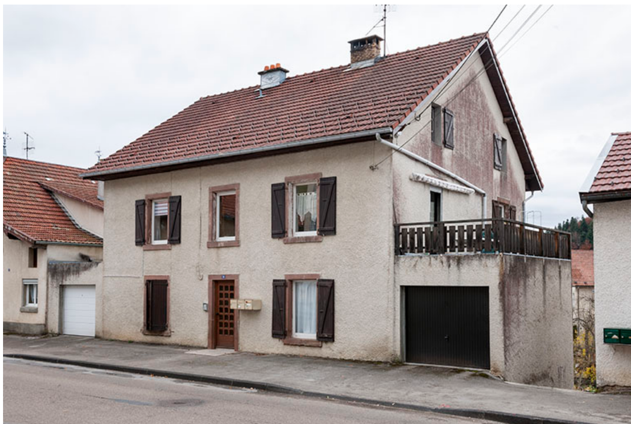
Façades antérieure et latérale droite.
