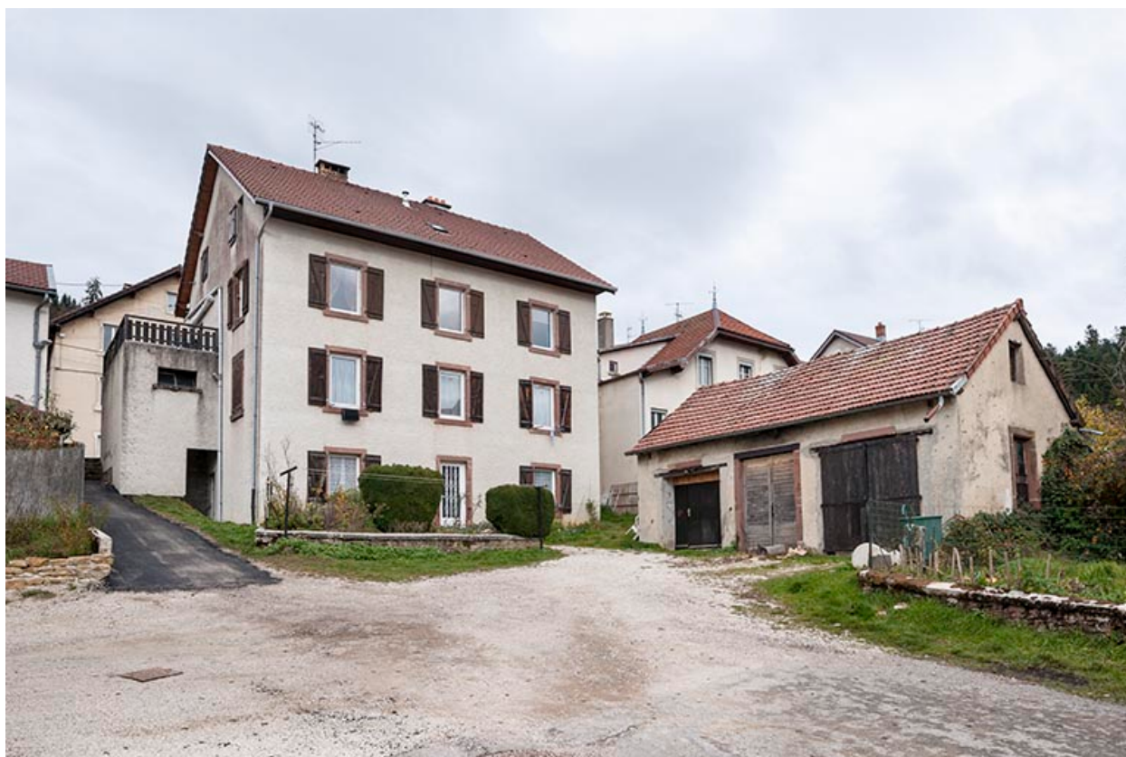
Façade postérieure et ancien atelier ou remise.
