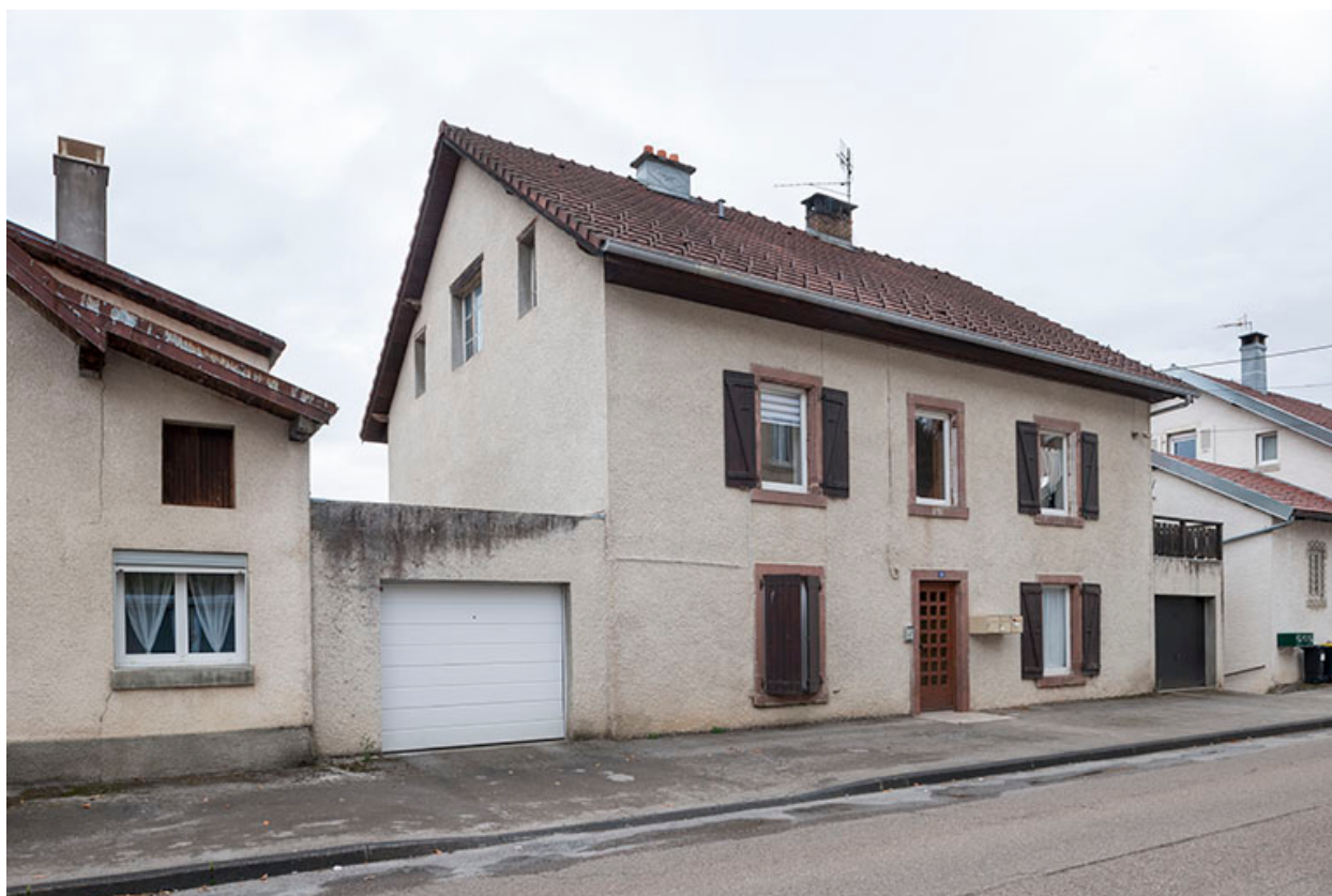
Façades antérieure et latérale gauche.
