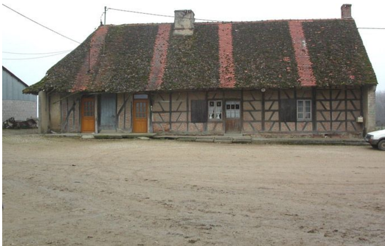
Vue d'ensemble de la façade.
