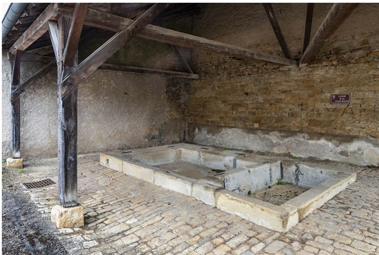
L'intérieur du lavoir.
