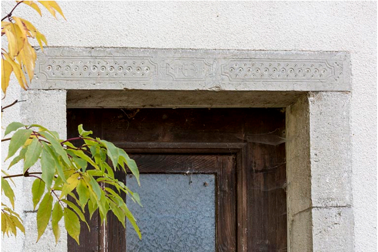
Logement : linteau orné d'une porte sur la façade postérieure.
