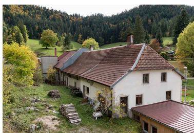
Logement : façades postérieure et latérale gauche. Phot. Sonia Dourlot IVR43_20172501735NUC4A
