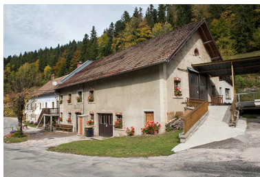
Atelier de fabrication : façades antérieure et latérale droite.
