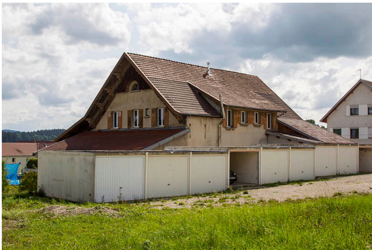
Façades postérieure et latérale gauche.
