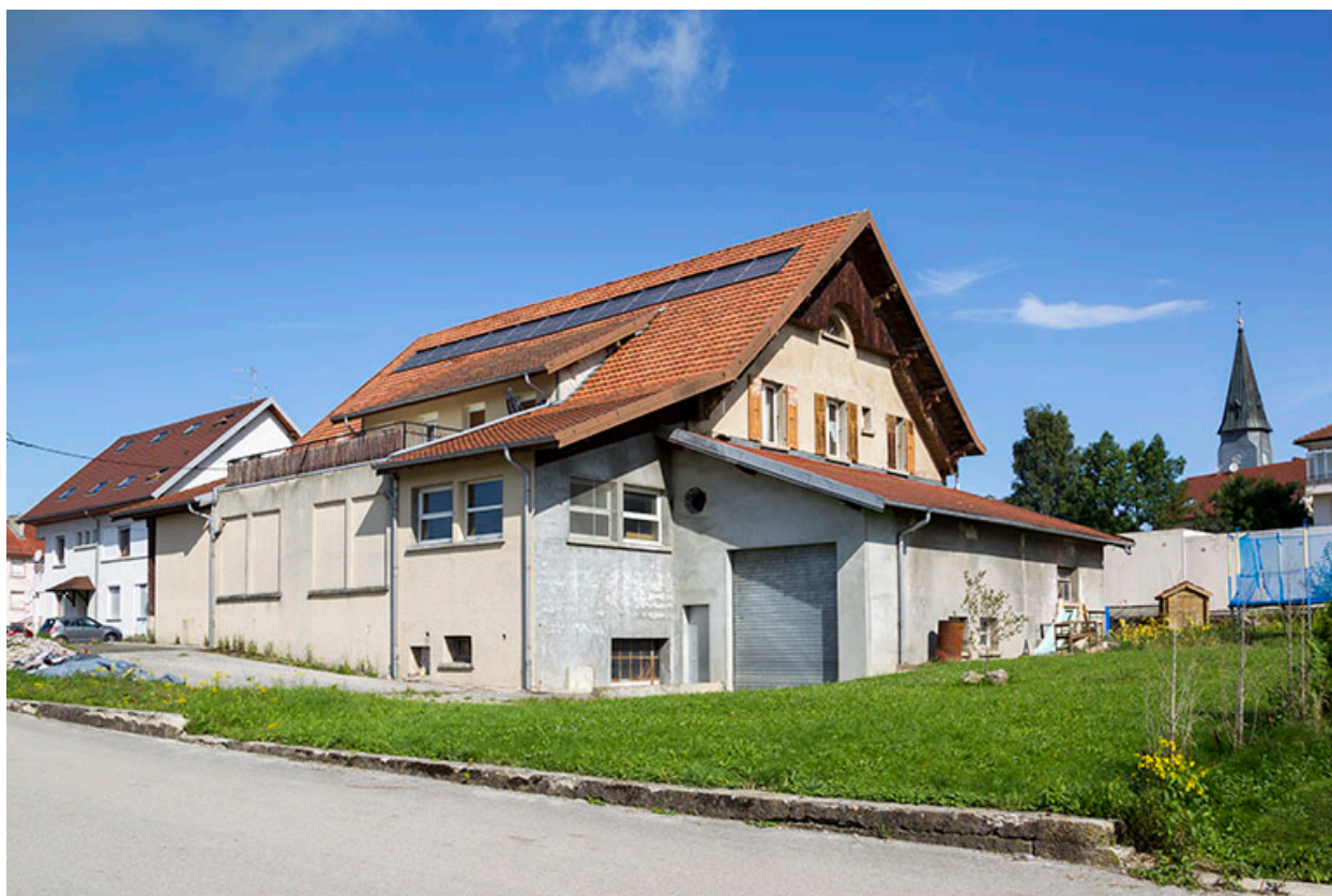
Façades postérieure et latérale droite.
