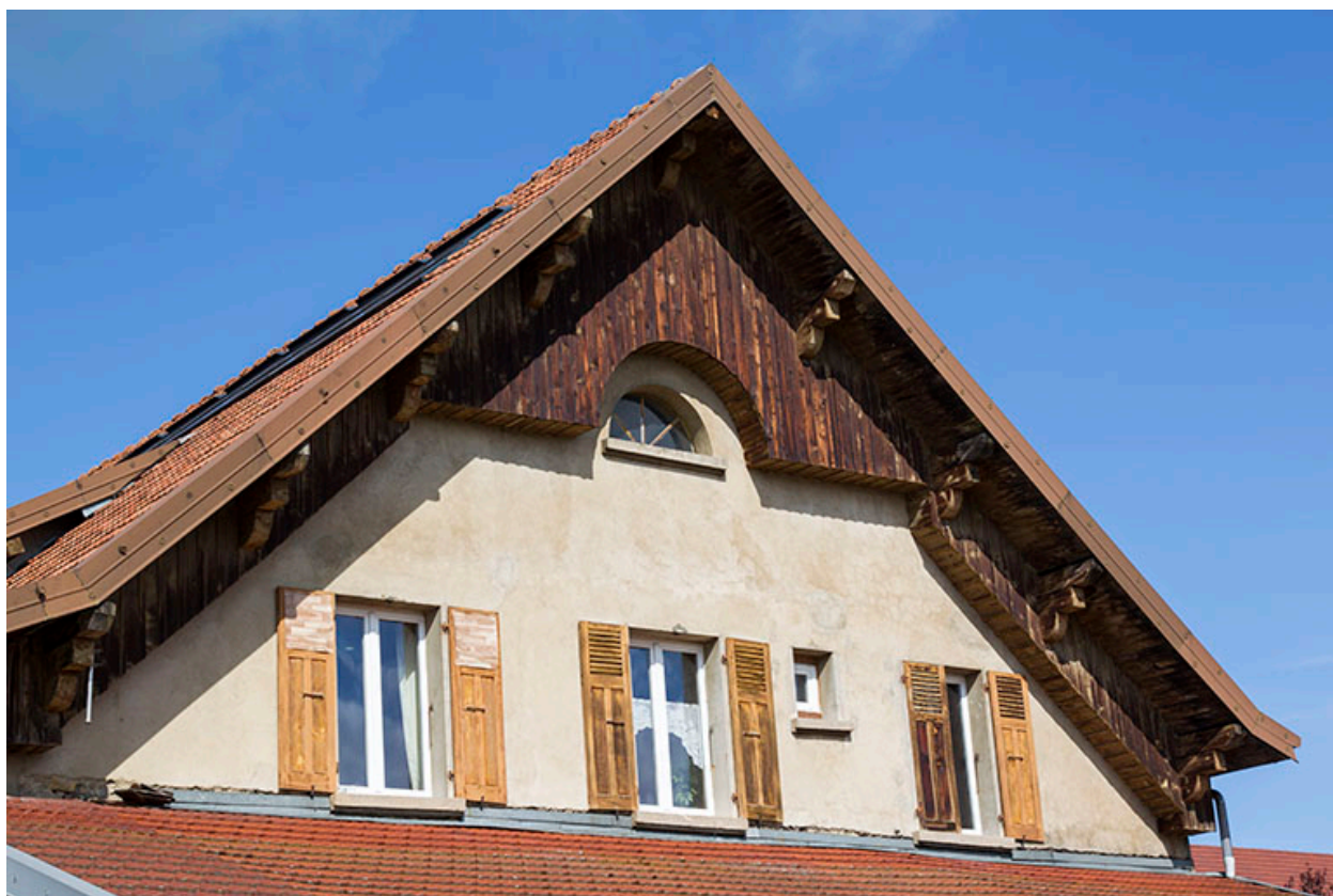
Façade postérieure : fenêtres du pignon.
