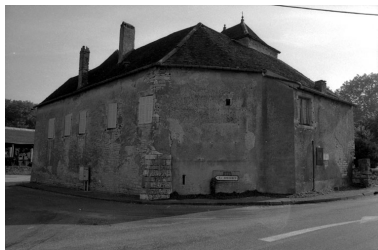
Maison située route de Besançon. Phot. Bernard Lardière IVR43_19797000138Z
