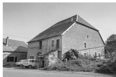
Ferme située route de Bay. Phot. Bernard Lardière IVR43_19797000146Z
