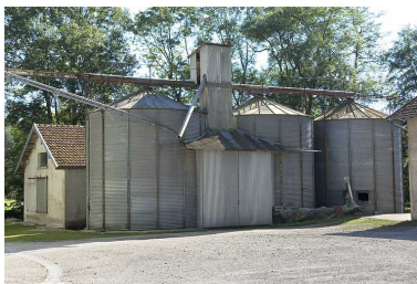
Silos métalliques. Phot. Jérôme Mongreville IVR43_20067000876NUCA
