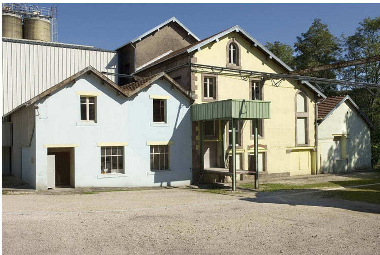
Façades occidentales du moulin.
