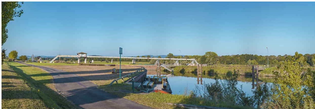
L'entrée amont du site d'écluse.
