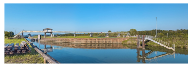
Tête amont de l'écluse. Phot. Thierry Kuntz IVR26_20217100391NUC4A
