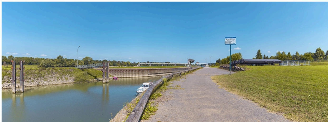
Le site d'écluse vu d'aval.
