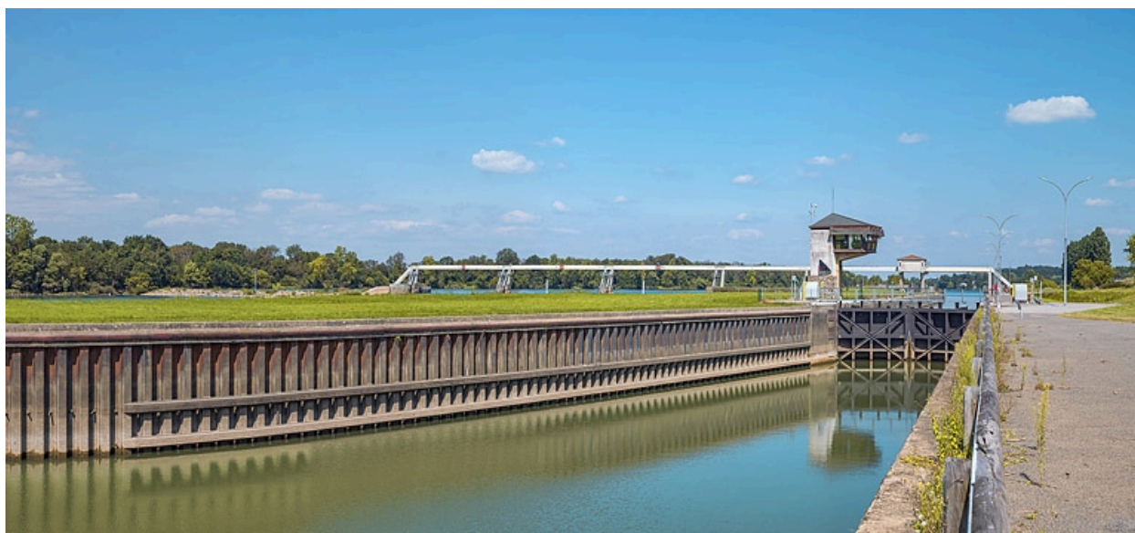
Tête aval de l'écluse.
