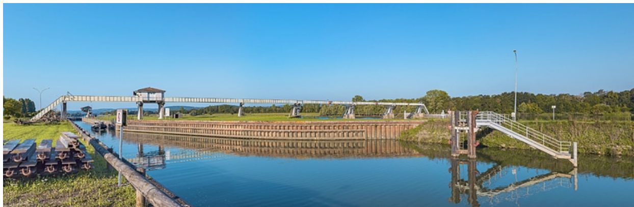
Tête amont de l'écluse.
