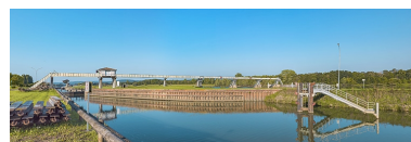
Tête amont de l'écluse. Phot. Thierry Kuntz IVR26_20217100394NUC4A
