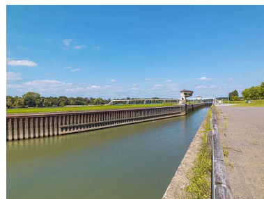
Le sas vu d'aval.
