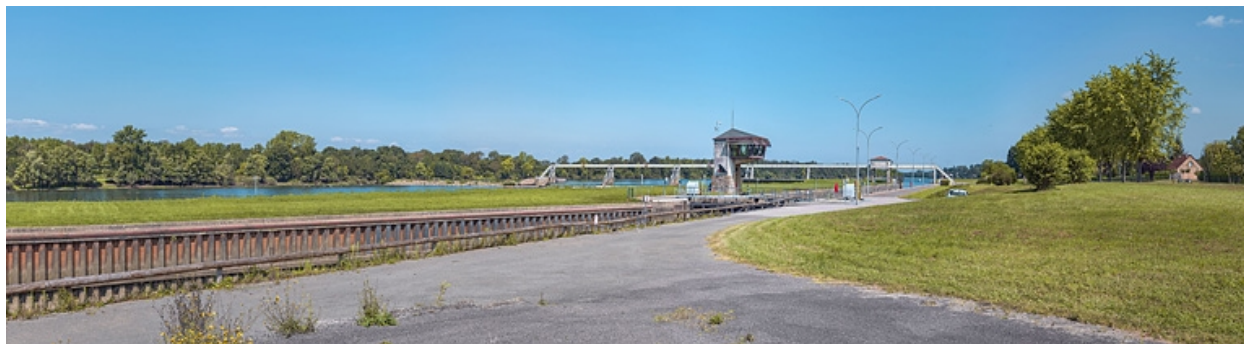
Tête aval de l'écluse.
