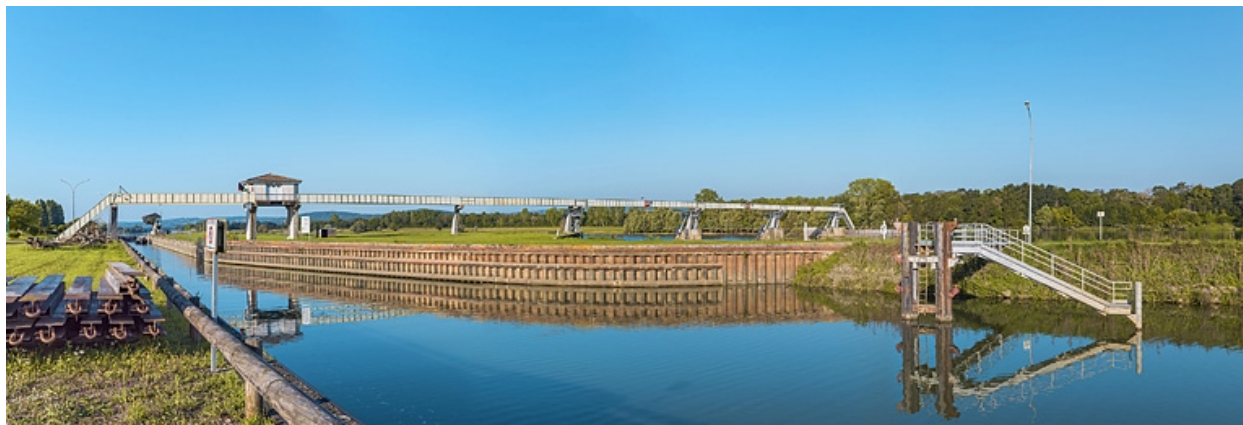
L'écluse vue d'amont.
