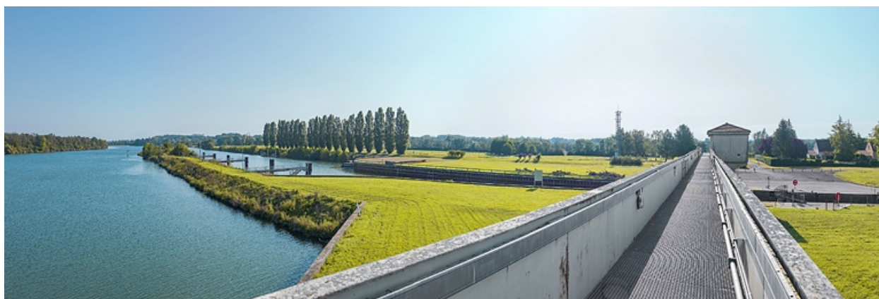
L'amont du sas vu depuis la passerelle du barrage.
