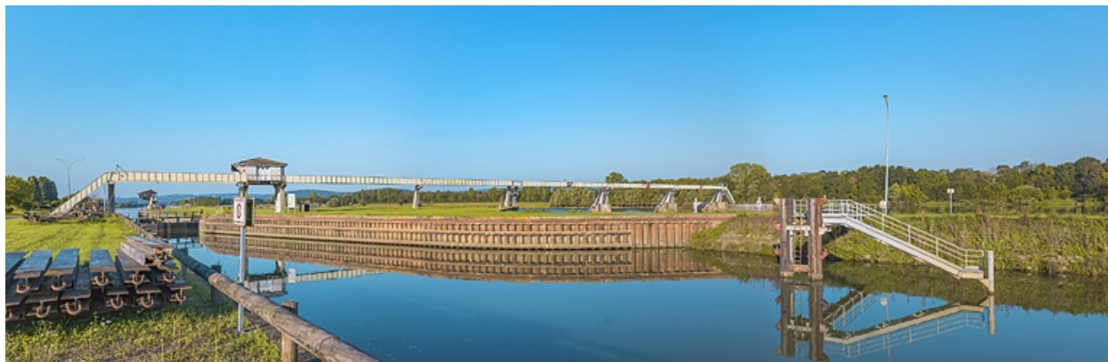
Tête amont de l'écluse.
