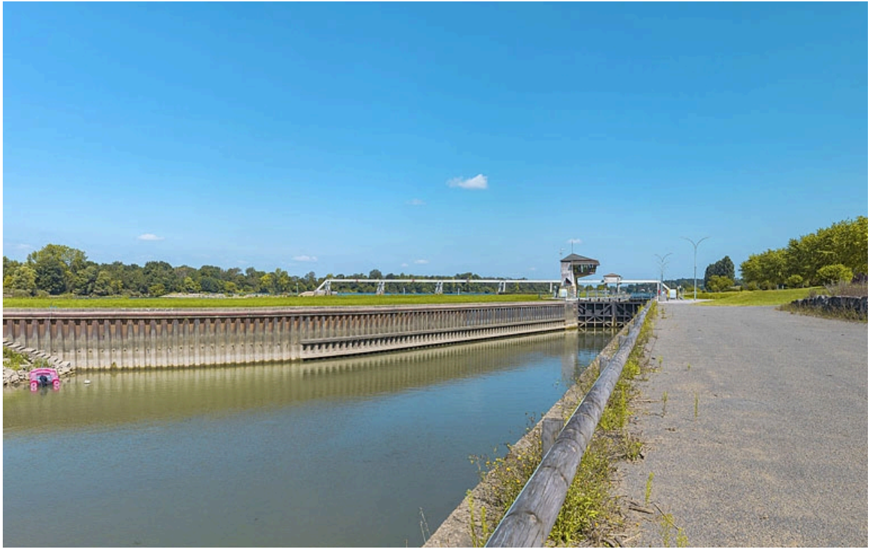
Murs-guides à l'aval du site d'écluse.
