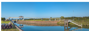
Fermeture des portes amont du site d'écluse. Phot. Thierry Kuntz IVR26_20217100393NUC4A
