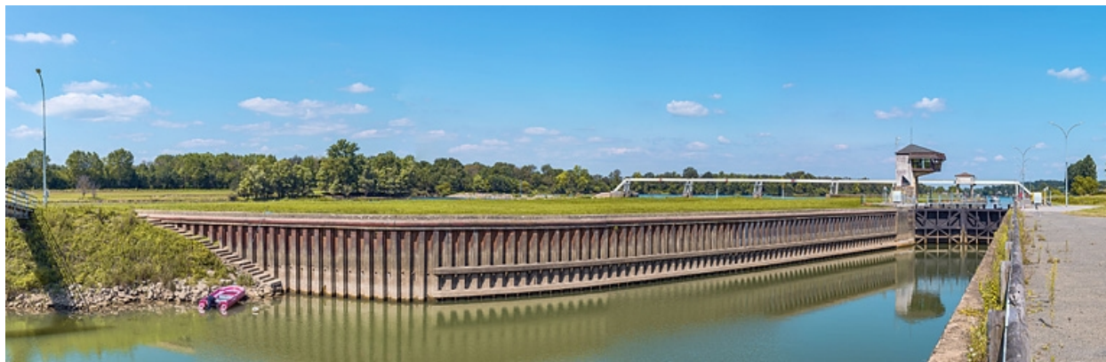
Murs-guides à l'aval du site d'écluse.
