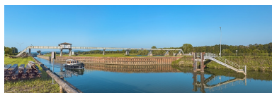
Le site d'écluse vu d'amont. Phot. Thierry Kuntz IVR26_20217100390NUC4A
