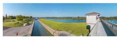
Le sas à grand gabarit, vu depuis la passerelle du barrage. Phot. Thierry Kuntz IVR26_20217100397NUC4A
