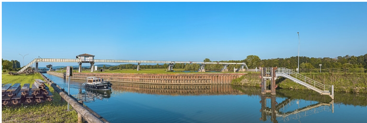
Le site d'écluse vu d'amont.
