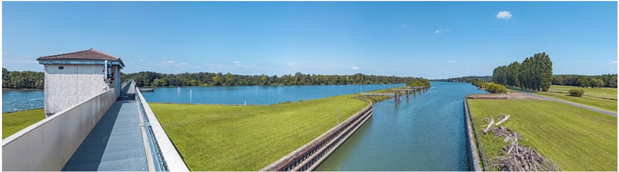
L'amont du sas vu depuis la passerelle du barrage.
