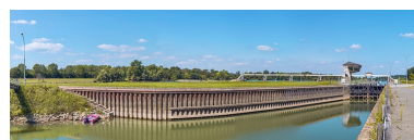
Murs-guides à l'aval du site d'écluse.
