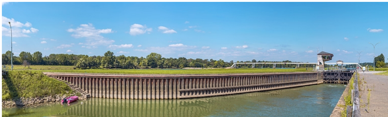
Murs-guides à l'aval du site d'écluse.
