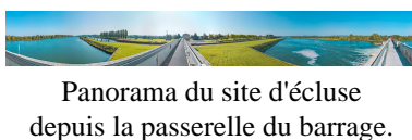
Panorama du site d'écluse depuis la passerelle du barrage.
