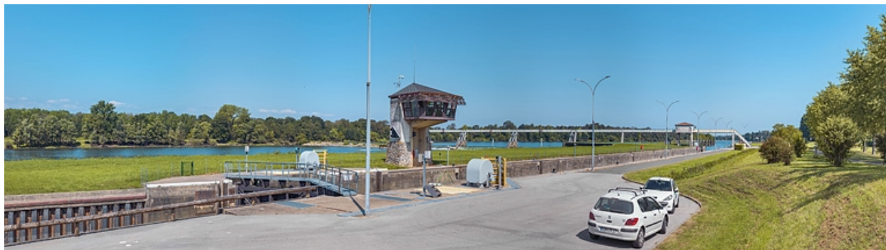
Portes aval de l'écluse et poste de commande au centre.
