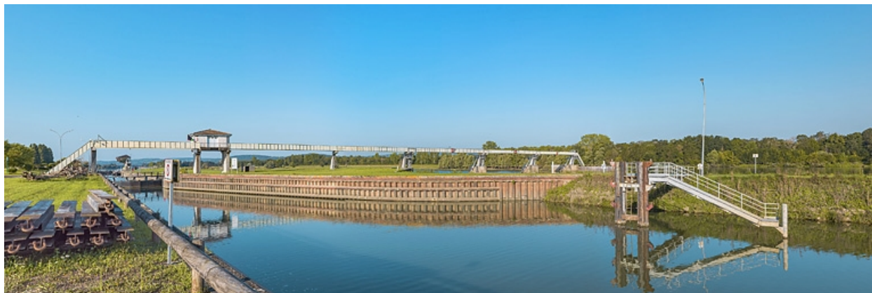
Tête amont de l'écluse.
