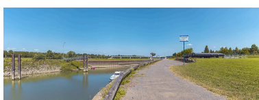
Le site d'écluse vu d'aval. Phot. Thierry Kuntz IVR26_20217100407NUC4A
