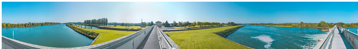
Panorama du site d'écluse depuis la passerelle du barrage.
