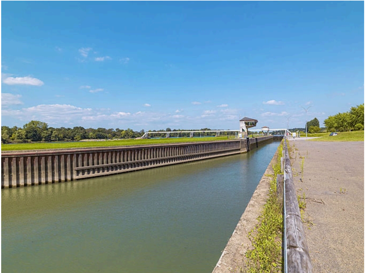
Le sas vu d'aval.
