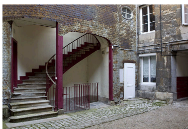
Départ de l'escalier à cage ouverte, à droite de la première cour. Phot. Yves Sancey IVR43_20102500460NUC2A
