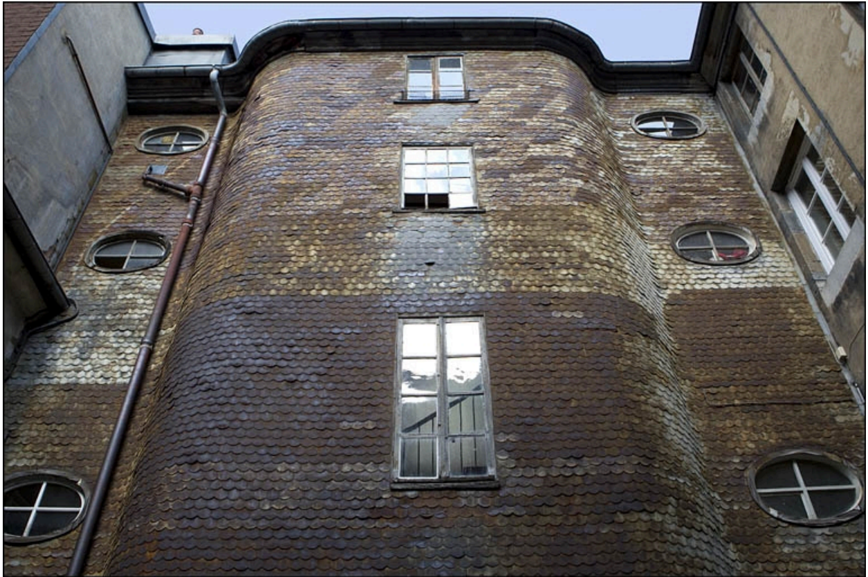
Détail de la partie supérieure de l'escalier à cage ouverte, de face.
