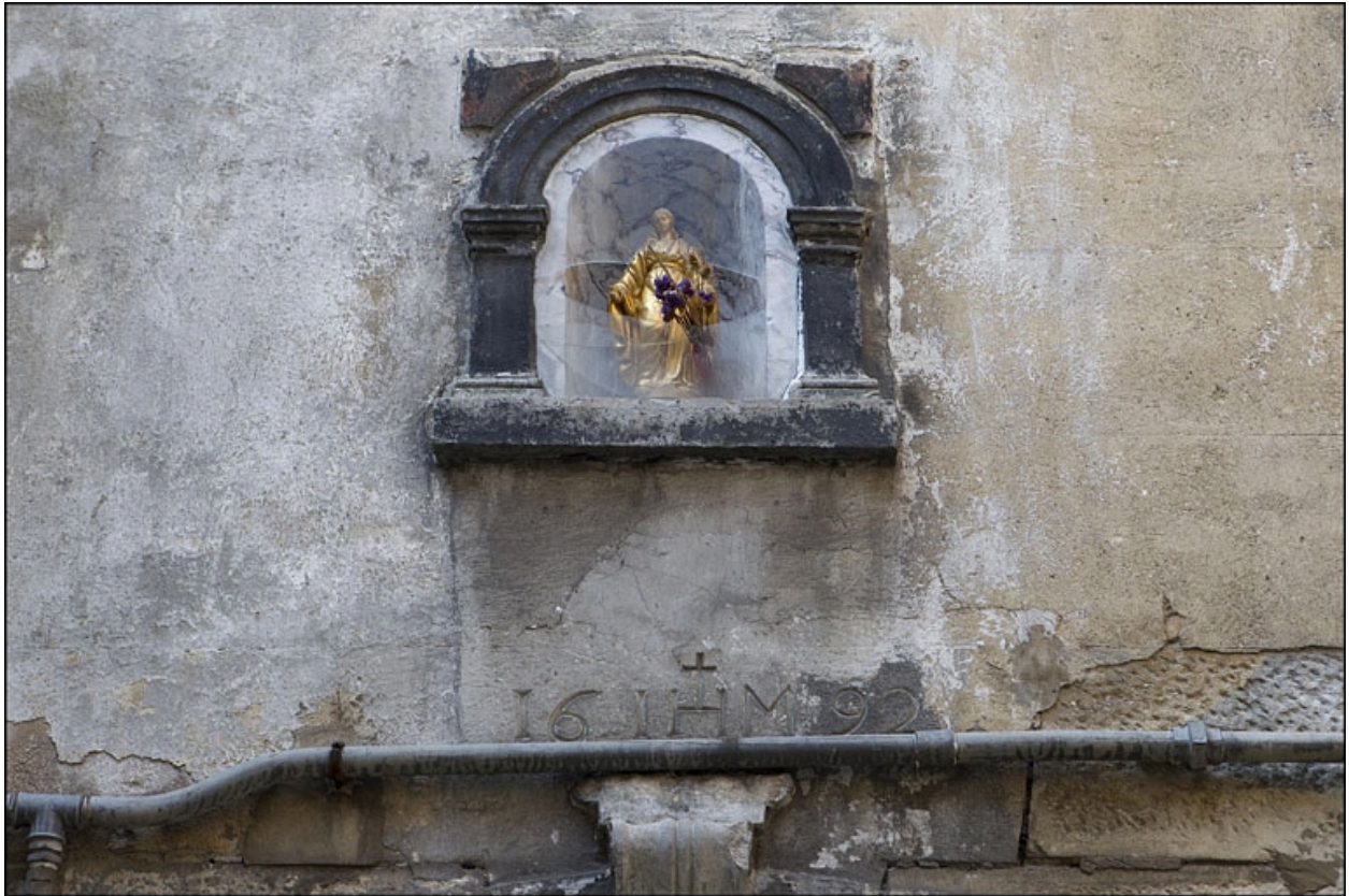
Détail de la niche sur la façade antérieure du premier logis secondaire.
