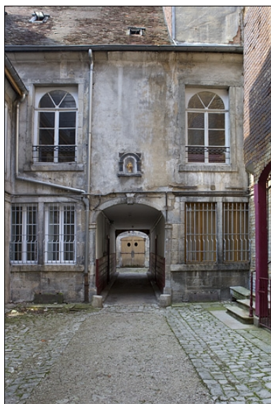
Façade antérieure du premier logis secondaire donnant sur la première cour. Phot. Yves Sancey
