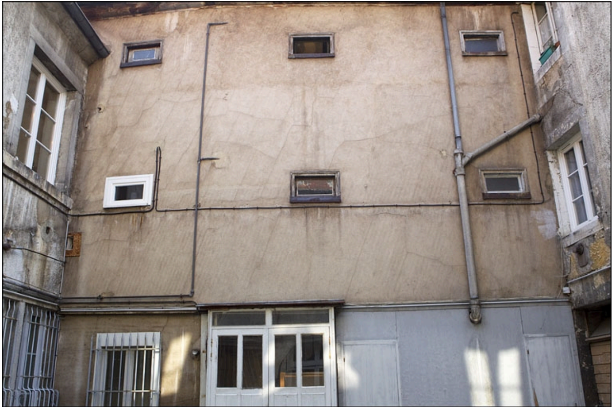
Premier logis secondaire, aile gauche sur la deuxième cour.
