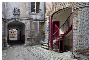
Détail du départ de l'escalier à cage ouverte et du deuxième passage cocher, depuis l'entrée de la première cour. Phot. Yves Sancey IVR43_20102500466NUC2A
