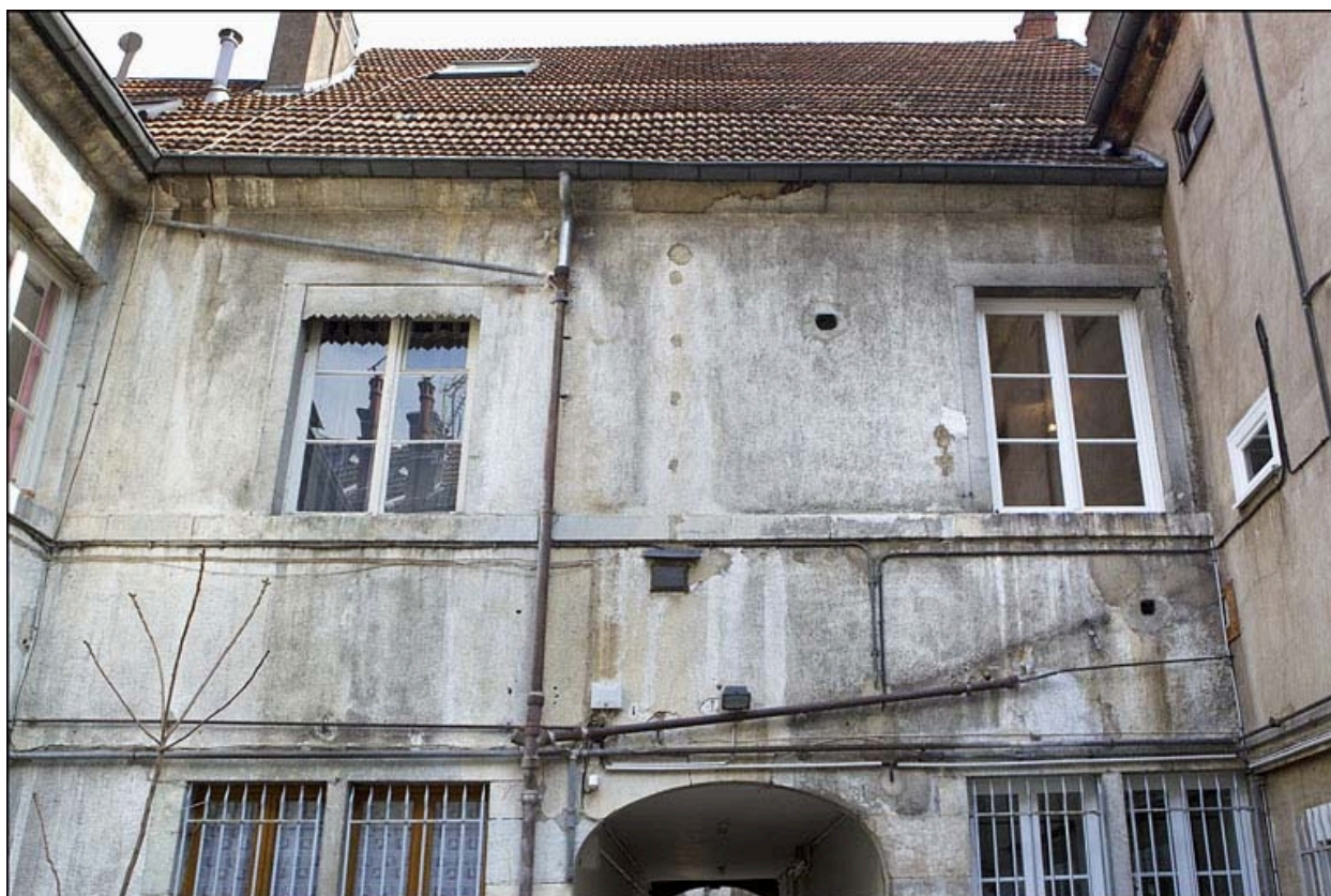
Vue de la façade postérieure du premier logis secondaire, à partir du premier étage.
