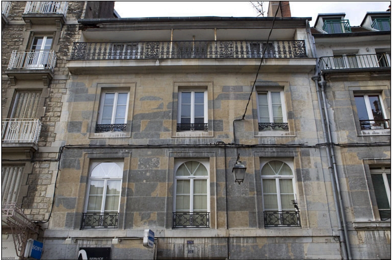
Vue de la façade antérieure sur rue du logis principal à partir du premier étage.
