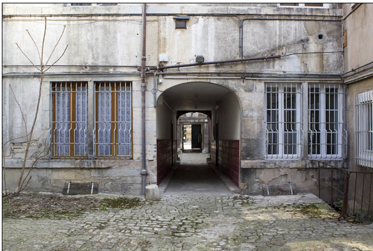
Vue du rez-de-chaussée de la façade postérieure du premier logis secondaire.
