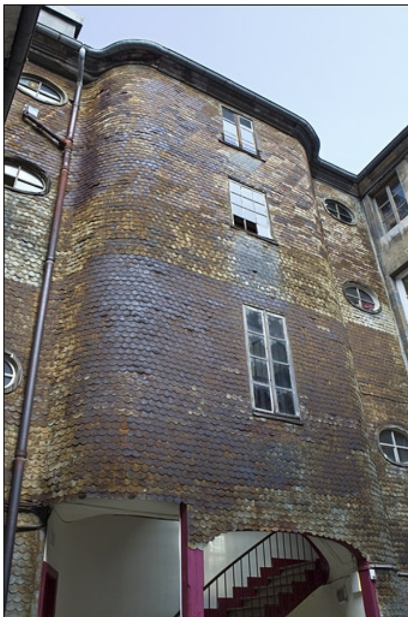
Vue d'ensemble de l'escalier à cage ouverte depuis la cour.
