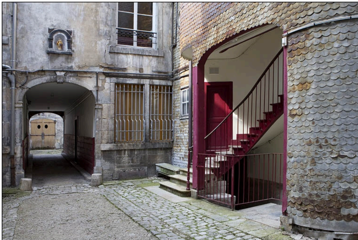
Détail du départ de l'escalier à cage ouverte et du deuxième passage cocher, depuis l'entrée de la première cour.
