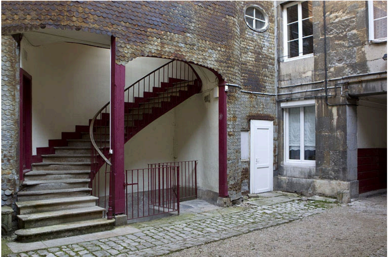
Départ de l'escalier à cage ouverte, à droite de la première cour.
