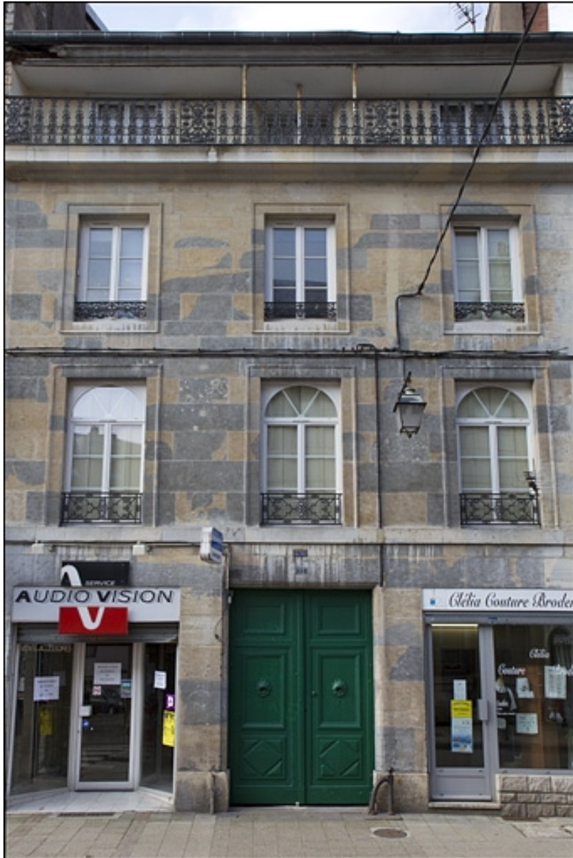
Vue d'ensemble de la façade antérieure sur rue du logis principal.
