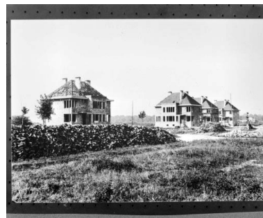
Maison de même type en construction, groupe Z. Phot. , Phot. Charnotet IVR43_19903900131X
