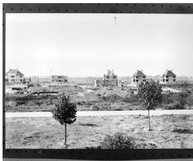
Maisons de même type en construction, groupe Z. Phot. , Phot. Charnotet IVR43_19903900130X
