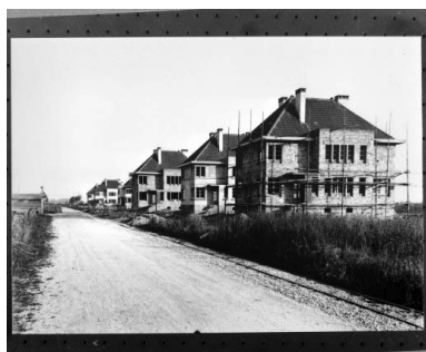
Maisons de même type en construction, groupe Z. Phot. , Phot. Charnotet IVR43_19903900132X
