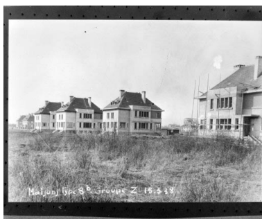
Maisons de même type en construction, groupe Z. Phot. , Phot. Charnotet IVR43_19903900133X
