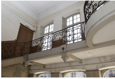
Aile droite, escalier : premier étage, vue de la grille en ferronnerie du palier. Phot. Yves Sancey IVR43_20102500952NUC2A
