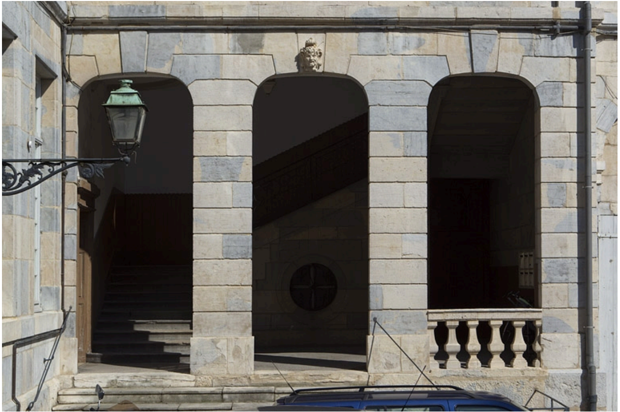
Aile droite : détail des trois baies libres du rez-de-chaussée.
