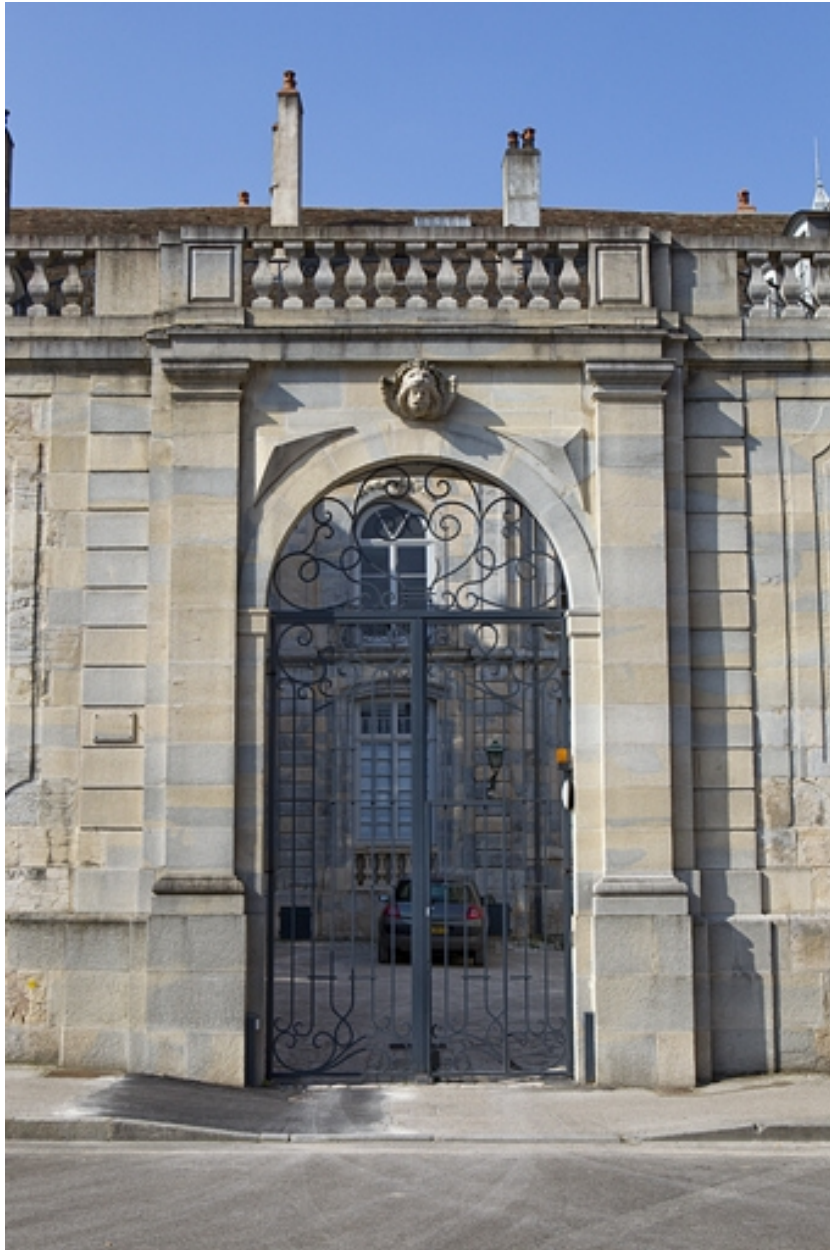
Vue d'ensemble du portail dans clôture.
