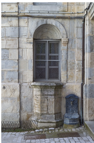
Vue d'ensemble du puits et de la borne fontaine appuyés contre le mur de clôture de la cour. Phot. Yves Sancey IVR43_20102500947NUC2A
