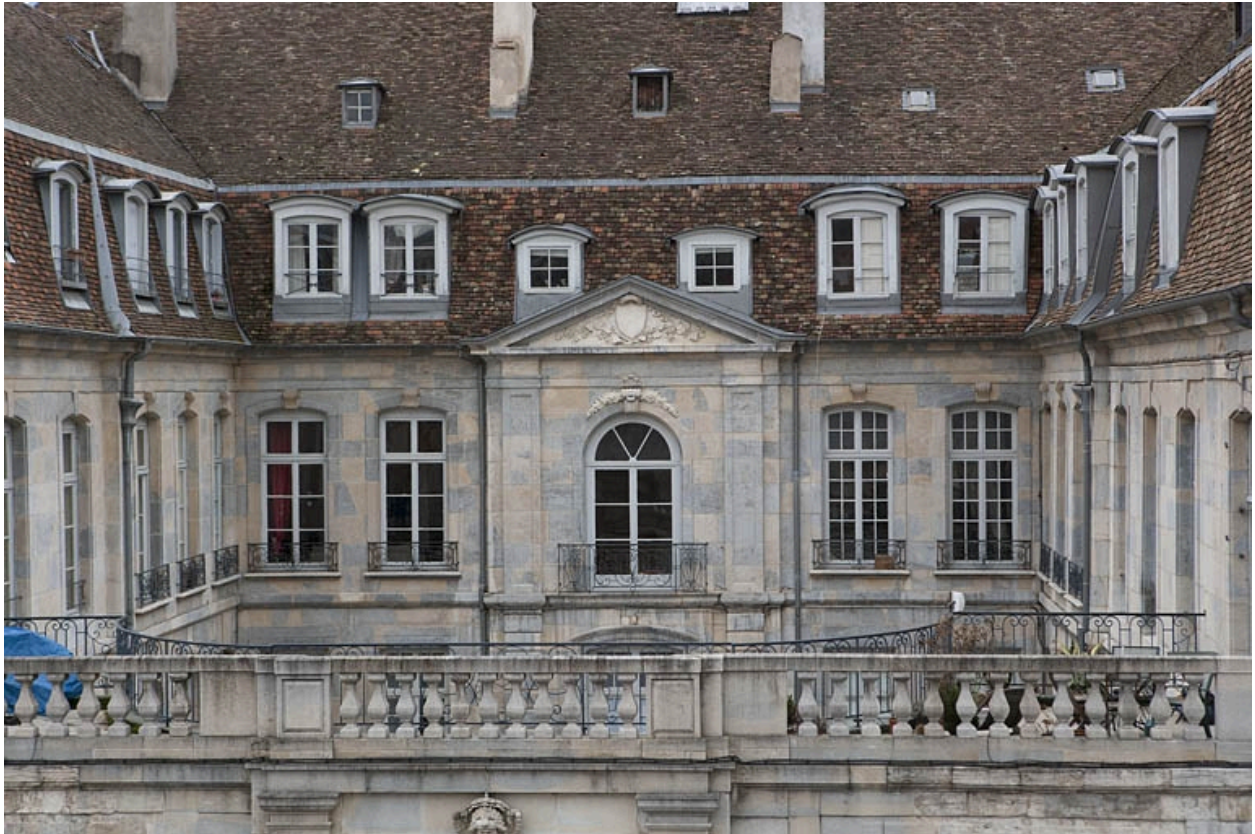
Vue rapprochée en hauteur de la balustrade du mur de clôture et du premier étage des façades sur cour.
