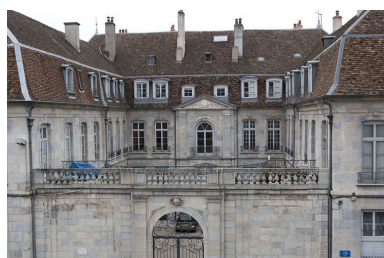
Vue d'ensemble en hauteur de la clôture et du premier étage des bâtiments sur cour. Phot. Yves Sancey IVR43_20102500962NUC2A
