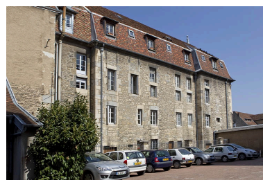
Vue d'ensemble de la façade postérieure de l'aile gauche sur cour. Phot. Yves Sancey IVR43_20102500939NUC2A
