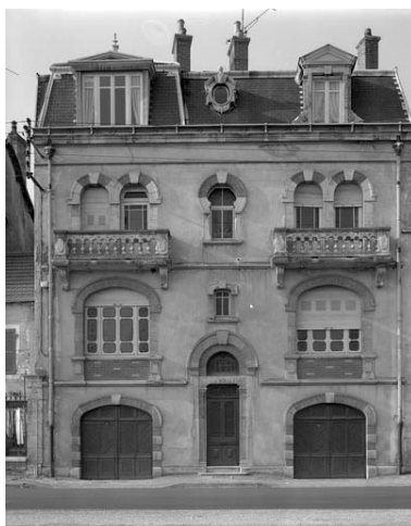
Façade antérieure de face, vue rapprochée.
