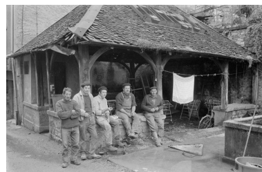
Démolition du quartier de Saint- Maurice. Des ouvriers posent devant le lavoir, s.d. [vers 1973] Phot. Jean-Marie Maronnier IVR43_20243900907NUC2A
