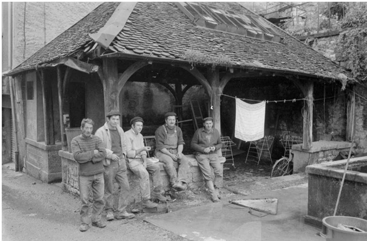
Démolition du quartier de Saint-Maurice. Des ouvriers posent devant le lavoir, s.d. [vers 1973]
