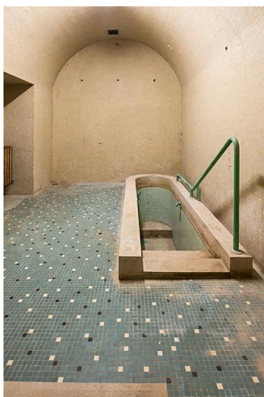
Ancienne cabine de bain, au rez-de-chaussée. Phot. Pierre-Marie Barbe-Richaud IVR26_20217100176NUC4A
