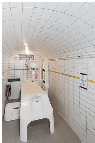
Nouvelle cabine de soin, au rez-de-chaussée. Phot. Pierre-Marie Barbe-Richaud IVR26_20217100179NUC4A
