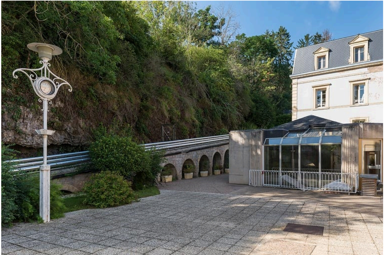
Lampadaire à l'origine entre les deux bassins de refroidissement.
