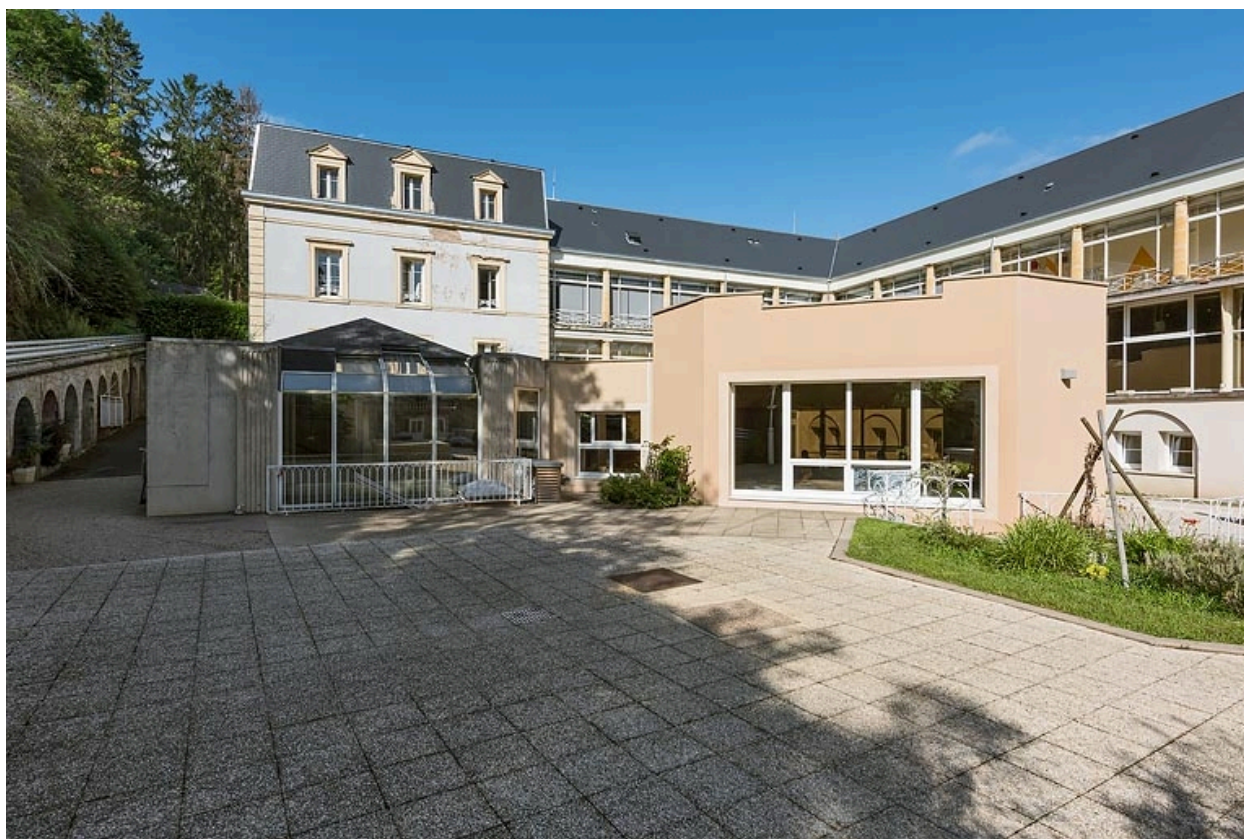
Cour des bains avec ses extensions récentes (piscine et couloir de marche).
