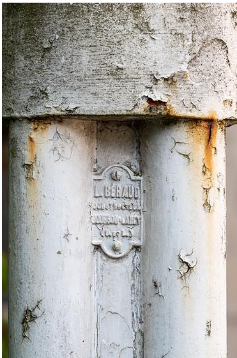
Lampadaire à l'origine entre les deux bassins de refroidissement, plaque (L. Béraud).
