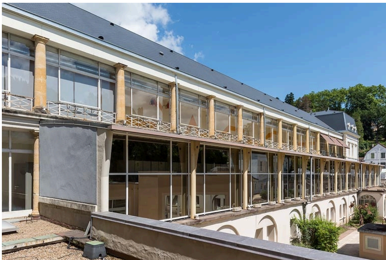
Extension récente devant la façade nord.
