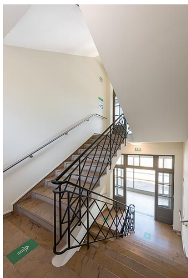
Escalier de l'aile ouest. Phot. Pierre-Marie Barbe-Richaud IVR26_20217100198NUC4A
