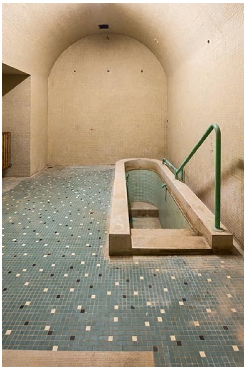
Ancienne cabine de bain, au rez-de-chaussée.
