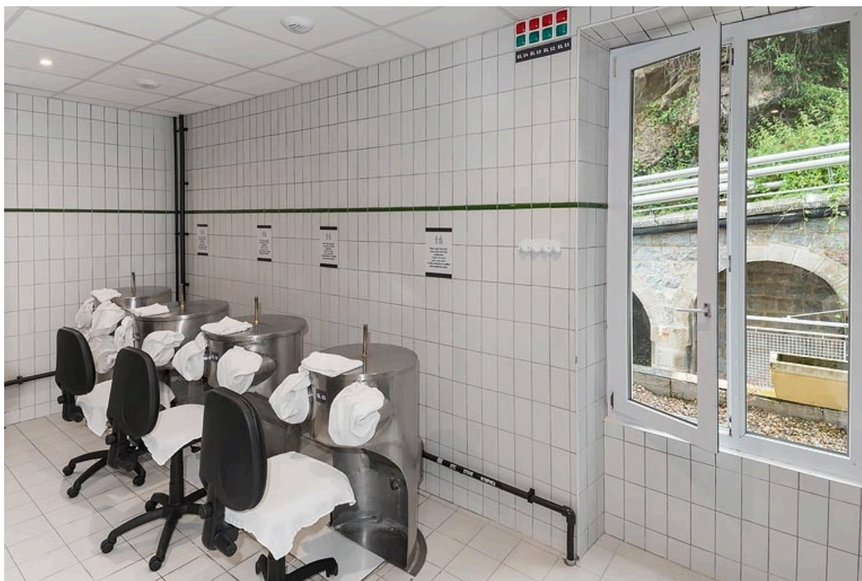
Étuves locales, au rez-de-chaussée (pavillon annexe de 1897).
