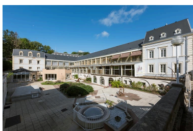
Vue d'ensemble de l'établissement thermal depuis l'Est. Phot. Pierre-Marie Barbe-Richaud IVR26_20217100183NUC4A
