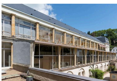
Extension récente devant la façade nord. Phot. Pierre-Marie Barbe-Richaud IVR26_20217100196NUC4A
