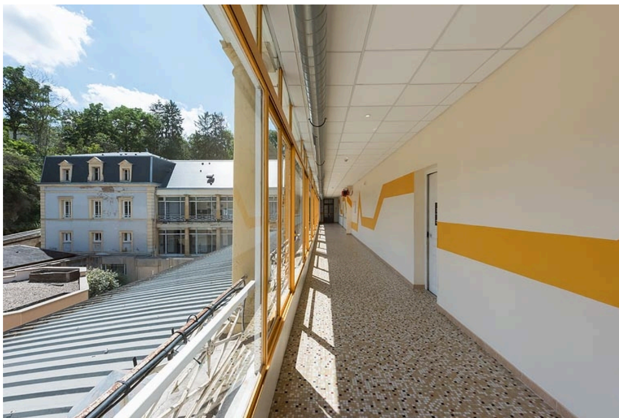
Galleries du deuxième étage.
