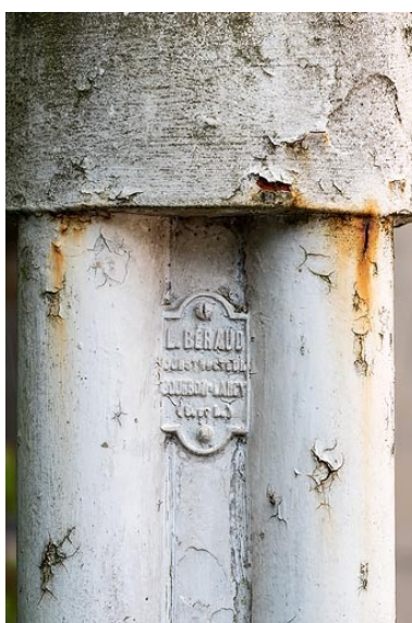
Lampadaire à l'origine entre les deux bassins de refroidissement, plaque (L. Béraud). Phot. Pierre-Marie Barbe-Richaud IVR26_20217100186NUC4A
