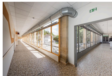
Galleries du deuxième étage. Phot. Pierre-Marie Barbe-Richaud IVR26_20217100200NUC4A
