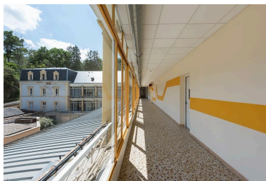
Galleries du deuxième étage. Phot. Pierre-Marie Barbe-Richaud IVR26_20217100204NUC4A
