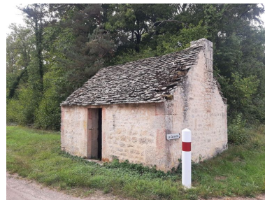
Vue de l'élévation nord de la cabane. Phot. Baptiste Quost IVR26_20232100291NUC1A
