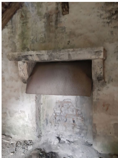
Vue de la cheminée adossée au mur pignon nord. Phot. Baptiste Quost IVR26_20232100293NUC1A
