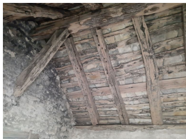
Détail de la charpente et de la sous-face en planches de la couverture en laves. Phot. Baptiste Quost IVR26_20232100295NUC1A
