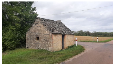
Vue de l'élévation sud de la cabane. Phot. Baptiste Quost IVR26_20232100289NUC1A
