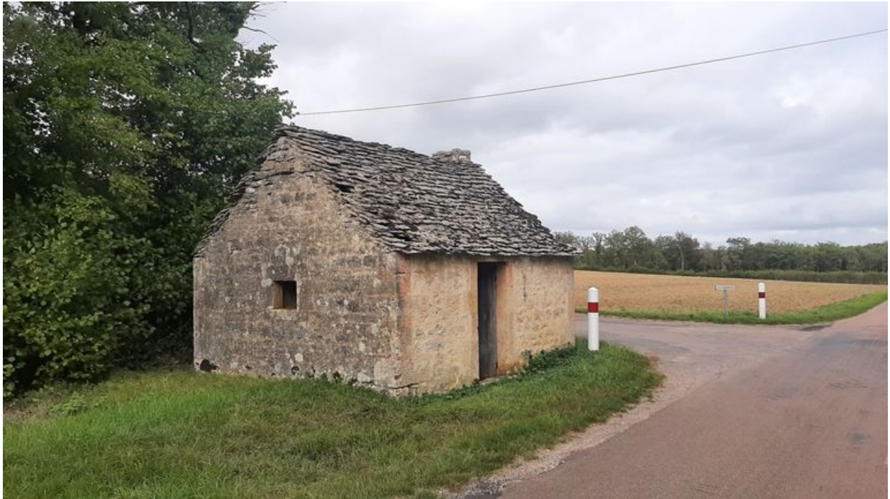
Vue de l'élévation sud de la cabane.
