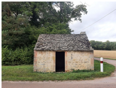
Vue de l'élévation sud de la cabane. Phot. Baptiste Quost IVR26_20232100290NUC1A
