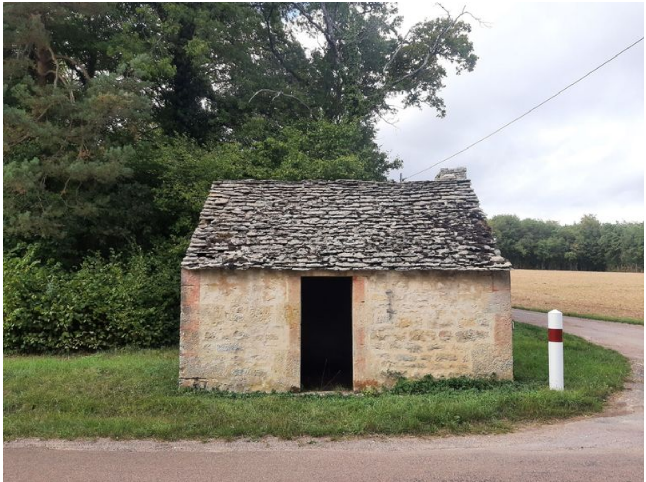
Vue de l'élévation sud de la cabane.
