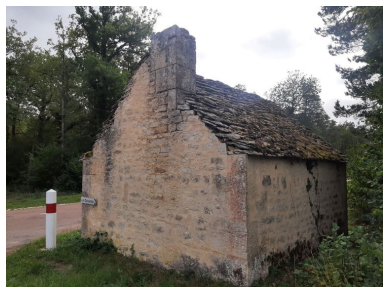
Vue de l'élévation ouest de la cabane. Phot. Baptiste Quost IVR26_20232100292NUC1A
