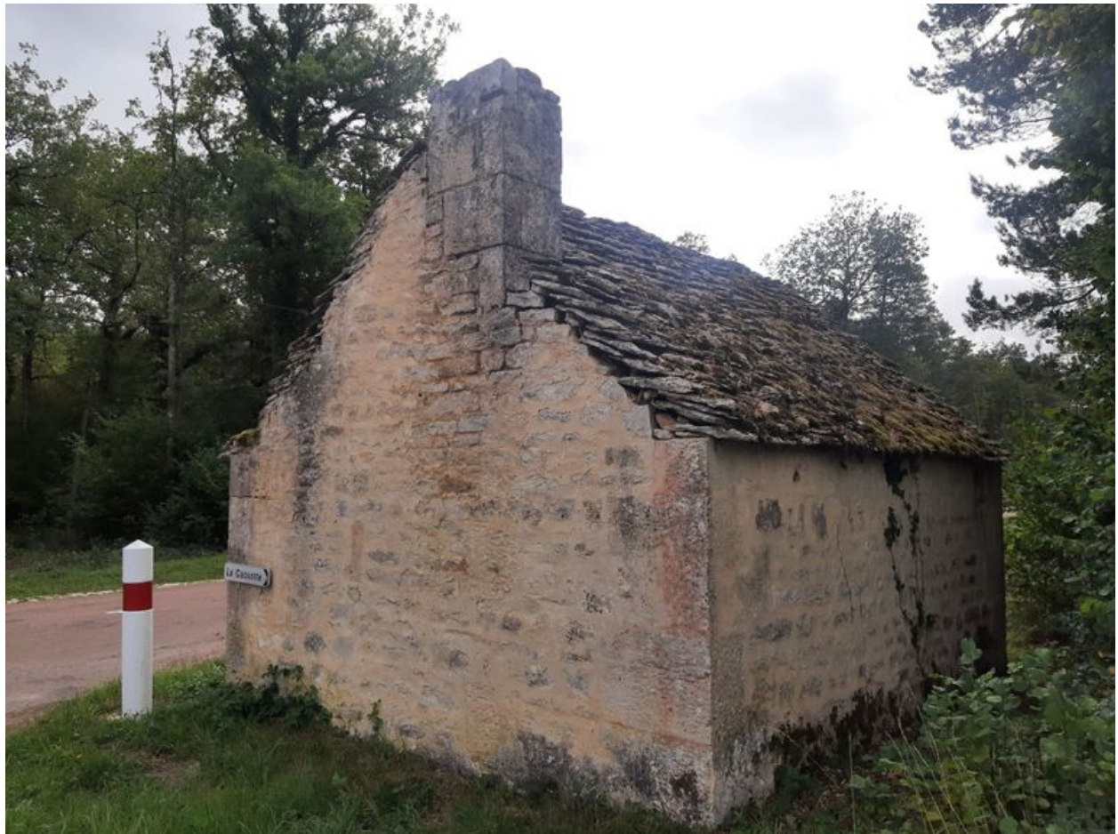
Vue de l'élévation ouest de la cabane.
