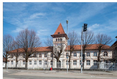
Façade sud du bâtiment administratif. Phot. Jérôme Mongreville IVR43_20172500329NUC4A
