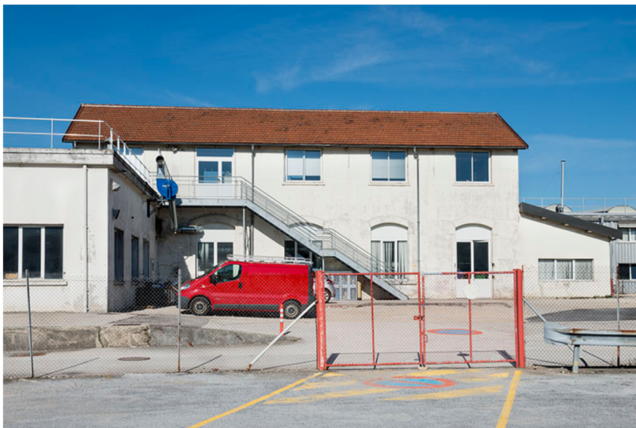
Atelier de mécanique (fonction originelle).
