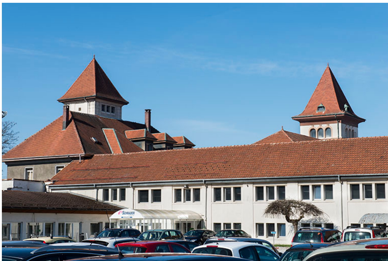
Bâtiments sud : conciergerie, bureaux, vestiaires.
