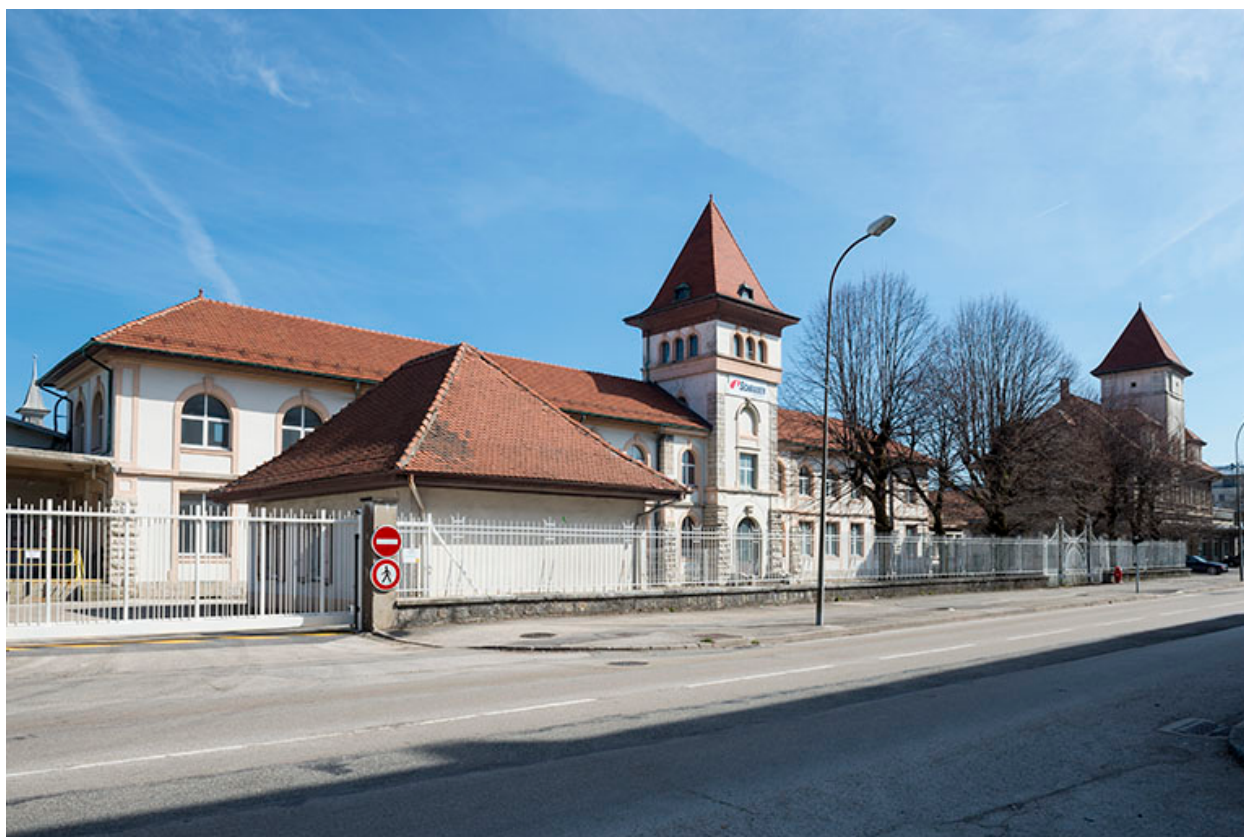
Bâtiments d'entrée, depuis l'ouest.
