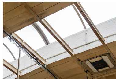
Détail du système d'éclairage zénithal (briques pleines sur ossature métallique). Phot. Jérôme Mongreville IVR43_20162501591NUC4A
