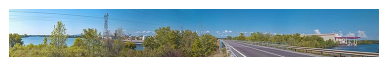
Vue d'ensemble des deux darses depuis le pont. Phot. Thierry Kuntz IVR26_20207100371NUC4A
