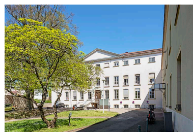
Façade principale de l'hôtel d'Igé. Phot. Aline Thomas IVR26_20257100414NUC4A
