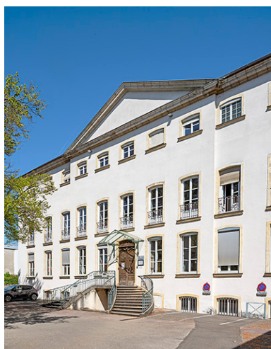
Façade principale de l'hôtel d'Igé. Phot. Aline Thomas IVR26_20257100415NUC4A
