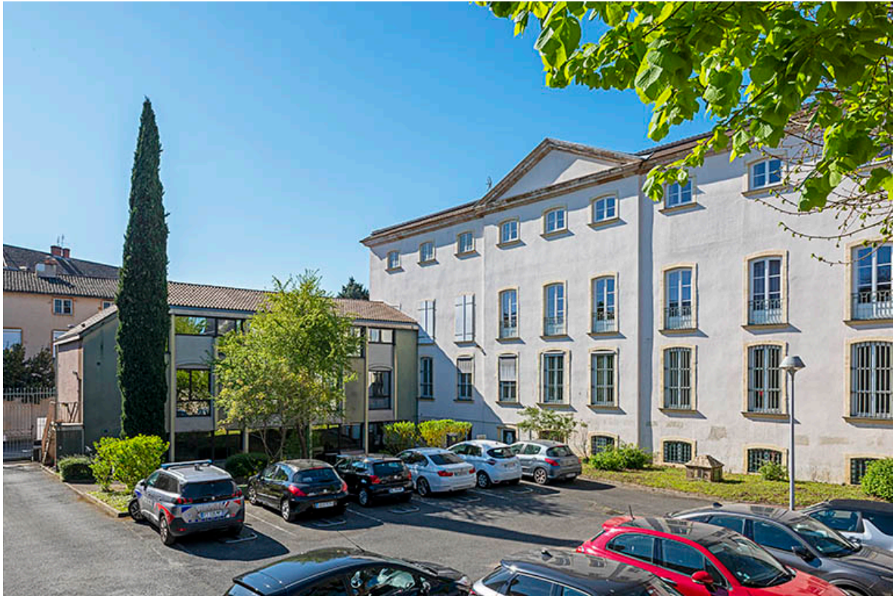
Façade nord est de l'hôtel d'Igé et extension (à gauche).
