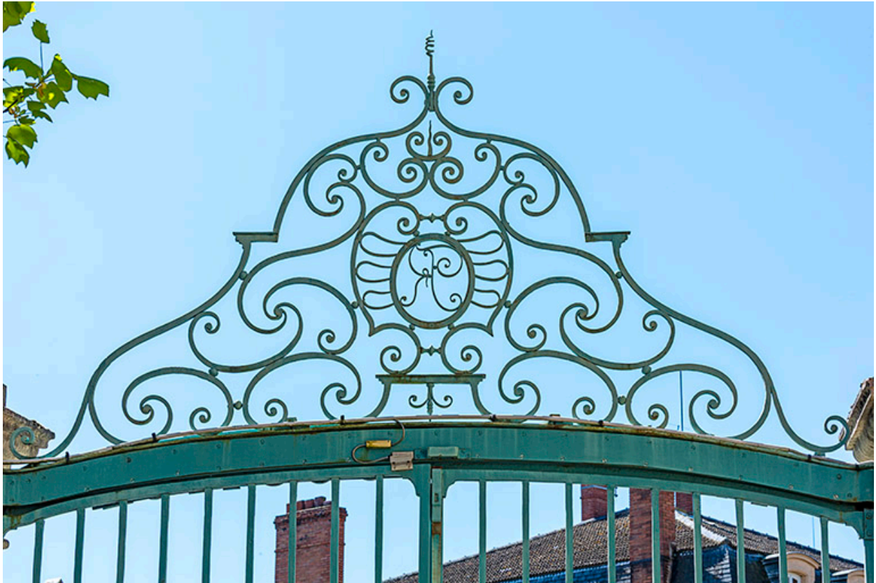
Fronton ajouré de la grille, vu depuis la cour.
