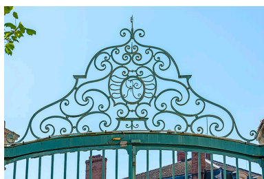
Fronton ajouré de la grille, vu depuis la cour. Phot. Aline Thomas IVR26_20257100412NUC4A
