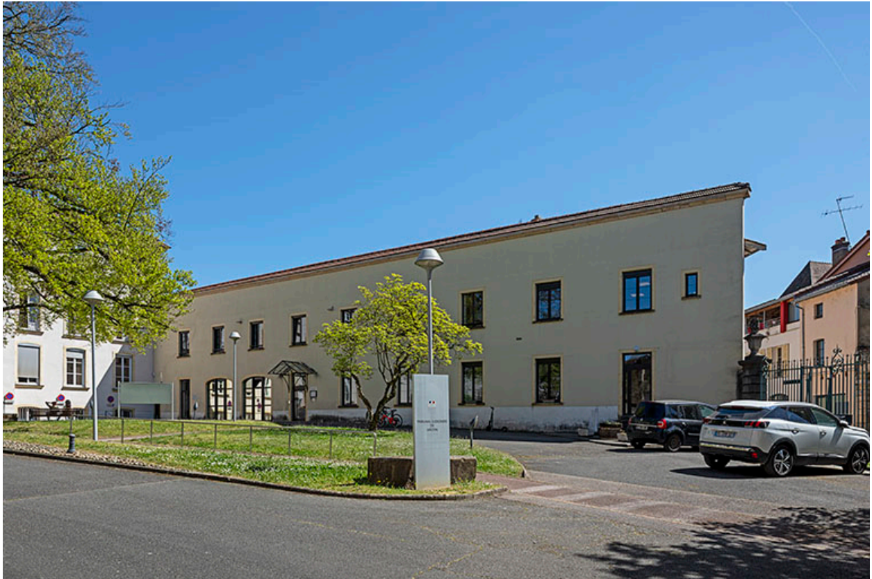
Extension sud, dans la cour avant.
