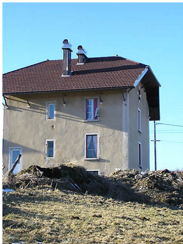
Façade postérieure. Phot. Marie-Pierre Reynet IVR43_20083900474NUC1A
