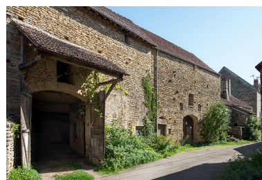
La rue Varet. Phot. Nicolas Waltefaugle IVR26_20258900277NUC4A
