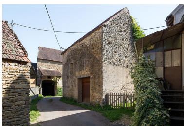
La rue Varet. Phot. Nicolas Waltefaugle IVR26_20258900276NUC4A
