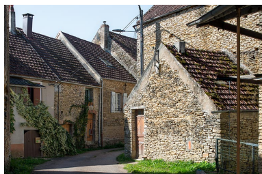
La rue Varet. Phot. Nicolas Waltefaugle IVR26_20258900278NUC4A
