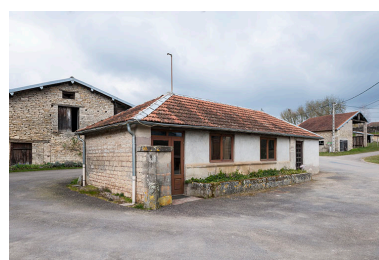
Le lavoir transformé en remise. Phot. Jérôme Mongreville IVR43_20167000210NUC4A
