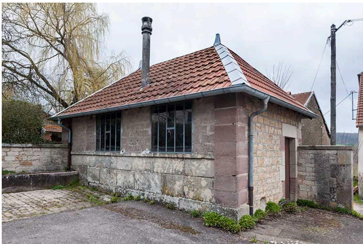
Le lavoir, transformé en local municipal.
