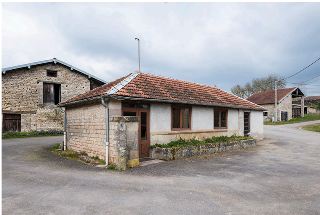
Le lavoir transformé en remise.
