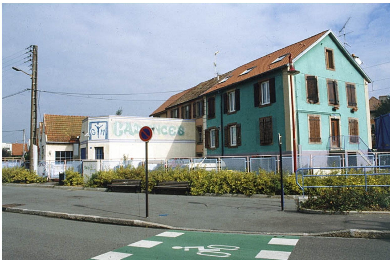
Ateliers et logements depuis le sud.
