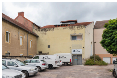
Façades latérale droite et postérieure. Phot. Pierre-Marie Barbe-Richaud IVR26_20257100949NUC4A
