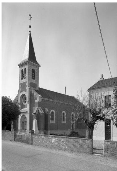
Elévations antérieure et droite Phot. Jean-Luc Duthu IVR26_19852100602V
