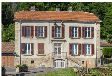
Rue Thiers, façade de la demeure n° 106. Phot. Jérôme Mongreville IVR43_20217000351NUC4A
