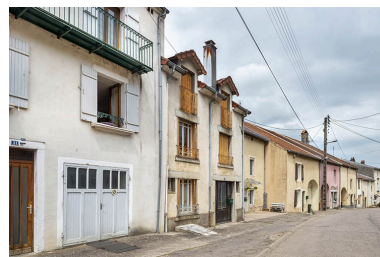
Rue Thiers, alignement du côté impair devant le n° 31, vue vers le nord-est. Phot. Jérôme Mongreville IVR43_20217000354NUC4A
