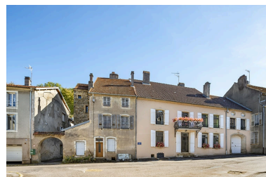
Alignement du côté pair de la rue Thiers (n° 2 à 6). Phot. Jérôme Mongreville IVR43_20217000681NUC4A
