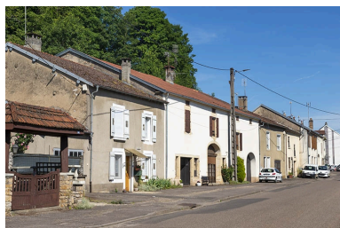
Rue Thiers, alignement des façades du côté pair vers le nord-ouest, à hauteur du n° 102. Phot. Jérôme Mongreville IVR43_20217000350NUC4A
