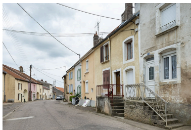
Rue Thiers, alignement du côté pair devant le n° 36, vue vers le nord-est. Phot. Jérôme Mongreville IVR43_20217000358NUC4A
