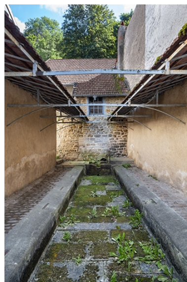
Rue Thiers, la fontaine-lavoir dite de la Jacquemotte (intérieur). Phot. Jérôme Mongreville IVR43_20217000573NUC4A
