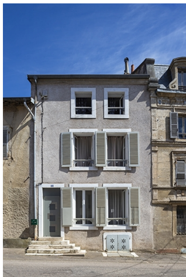
Rue Thiers, façade de la maison n° 22. Phot. Jérôme Mongreville IVR43_20217000335NUC4A
