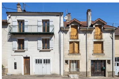
Rue Thiers, façades des maisons n° 31 et 33. Phot. Jérôme Mongreville IVR43_20217000686NUC4A
