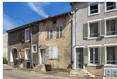
Rue Thiers, alignement du côté pair devant le n° 22, vue vers le nord-est. Phot. Jérôme Mongreville IVR43_20217000685NUC4A
