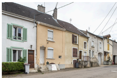
Rue Thiers, alignement du côté pair devant le n° 44, vers le sud-ouest. Phot. Jérôme Mongreville IVR43_20217000356NUC4A
