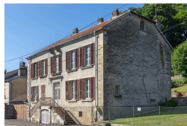
Rue Thiers, trois quarts de la demeure n° 106. Phot. Jérôme Mongreville IVR43_20217000352NUC4A
