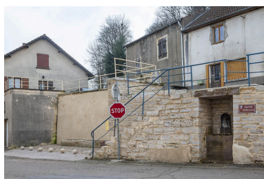
Rue Thiers, trois quarts droit de la fontaine dite Petite fontaine et de l'abreuvoir, à hauteur du n° 74. Phot. Jérôme Mongreville IVR43_20227000052NUC4A
