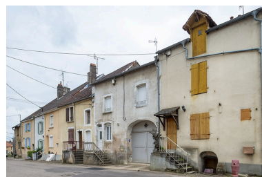
Rue Thiers, alignement du côté pair devant le n° 34, vue vers le nord-est. Phot. Jérôme Mongreville IVR43_20217000344NUC4A
