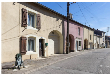
Rue Thiers, alignement du côté impair devant le n° 35, vue vers le nord-est. Phot. Jérôme Mongreville IVR43_20217000343NUC4A
