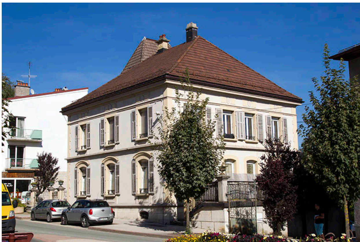
Façades antérieure et latérale droite.
