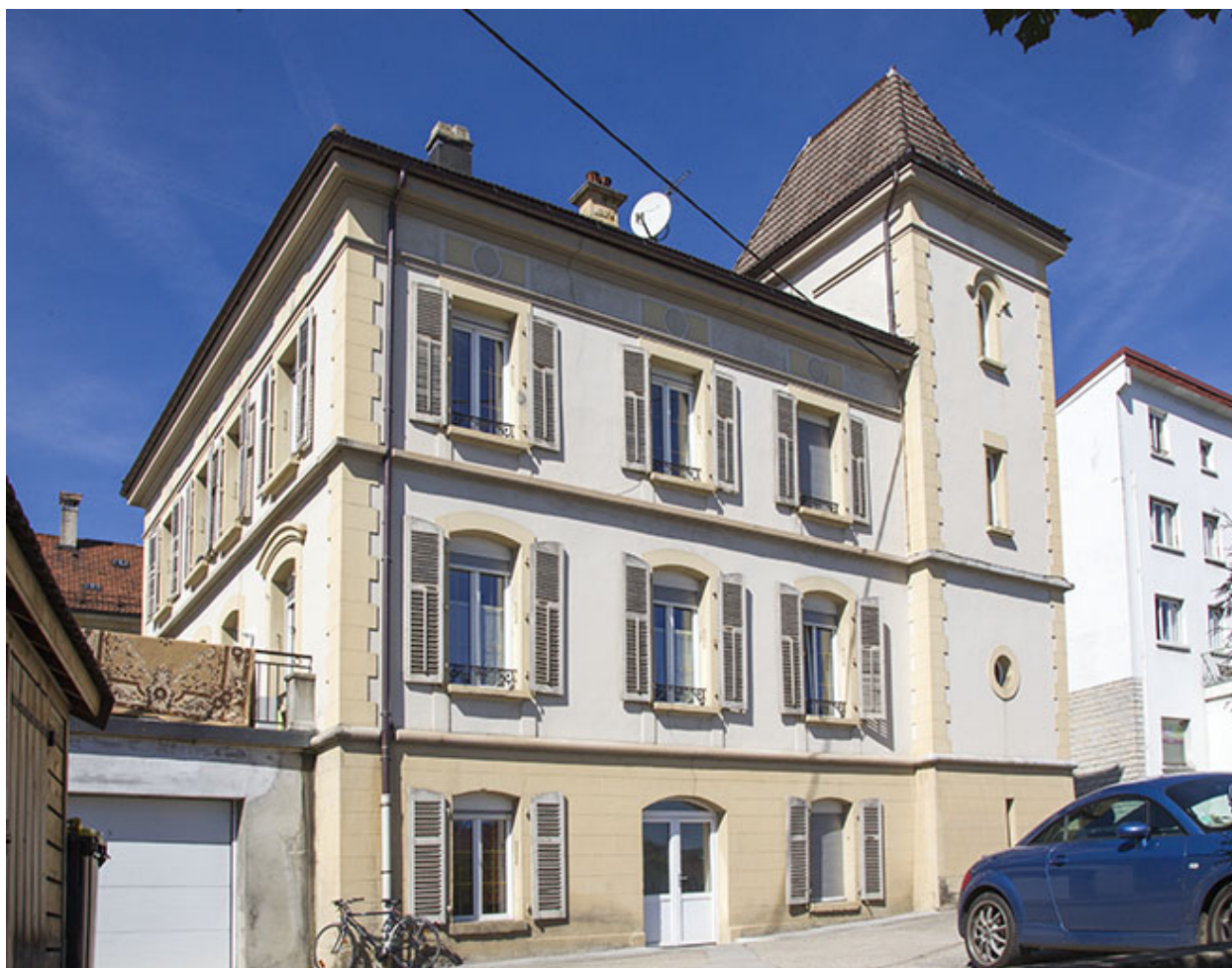
Façades postérieure et latérale droite.
