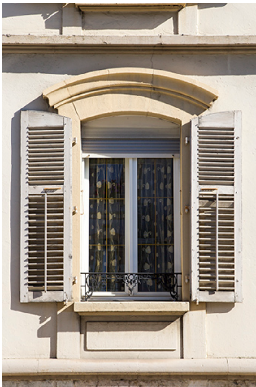
Façade antérieure : fenêtre du rez-de-chaussée.
