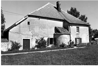
Face latérale gauche. Phot. Yves Sancey IVR43_19802500935X
