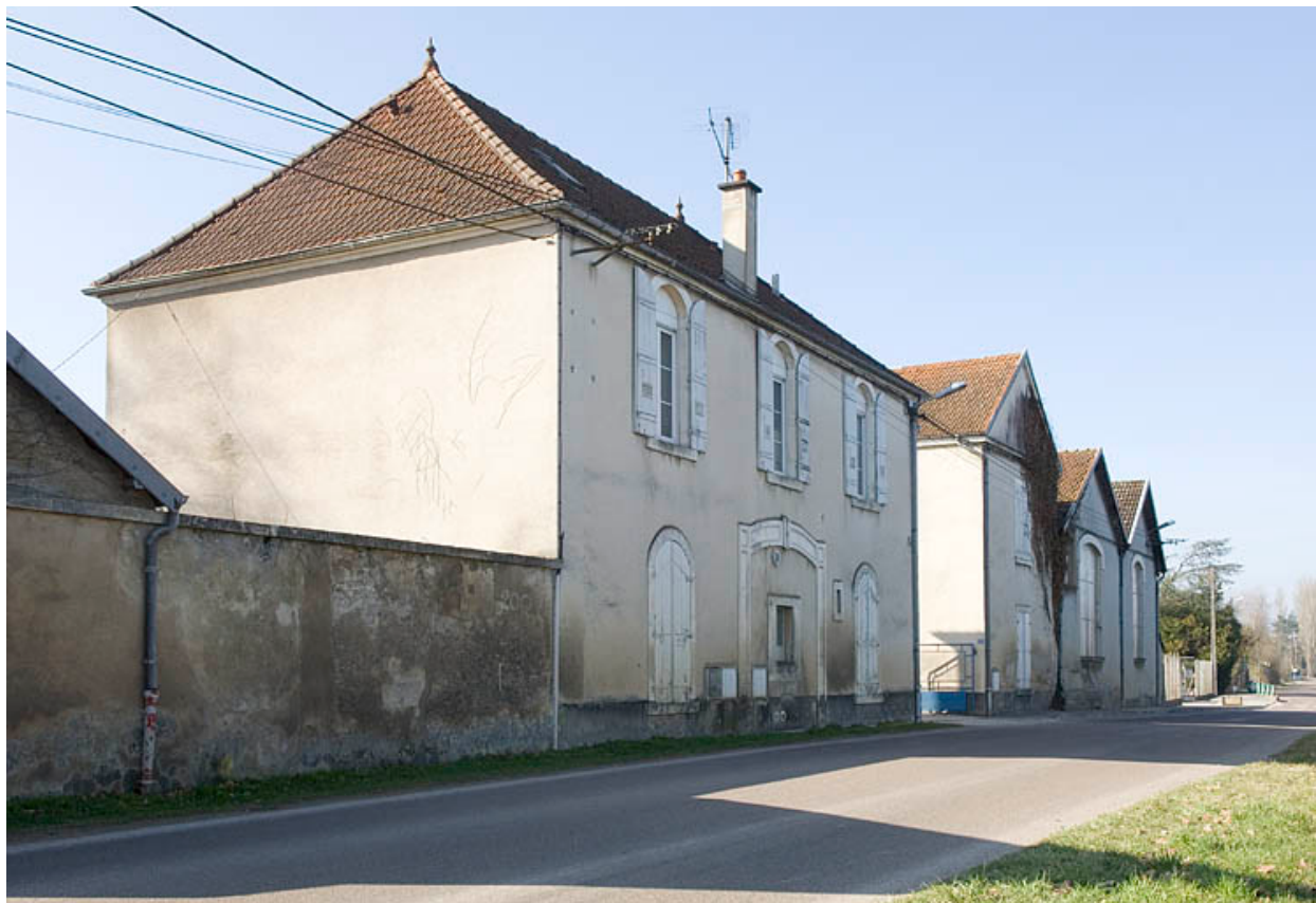
Vue d'ensemble depuis le quai Mavia.
