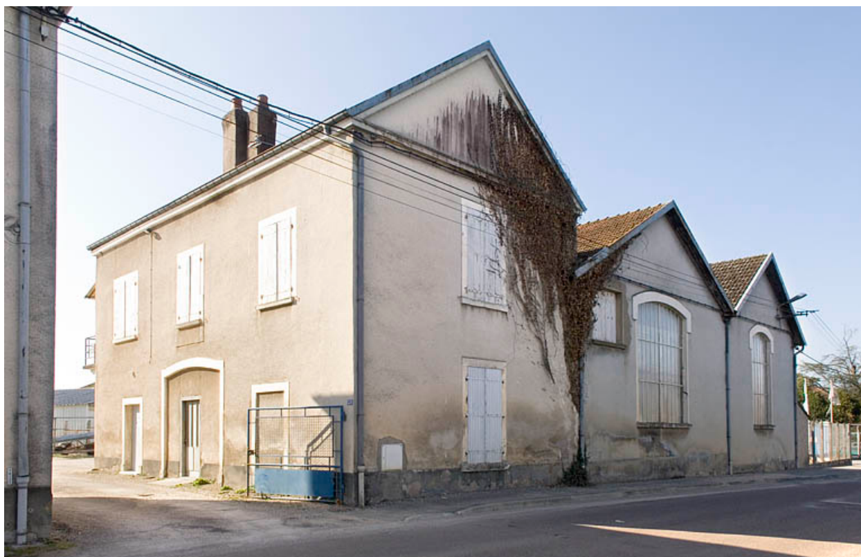
Bâtiments industriels. Logement, entrepôt et atelier.
