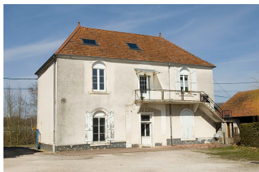
Logement patronal et bureau. Façade sud. Phot. Jérôme Mongreville IVR43_20097000200NUC2A
