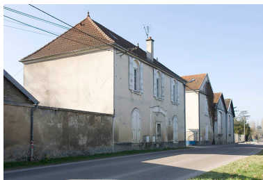
Vue d'ensemble depuis le quai Mavia. Phot. Jérôme Mongreville IVR43_20097000204NUC2A
