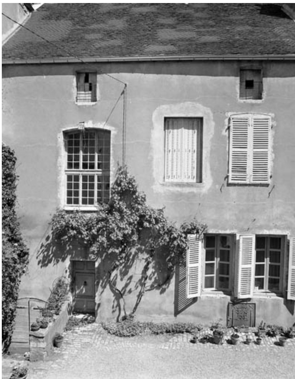
Façade postérieure de l'édifice principal.
