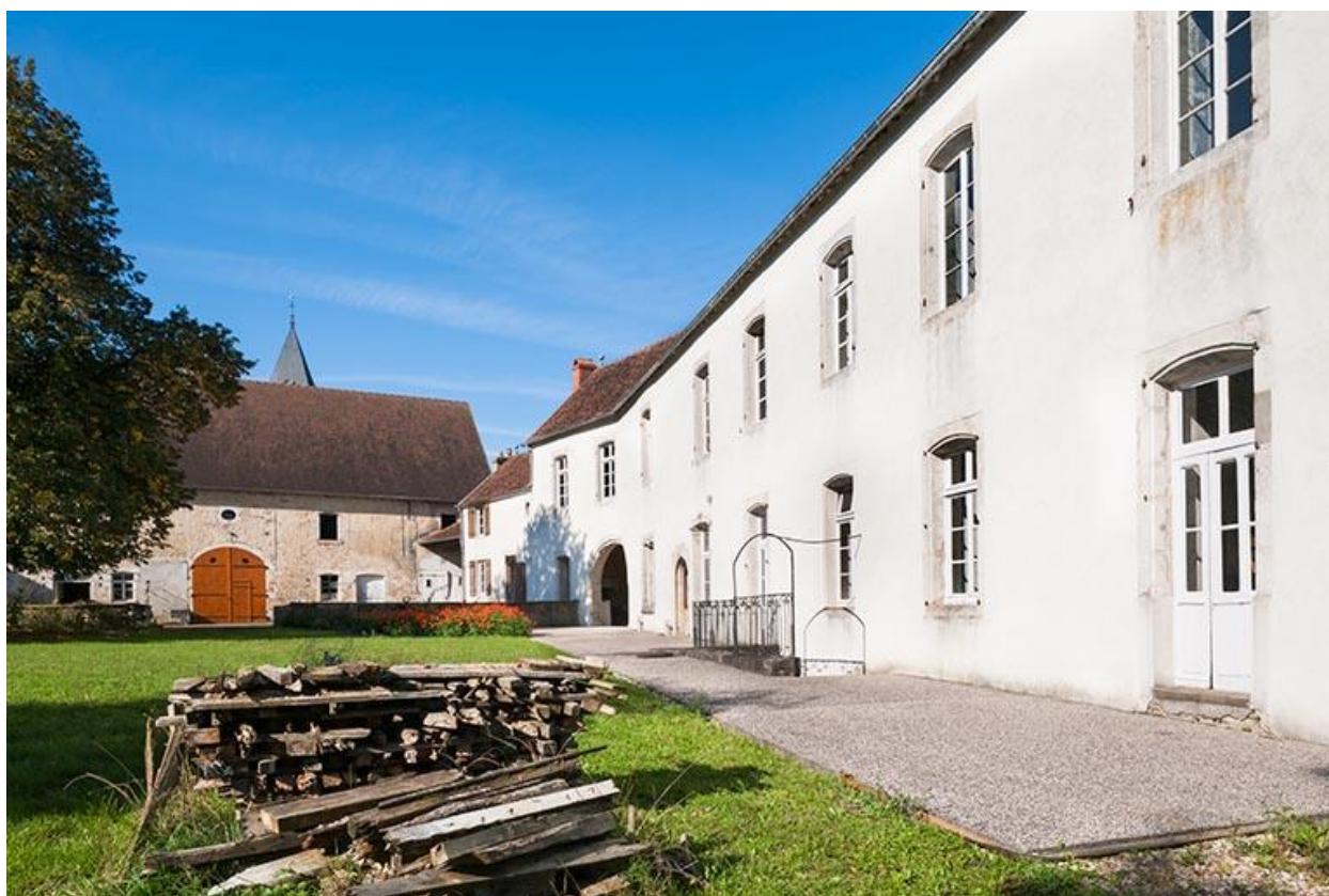
Vue d'ensemble sud-est
