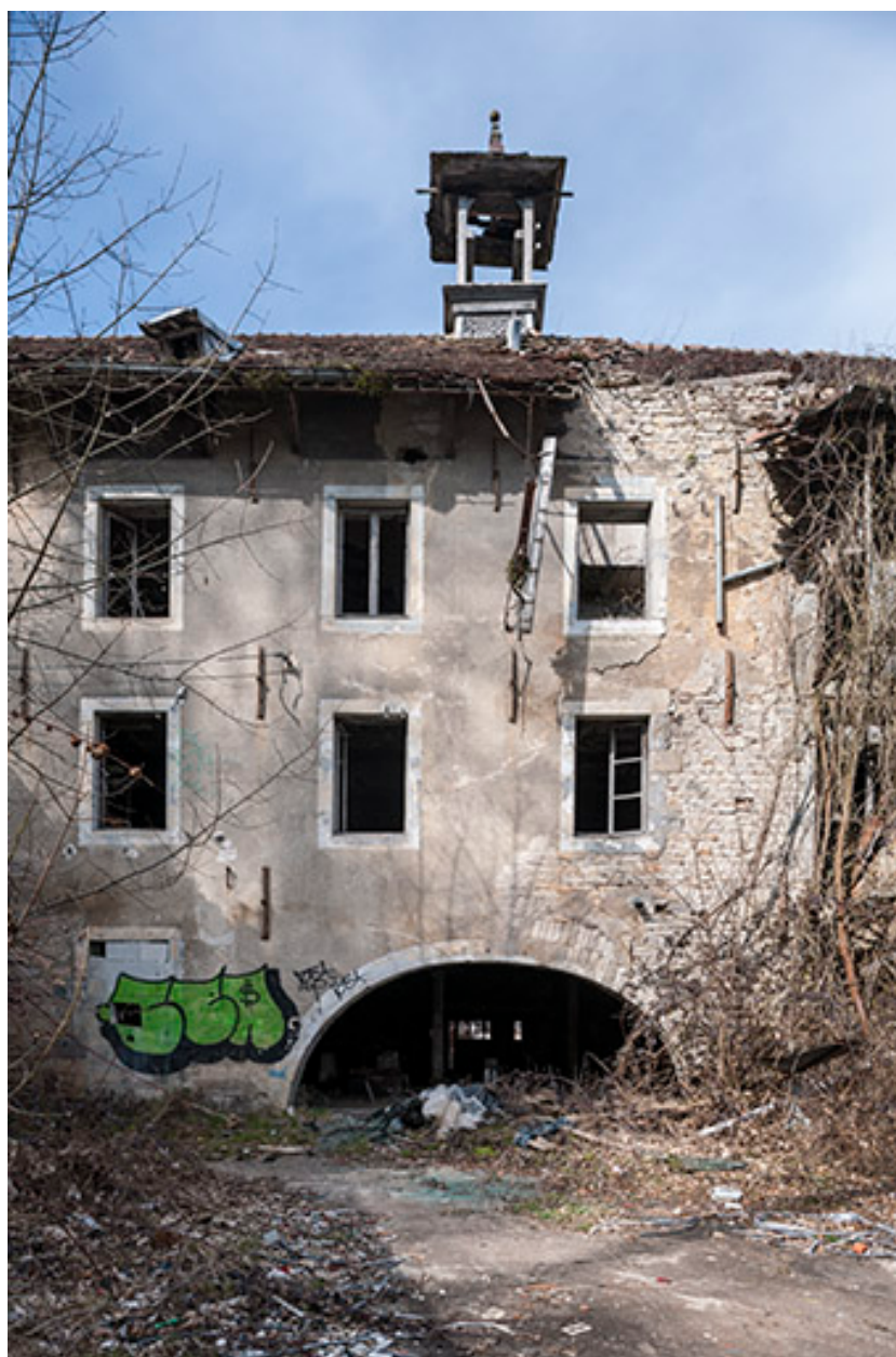
Façade sud de l'atelier principal.
