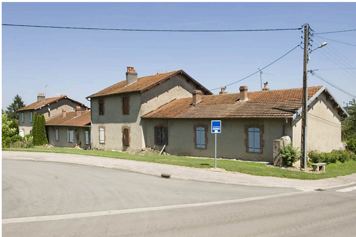
Logements ouvriers contigus. Vue depuis le sud.
