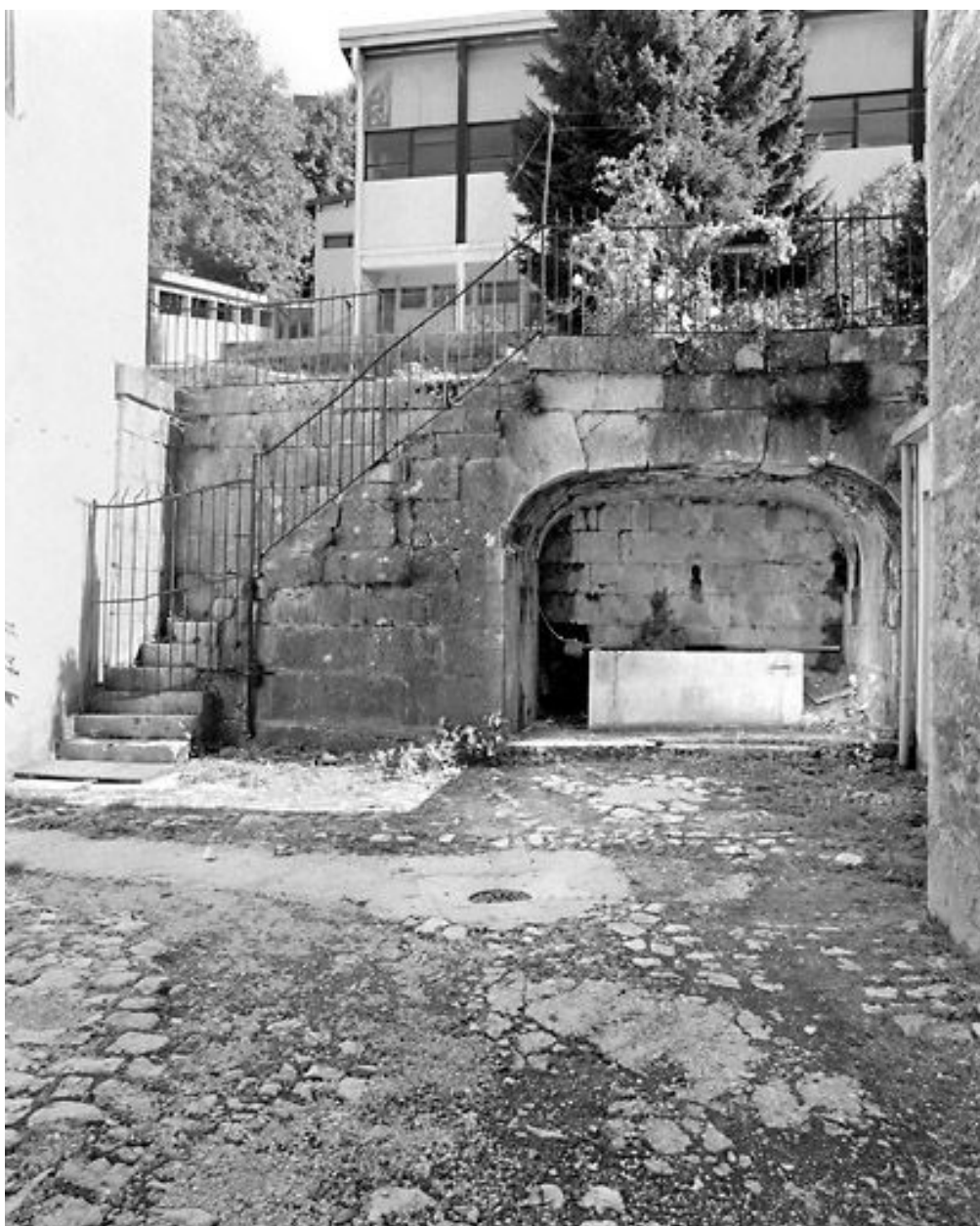
Fontaine, escalier isolé et mur de soutènement.
